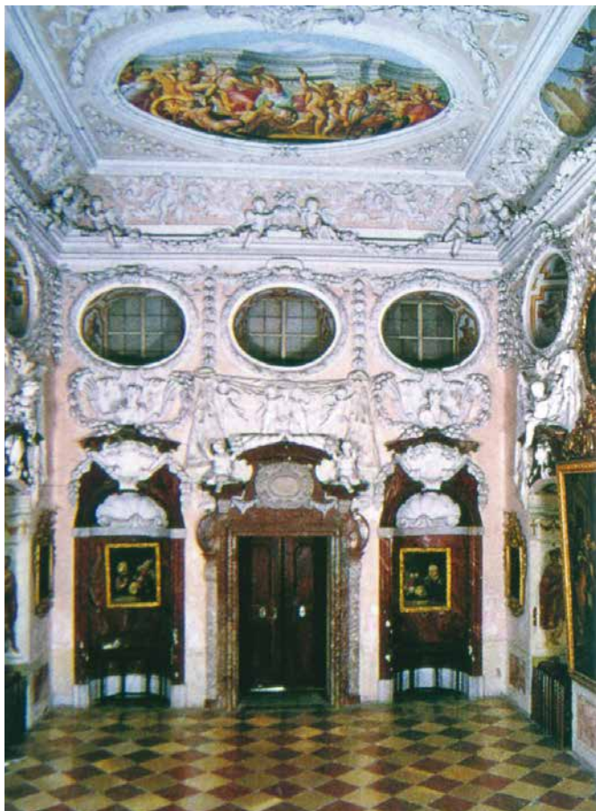
9. Schlierbach (Horné Rakúsko), cisterciánsky kláštor, Sála sv. Bernarda. Stav v roku 1977 s bielym náterom reliéfnej štuky na ružovom podklade, ponechané však červenasto mramorované štukolustrové profily nad okennými výklenkami a kozubom, ako aj ostenia dverí a kozuba z prírodného lešteného mramoru. Foto: E. Mejchar.
