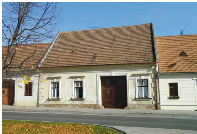
1. Dom na Štúrovej ulici č. 13 v Modre. Foto: autorka.
