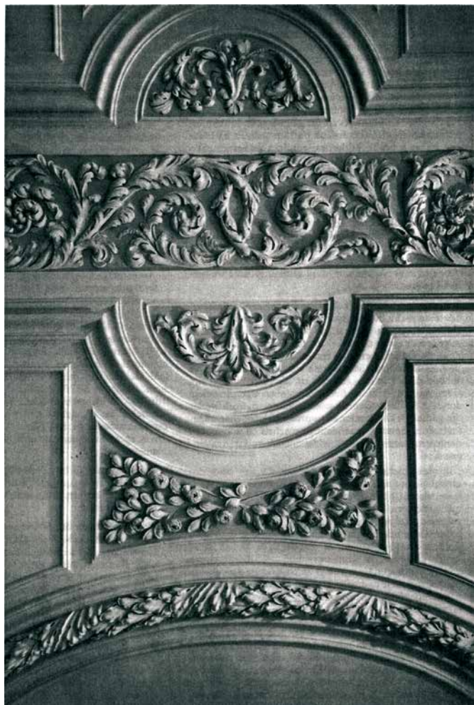
6. Reichenberg, (Horné Rakúsko), kláštor augustiniánov-kanonikov, tzv. Carloneho sála, stropná štukatúra, G. B. Carlone 1691/95. Profily s bielym náterom, biela nenatieraná modelovaná štukatúra na čiastočne v hmote zafarbených ružových podkladových plochách, reštaurovaná 1973. Foto: Bundesdenkmalamt, E. Mejchar.
