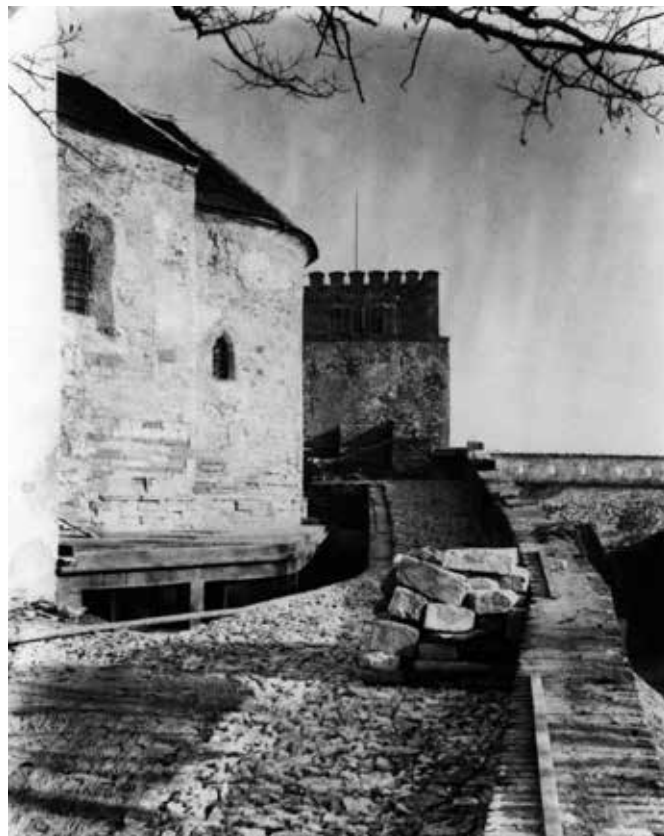
Realizácia betónového krytu nad pohrebiskom a rampy na východné nádvorie (pravdepodobne záver roku 1931). Foto: Archív PÚ SR.
