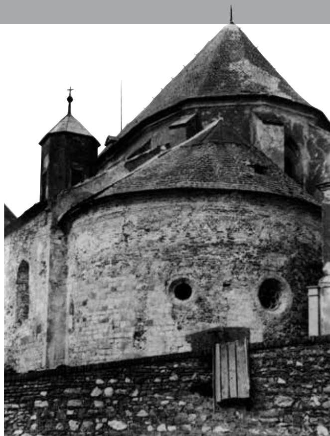
Pohľad na kaplnku z východu (1931). Foto: Archív PÚ SR.
