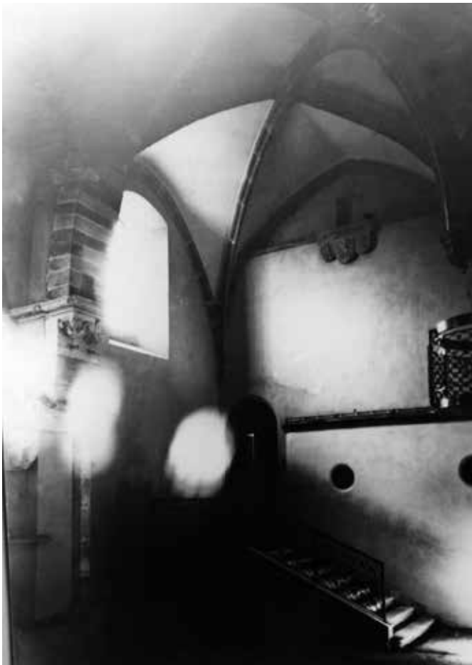
Severná a západná stena lode po pamiatkovej obnove (1933). Foto: Archív PÚ SR.
