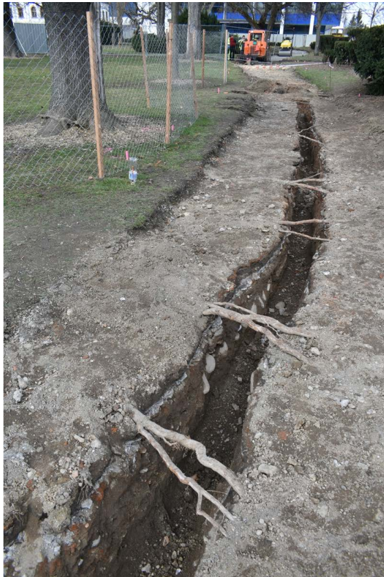
► Obr. 6. Ručne realizované výkopové práce v parku.
