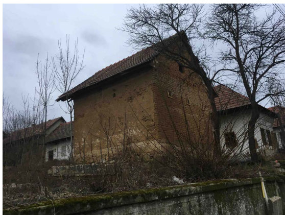
► Obr. 10. Celkový pohľad na objekt z nepálenej tehly pred asanáciou, 2022, Ladice.
