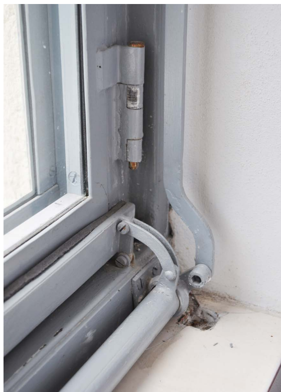
►► Obr. 49, 50, 51. Detaily oceľového skladacieho okna po reštaurovaní, Bývalá hospodárska škola, Nitra.
