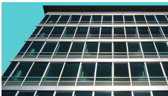
► Obr. 84. Hotel Daniel (bývalá budova farmaceutickej firmy Hoffmann-La Roche), fasáda po obnove, Viedeň.
