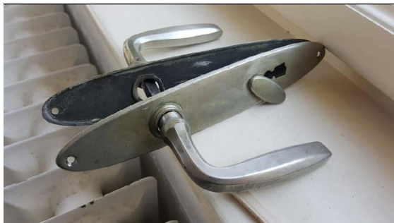
► Obr. 58, 59. Obnova okien a dvier, Vila K, Nitra
