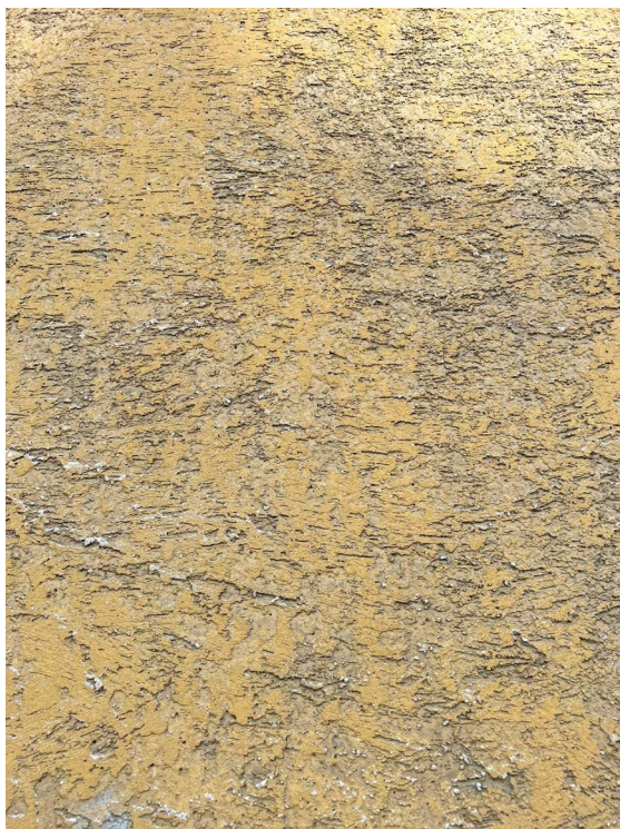
► Obr. 7, 8, 9. Ukážky zo širokej škály rôznych štruktúr a farebnosti tvrdých fasádnych omietok budov z 20. – 30. rokov 20. storočia, ktoré dokladajú vyspelosť ručnej remeselnej práce.
