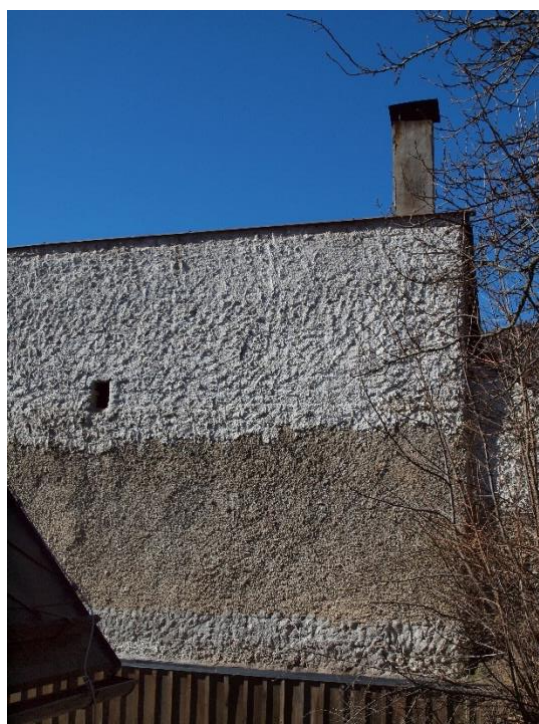
Obr. 35. Tmavší pás je staršia striekaná hrubozrnná omietka bez náteru. Úzky pás pod ním a široký pás nad ním sú výsledkom nie veľmi úspešnej novodobej snahy o scelenie plochy steny rovnakým typom omietky.
