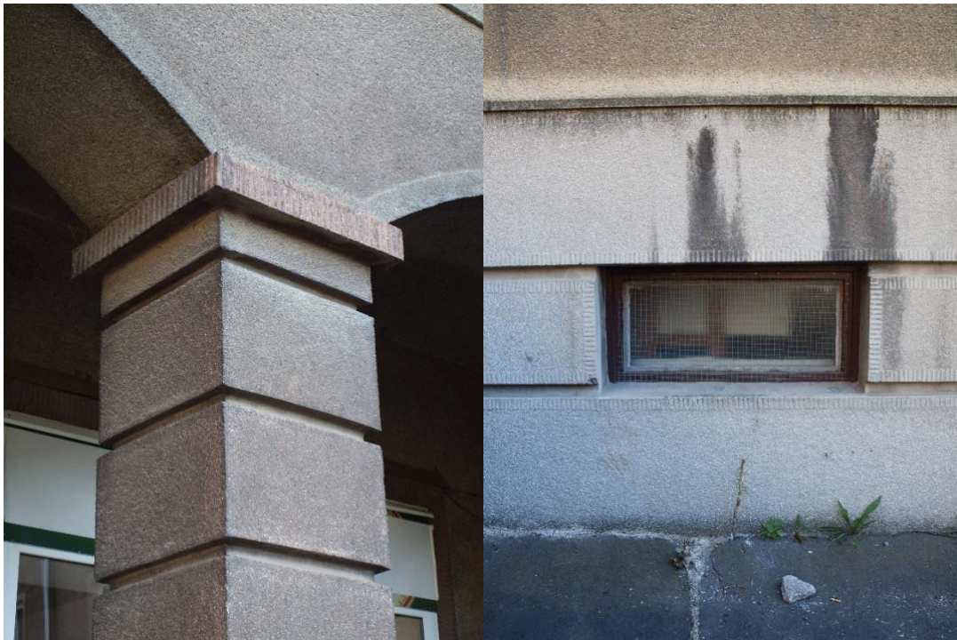
Obr. 38, 39. Omietka z umelého kameňa, tiež označovaná ako terazzová [ teracová ] omietka – z technického hľadiska ide o cementovú omietku s kamenárskou povrchovou úpravou.
