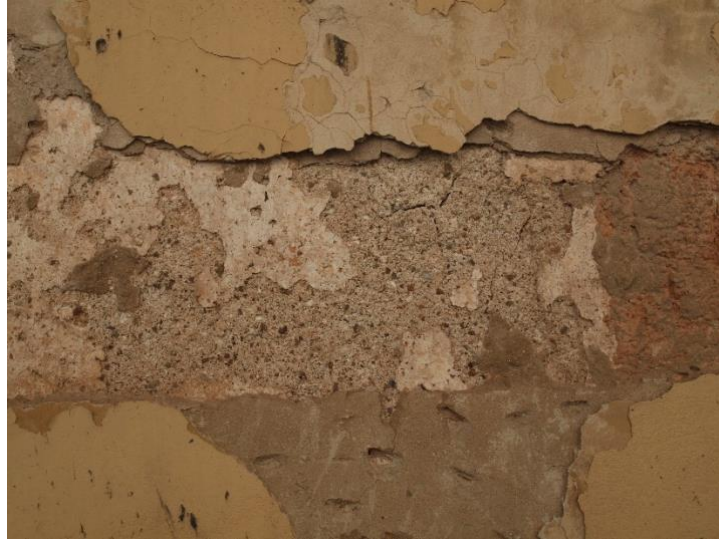
Obr. 42. Na najstaršej omietkovej vrstve, odkrytej odlúpnutím mladších prekryvajúcich vrstiev a jej vápenného náteru, vidieť farebne rôznorodý piesok v malte. Biele hrudky vápna sa považujú za dôkaz použitia tzv. horúcej vápennej malty.
