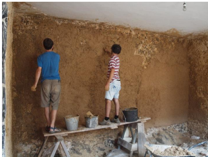
Obr. 36. S hlinenou maltou sa dá pracovať aj holými rukami, bez použitia ochranných rukavíc a murárskeho náradia na rozdiel od vápenej, vápenno-cementovej alebo cementovej malty, ktorých spojivá sú žieraviny.
