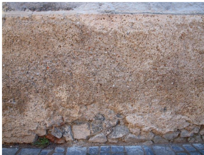
Obr. 41. Omietka so zvetraným povrchom, vďaka čomu vidieť použitie farebne rôznorodého piesku v malte.
