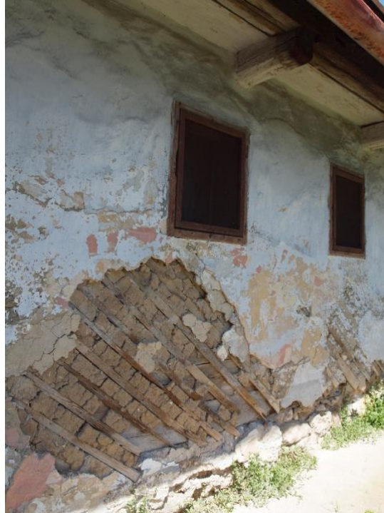
Obr. 37. Hlinená omietka na drevenej zrubovej stene nanosená diagonálne naklincovaným latovým roštom. Hlinená omietka je dvojvrstvová: prvá vrstva bola nanosená do roviny s latami nosného roštu, druhá vrstva ho prekryla. Neskôr bola fasáda preomietnutá vápennou omietkou.
