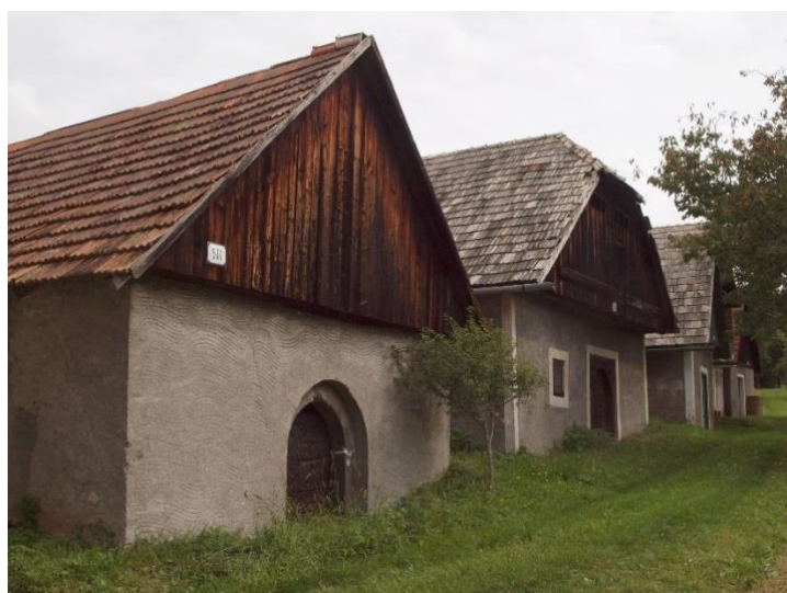
Obr. 31. Na fasáde najbližšej z radu vinohradníckych pivníc je len vyrovnávacia – podkladová vrstva fasádnej omietky, ktorá bola po vyhladení ešte za čerstva zdrsnená vlnovkovými rytými líniami.
