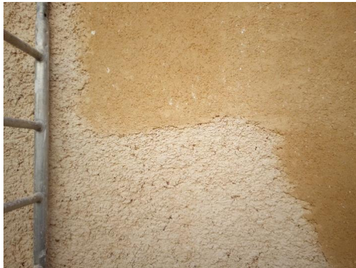
Obr. 28. Nová vápenná omietka: vľavo vyrovnávací podkladová vrstva (tzv. hrubovka) z hrubozrnného piesku (frakcia 0 – cca 4 mm) nahadzovaná so strhávanou úpravou povrchu (za čerstva), vpravo na nej už natiahnutá druhá vrstva z jemnejšieho piesku (frakcia 0 – cca 2 mm) s hladenou a po zatuhnutí zľahka preškrabanou úpravou povrchu.
