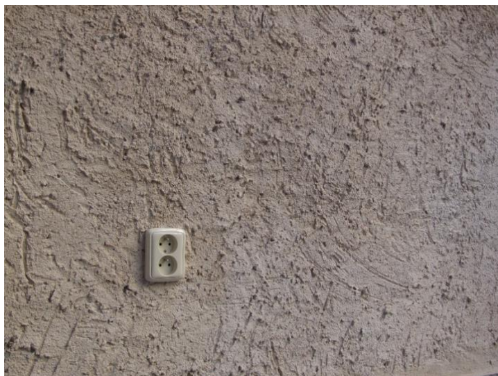
Obr. 34. Nová vápenná omietka z hrubozrnného piesku (frakcia 0 – cca 4 mm) so strhávanou úpravou povrchu.
