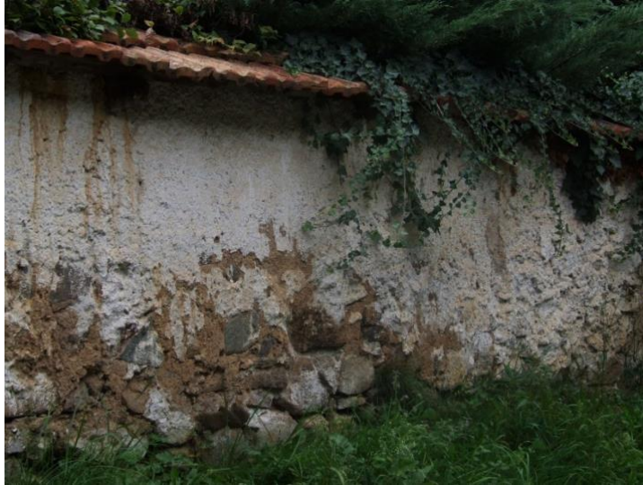
Obr. 32. Tenká jednovrstvová striekaná omietka na kamennom ohradnom múre.
