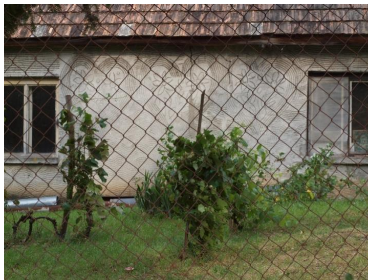
Obr. 29. Vyrovnávací – podkladová vrstva fasádnej omietky, ktorá bola po vyhladení ešte za čerstva zdrsnená rytými líniami. K plánovanému nanieseniu ďalšej – záverečnej vrstvy, pravdepodobne štukovej alebo brizolitovej, už nedošlo.
