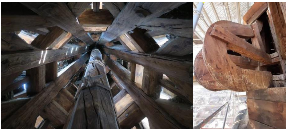
Obr. 7, 8. Vybrané základné konštrukcie krovu, zľava – stĺpik/hrotnica, ramenát/skruž.
