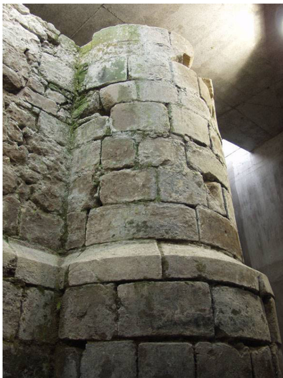
►► Obr. 17. Pásová bosáž z travertínových kvádrov v soklovej časti budovy Generálnej prokuratúry Slovenskej republiky, Jesenského ulica v Bratislave.
