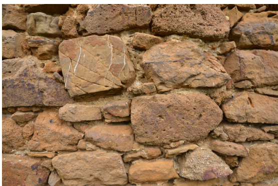
► Obr. 13. Kamenné murivo hradu Čičava z rôznych druhov hornín.
