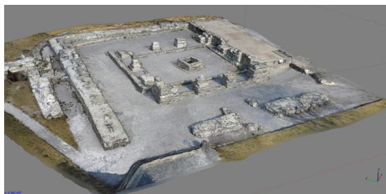
► Obr. 1. Rusovce, rímska stavba.
