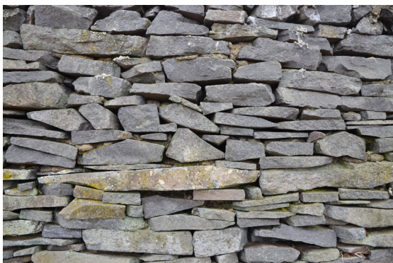
► Obr. 12. Kamenné murivo mosta v Lelesi.
