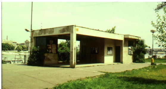
► Obr. 33. Nástupište propeleru, petržalská strana, pred obnovou
