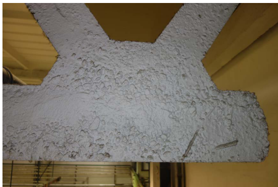
► Obr. 15. Štrkové lôžko prefabrikovaného nosníka, hala Považská Bystrica.
