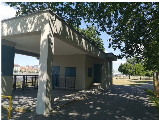
► Obr. 34. Nástupište propeleru, petržalská strana, obnova.
