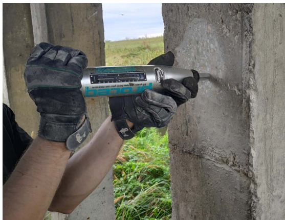
► Obr. 17. Schmidtov tvrdomer Proceq, Šoporňa, most nad potokom Jarčie.
