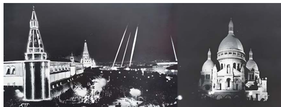
► Obr. 6. Dva základné modely vonkajšieho osvetlenia budov: obrysy objemov (vľavo) a plošné nasvetlenie (vpravo)
