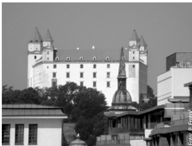
Zrekonštruovaný palác Bratislavského hradu
