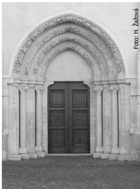
Románsky portál bývalého premonštrátskeho kostola v Šahách po reštaurovaní v roku 2009
