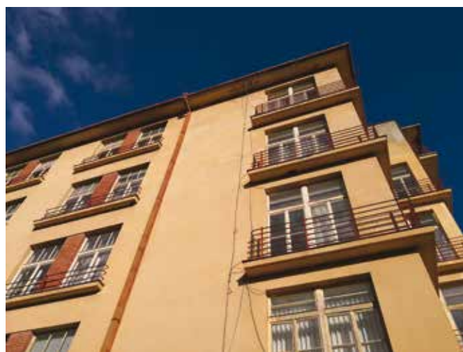
Jubilejný pavilón, 1931. Foto: P. Jackovič.
