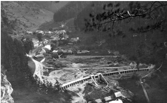
Motyčky (okr. Banská Bystrica), výstavba hornej nádrže vodného diela na Starohorskom potoku, okolo roku 1923/24. Zdroj: Stredoslovenská energetika, a. s.
