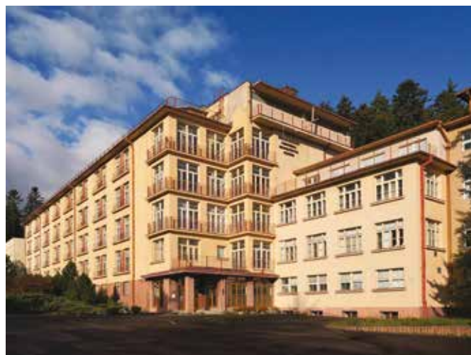
Jubilejný pavilón, 1931. Foto: P. Jackovič.
