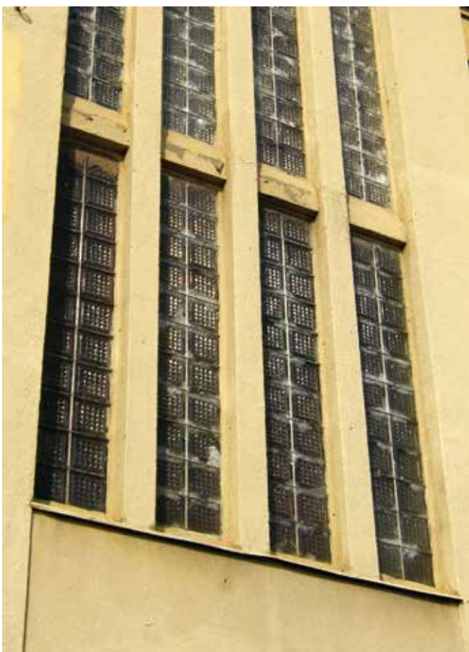
Sklobetónová výplň stredného rizalitu východnej fasády. Foto: I. Tóth.
