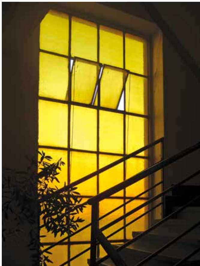
Priestor schodiska s presvetlením medzi 2. a 3. nadzemným podlažím. Foto: I. Tóth.
