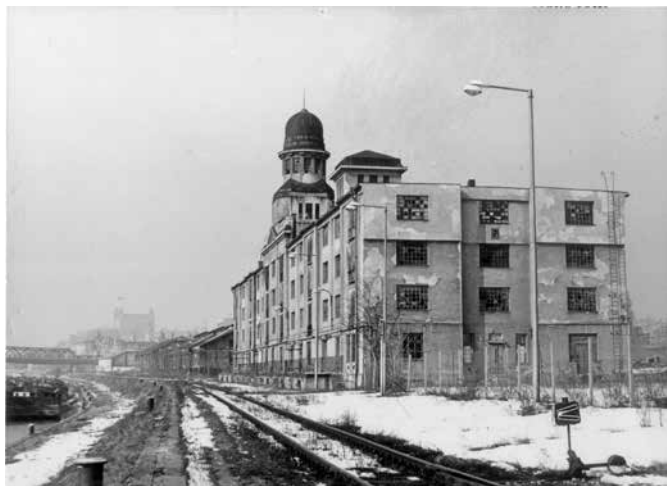
Sklad č. 7 pred obnovou. Zdroj: Archív PÚ SR, Zbierka výskumných správ, sign. T 3793.
