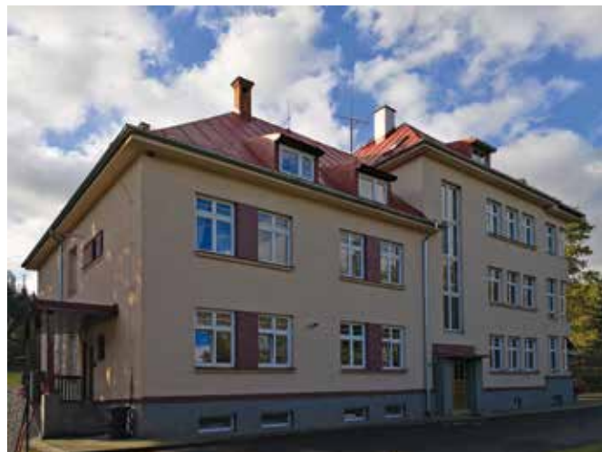
Administratívna budova, 1931. Foto: P. Jackovič.
