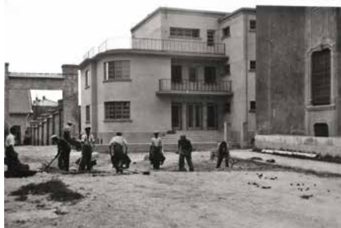
Administratívna budova na Sväto Ondrejskej ul. počas výstavby v roku 1935. Zdroj: Podunajské múzeum Komárno, osobný fond Štefana Csízioho.
