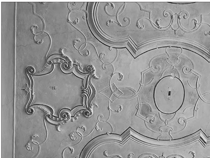
Obr. 14 Štukový strop (m. č. 2.26), detail, foto: E. Sabadošová.
