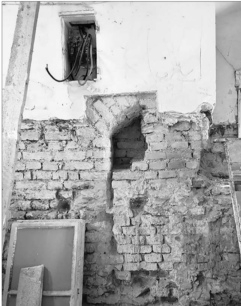
Obr. 5. Odkrytá časť jednoduchej sedílie v západnej časti severnej steny prejazdu (m. č. 1.01), foto: J. Žuffová.
