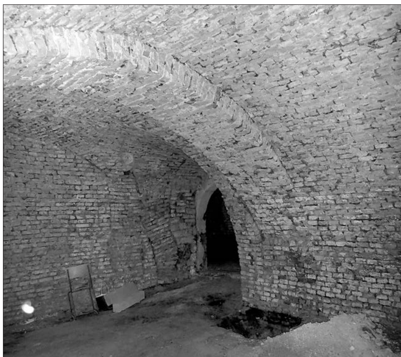
Obr. 12. Suterén B, interiér, pohľad na juhovýchodnú časť priestoru, v popredí statický oblúk ako súčasť pôvodného rovného trámového stropu.
