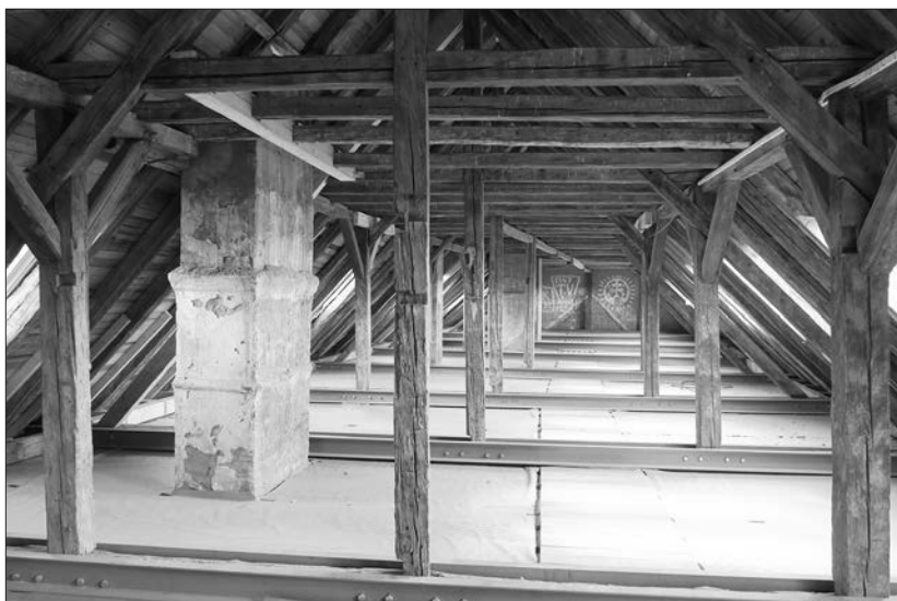
Obr. 3. Podkrovie nad západným krídlom, pohľad od severu.
