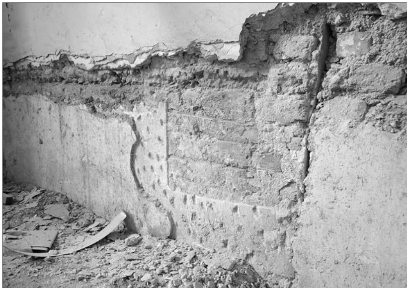
Obr. 15 2. nadzemné podlažie objektu nad suterénom C, južná fasáda, detail povrchu pôvodne režnej, neomietanej steny upravenej mladším typom škárovania.
