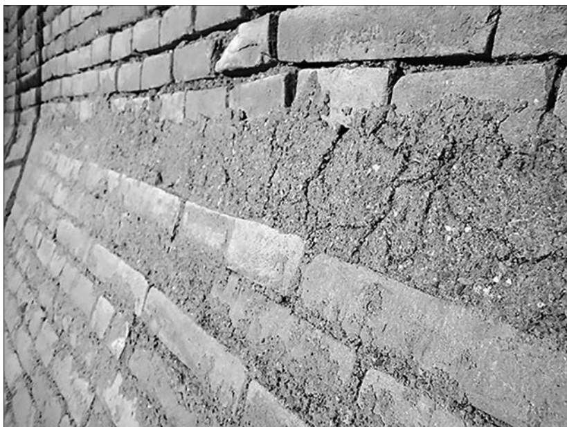
Obr. 7. Styk bornej vertikálnej a spodnej – zošikmenej časti steny. Styk oboch častí je v líci vybladený maltou sklopenou smerom nabor.
