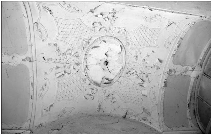
Obr. 12. Stropná výzdoba schodiska, foto: P. Ďurko.
