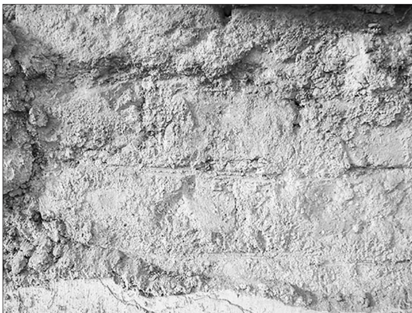
Obr. 3. Nález povrchovej úpravy režného tehlového muriva škárováním na severnej stene poschodia, v miestnosti nad prejazdom (m. č. 2.08), foto: E. Sabadošová.
