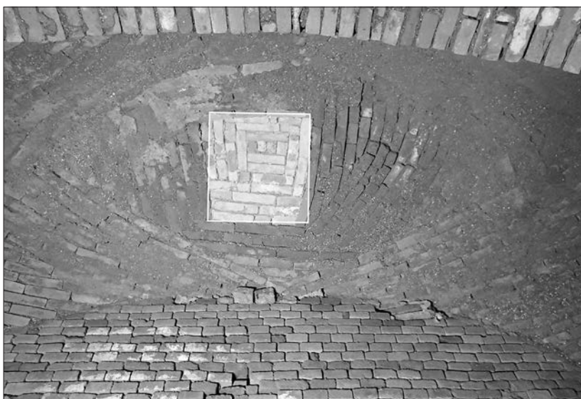
Obr. 5. Východné pole klenby so zamurovaným centrálnym otvorom vo vrchole.
