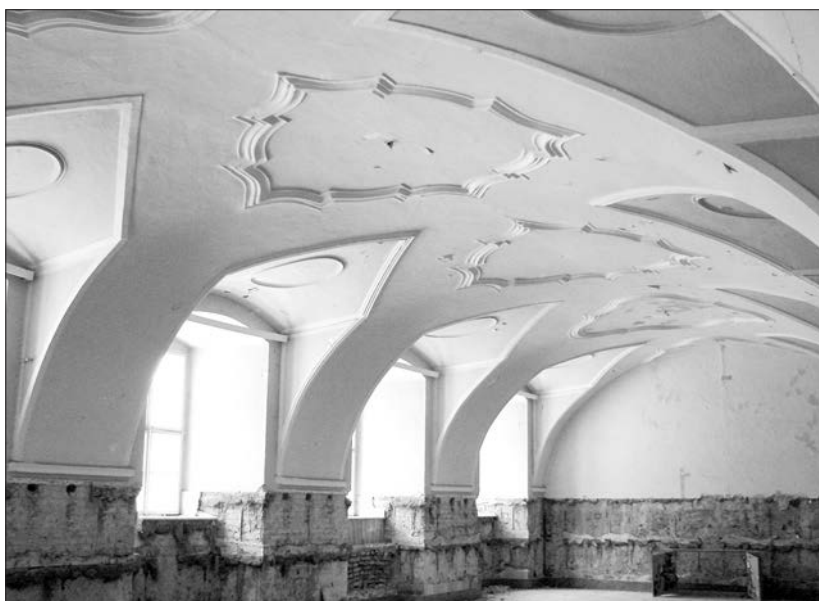
Obr. 11. Bývalý refektár (m.č.1.06), severozápadný pohľad, foto: E. Sabadošová.
