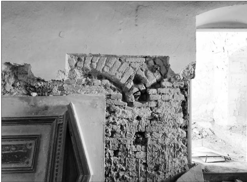
Obr. 4. Čiastočne odkrytý uzáver dvojitej sedílie vo východnej časti severnej steny prejazdu (m. č. 1.01), foto: J. Žuffová.
