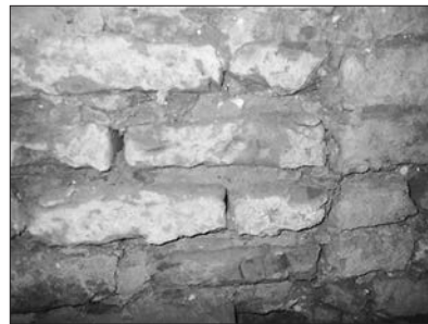
Obr. 16. Suterén A, interiér, čelná – západná stena, pre porovnanie s obr. 15. ukážka najstaršieho typu škárovania (mierne modifikovaného voči trnavským analógiám).
