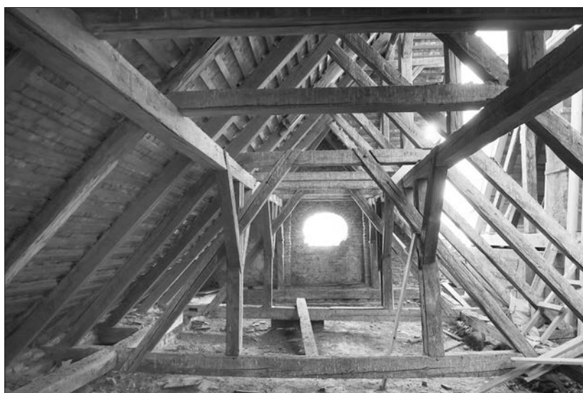
Obr. 12. Krovová konštrukcia nad kaplnkou, pohľad od severu.
