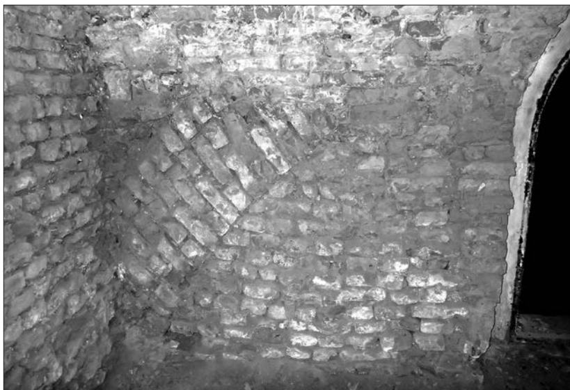
Obr. 17. Suterén D, vonkajšie, do terénu pôvodne zabĺbené líce východnej steny, detail nábehu statického základového oblúka.
