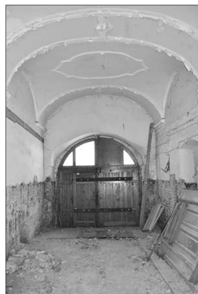
Obr. 10. Zaklenutie prejazdu, pohľad od východu, foto: P. Ďurko.
