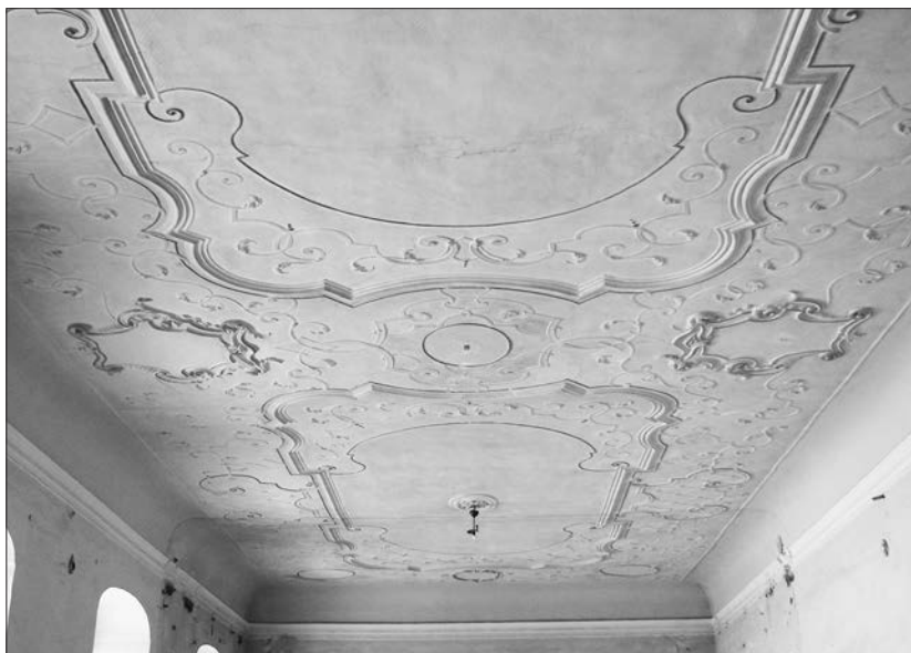
Obr. 13 Štukový strop (m. č. 2.26), foto: E. Sabadošová.
