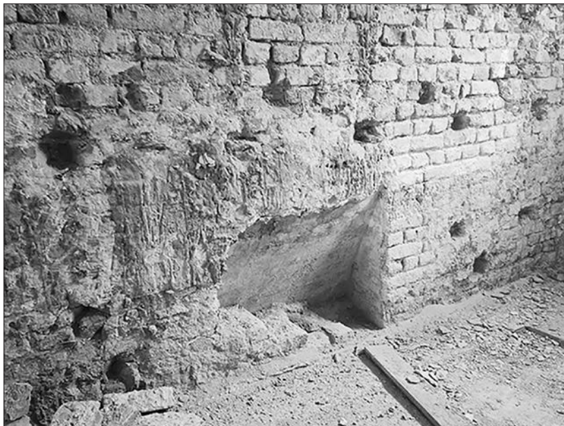
Obr. 6. Nález pivničného okna v južnej stene prejazdu (m. č. 1.01), foto: M. Havlík.
