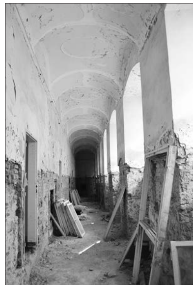
Obr. 9. Chodbový trakt, foto: P. Ďurko.
