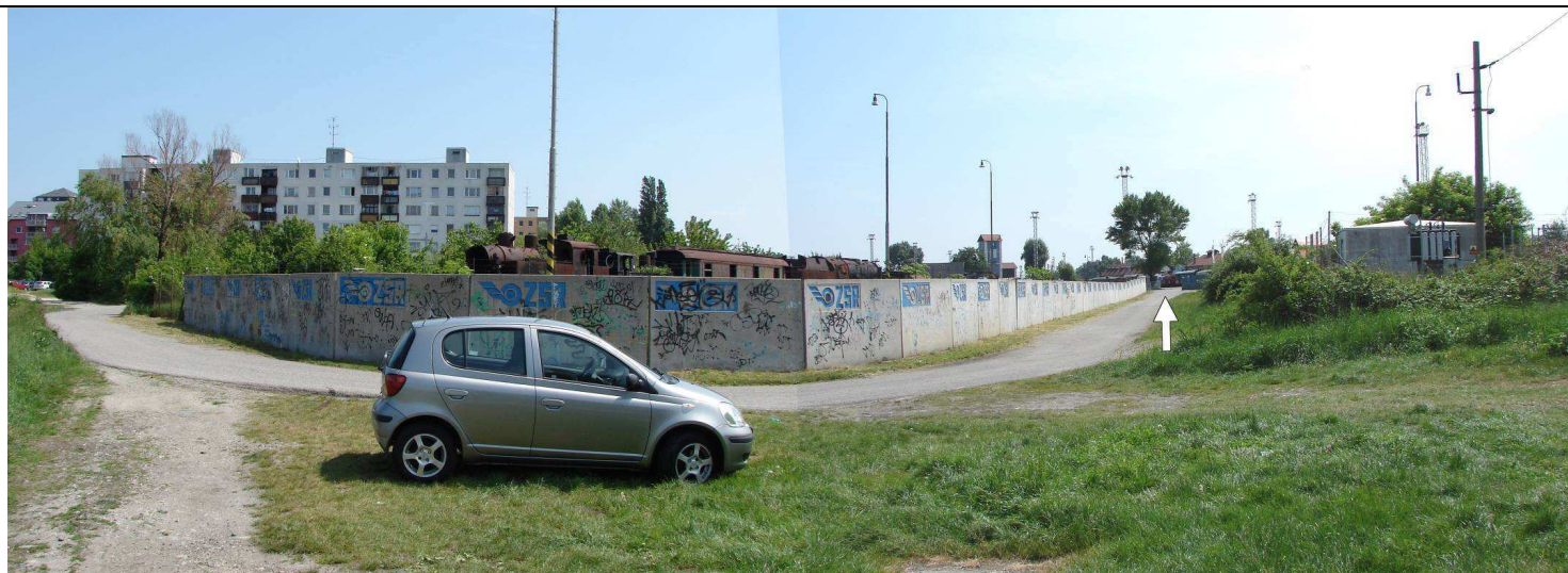
Pohľad zo SZ, Vpravo objekt elektrického zariadenia. Oplotenie z betónových panelov lemuje koľajisko pre dopĺňovanie rušňov uhlím. Šípka – vstup do areálu depa zo SZ.
