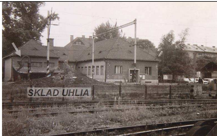
Foto 60 - 70-te roky (?). V blízkosti administratívneho objektu stál vodný žeriav /šípka/ na čerpanie vody do rušňov. V popredí je uhoľný sklad ohradený múrom z liateho betónu. (Pamätná kniha – Rušňové depo Bratislava - Východ, MDC ŽSR)
