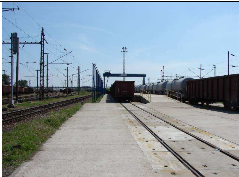
Pohľad do priestoru od západu, máj 2009
