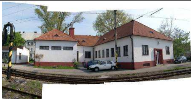
Administratívna budova. (I.). Vľavo elektrodieľňa. Foto apríl 2006
