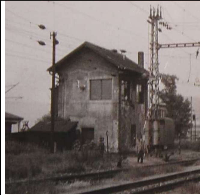
Budova na stávanie výmien (Centrálné stavadlo). Z tejto budovy boli stavané všetky výmeny odchodových a príchodových vlakov od Bratislavy a Rače (Pamätná kniha – Rušňové depo Bratislava-Východ, MDC ŽSR).
