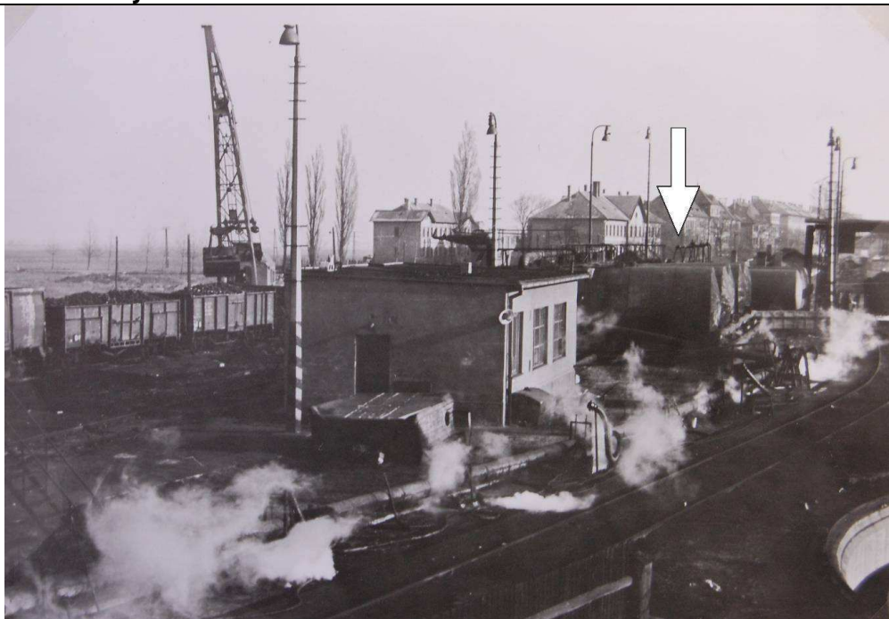
Nádrže na mazut – označené šípkou. Uprostred je objekt olejárne. Historické foto (Pamätná kniha – Rušňové depo Bratislava - Východ, MDC ŽSR)
