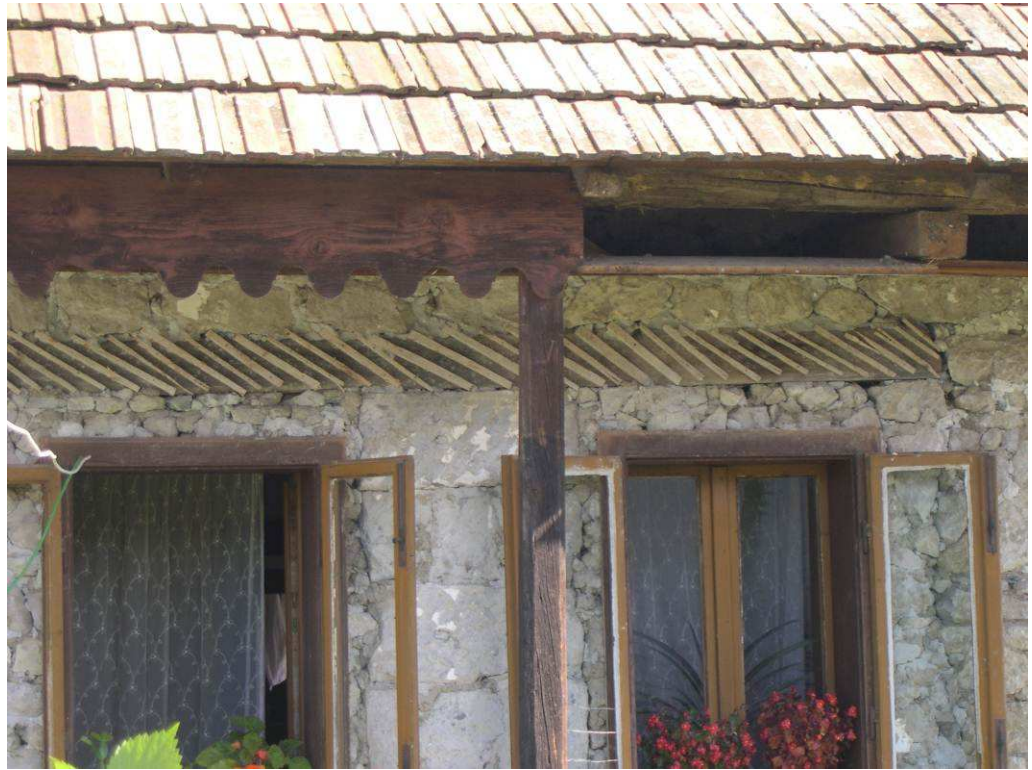
27. Detail nadokenného prekladu
