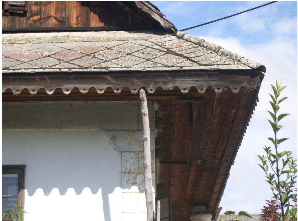
25. Detail zdobenia podstrešnej rímasy
