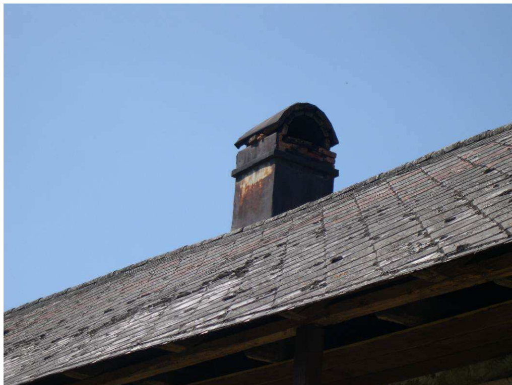
21. Detail komínovej hlavice
