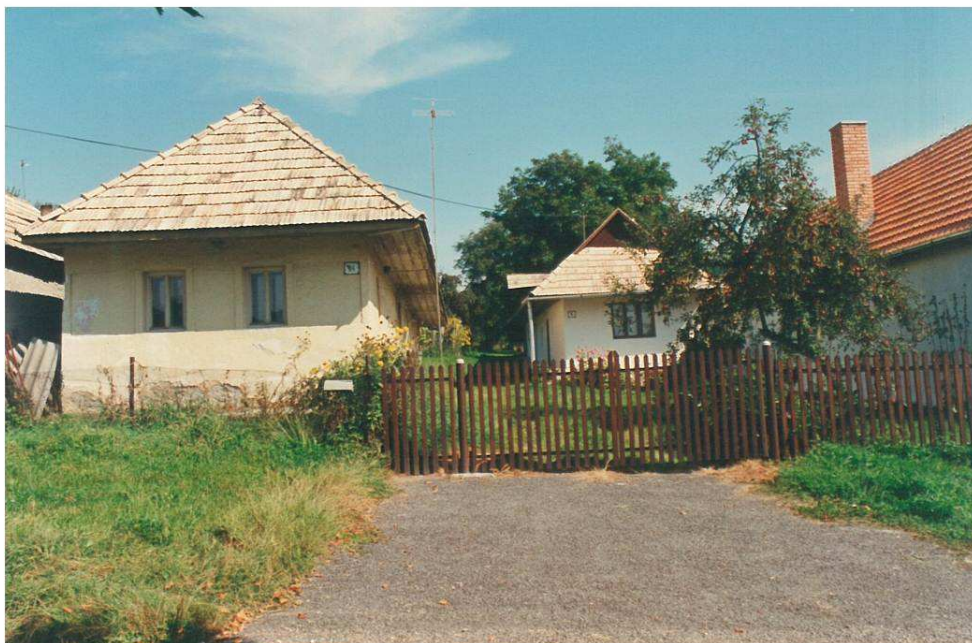
17. Ľudový dom parcelné č. 252 pred rekonštrukciou r. 1999
