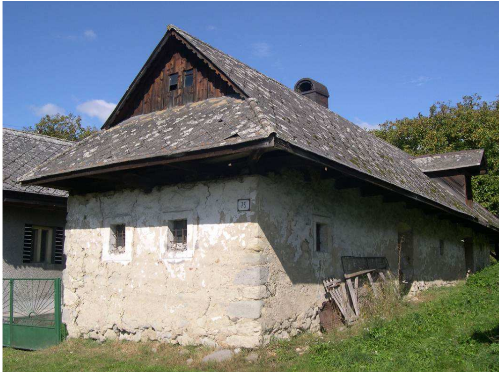
13. Použitie azbestocementovej krytiny
