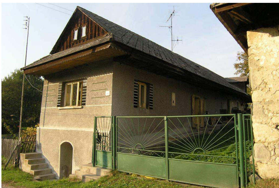
3. Príklad nevhodnej úpravy fasády objektu, oplotenia a riešenia terénnej nerovnosti betónovými schodmi
