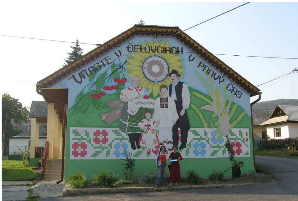
12. Nevhodná výmalba fasády obecného úradu
