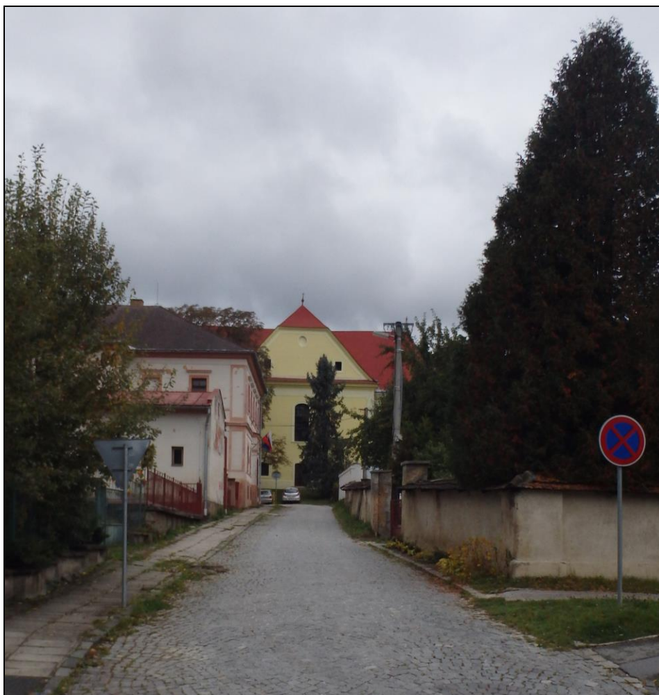
P 25 – Pohľad zo Slovenského ulice do vedľajšej uličky vedúcej na Lutherovo námestie. V priehľade osi ulice juhovýchodná fasáda evanjelického kostola.
