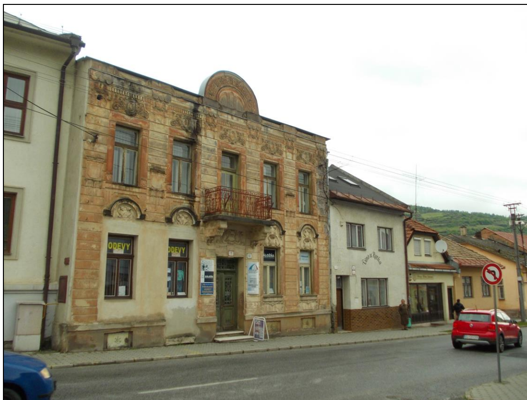
P 40 – Zástavba západného horného kraja Hlavnej ulice.
