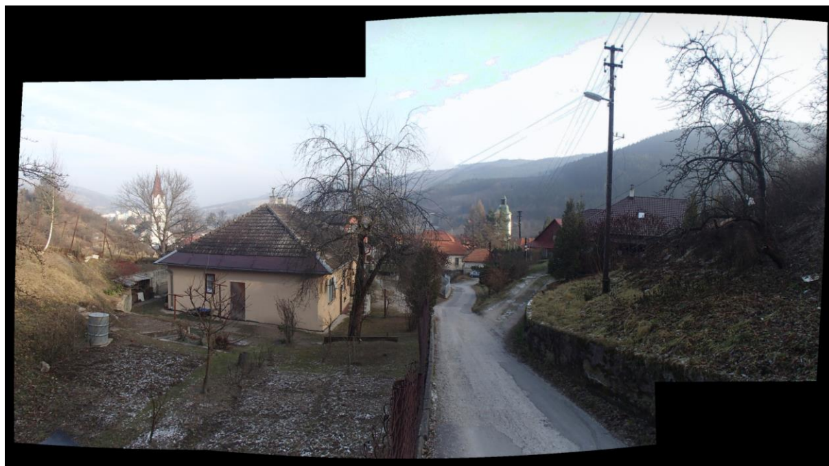
P 10 - Zámkova ulica. Zachytáva domy Zámkovej ulice s číslom 4 a 38.
