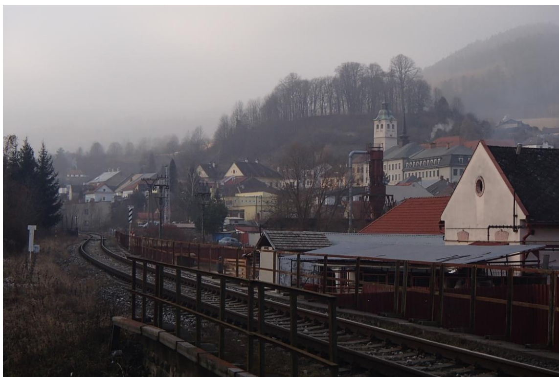
P 32 – Juhovýchodná hranica pamiatkovej zóny, pohľad na zástavbu od železničnej trate. V pozadí sa vypína hradný kopec Zámčisko a pred ním veža radnice.
