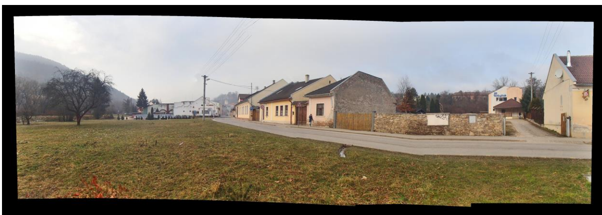
P 34 – Východný kraj Hlavnej ulice, záver pamiatkovej zóny mesta. Domy Hlavnej ulice s číslom 71 – 79.
