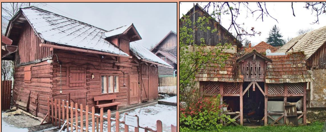
Dva inšpiračné príklady regionálne typických starších dvorových drobných stavieb: vľavo : zrubová hospodárska stavba s chlievikom vľavo, dielňou v strede, sklodom vpravo a tradičným transportným vikierom do podstrešia (Úhorná); vpravo : záhradný altán zo zač. 20. stor. hrádzenej konštrukcie s tieniacimi trelážami a so vstupom, akcentovaným drobným štítom s ornamentálne / insitne vyrezávaným doštením (Ochtiná);
