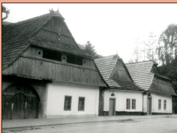
Strechy hospodárskych objektov so stredovou podlomenicou. Stav z roku 1955.
