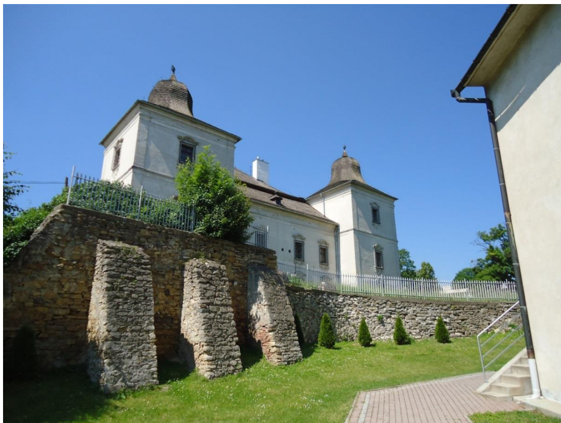
31. Juhozápadná časť areálu kostola s ohradným múrom (jún 2014)
