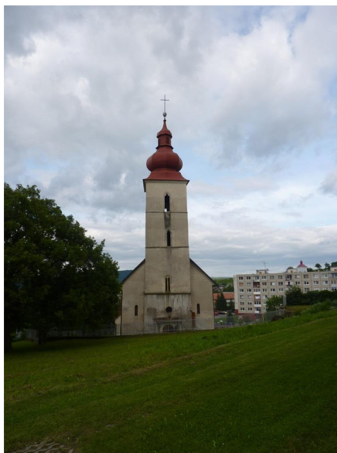
24. Západná fasáda rímskokatolíckeho kostola (rok 2013)
