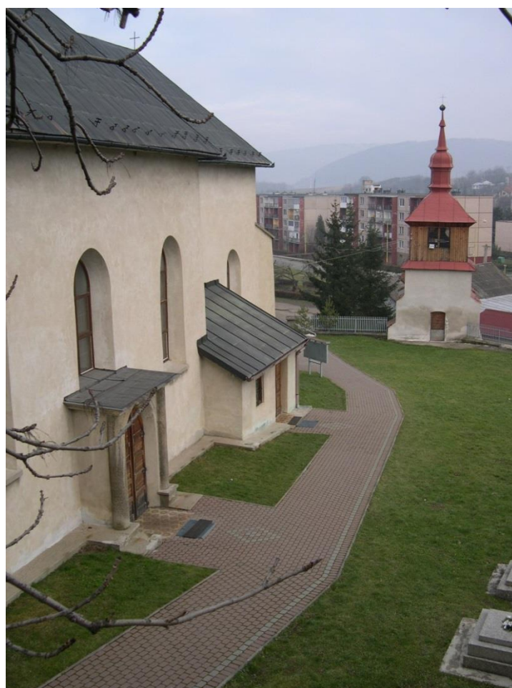
28. Južná časť areálu kostola (r. 2004)
