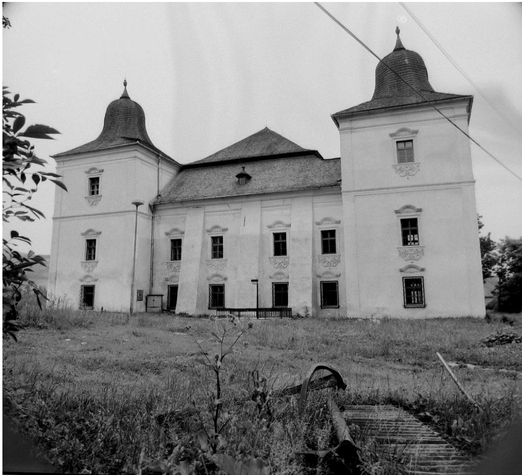
45. Juhozápadná fasáda „Veľkého kaštieľa“ po obnove z roku 1979
