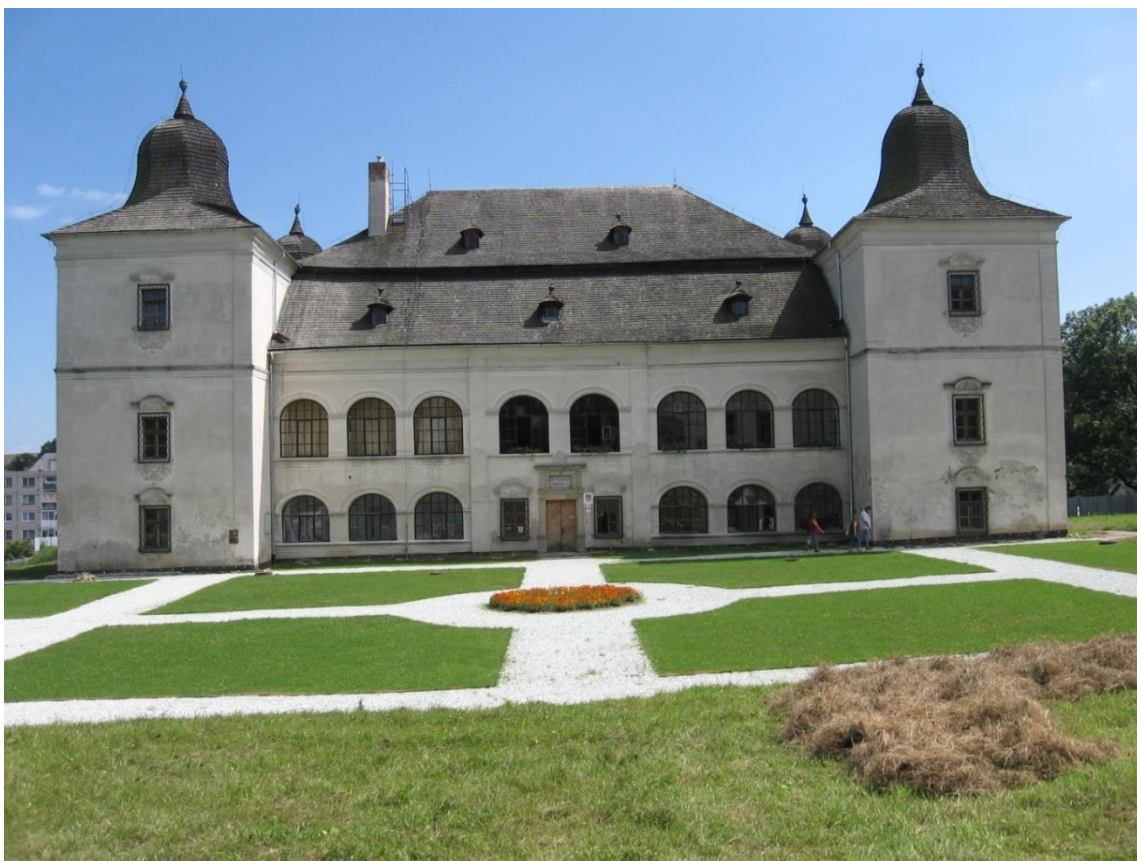
48. Severozápadná hlavná fasáda „Veľkého kaštieľa“ (rok 2008)
