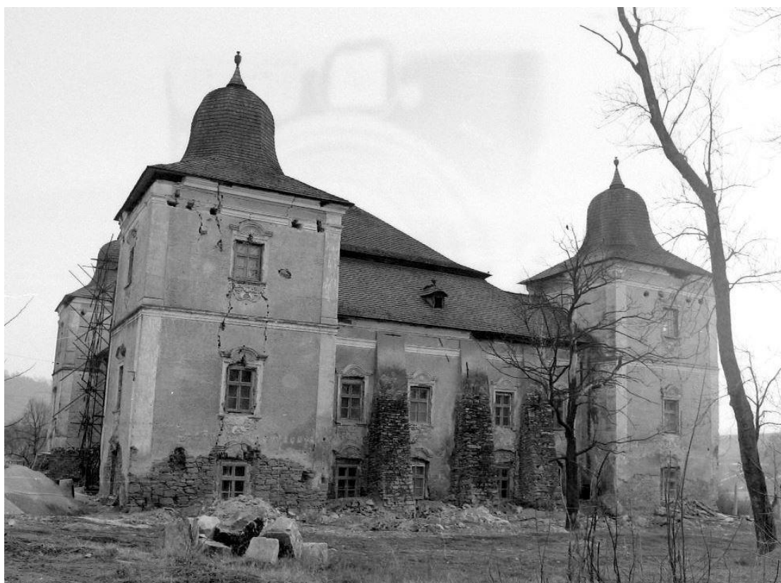
42. Juhozápadná fasáda „Veľkého kaštieľa“ počas obnovy (začiatok 70. rokov 20. storočia)
