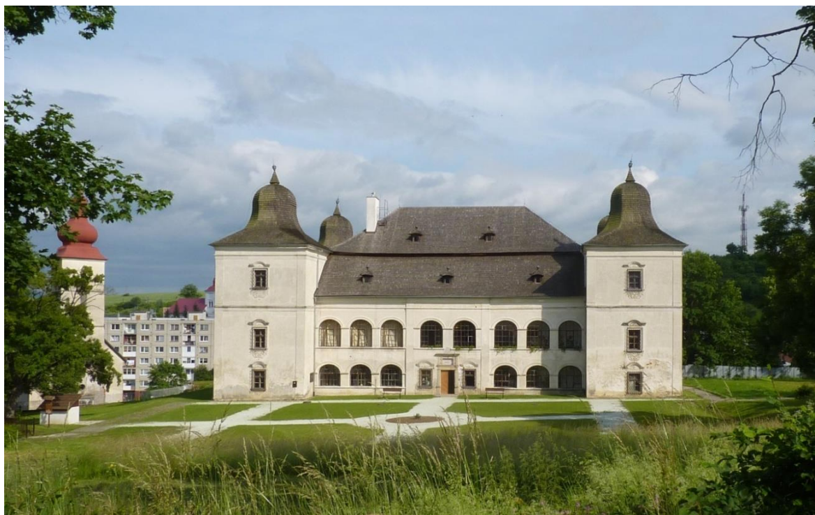
51. Severozápadná fasáda „Velkého kaštieľa“ (rok 2013)
