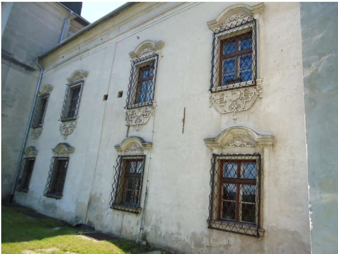
54. Architektonická výzdoba severovýchodnej fasády „Veľkého kaštieľa“ (jún 2014)
