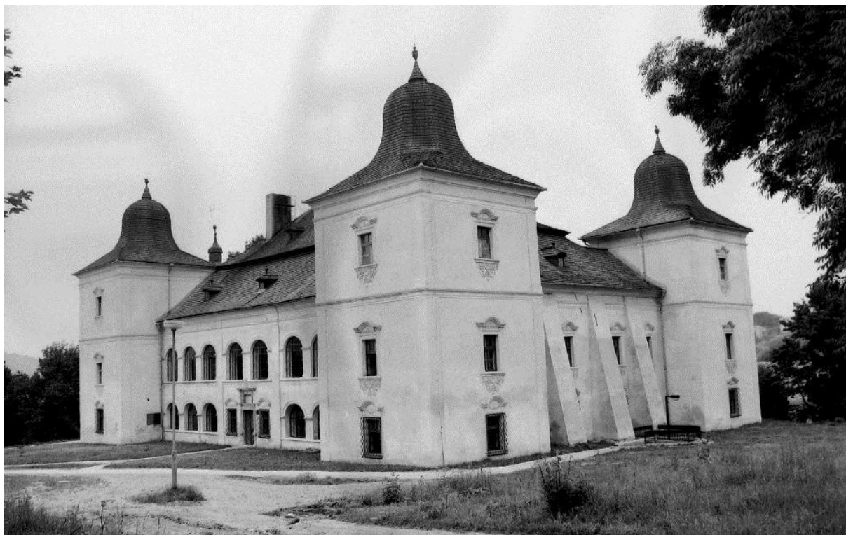
44. Západný pohľad na „Veľký kaštel“ po obnove (rok 1979)
