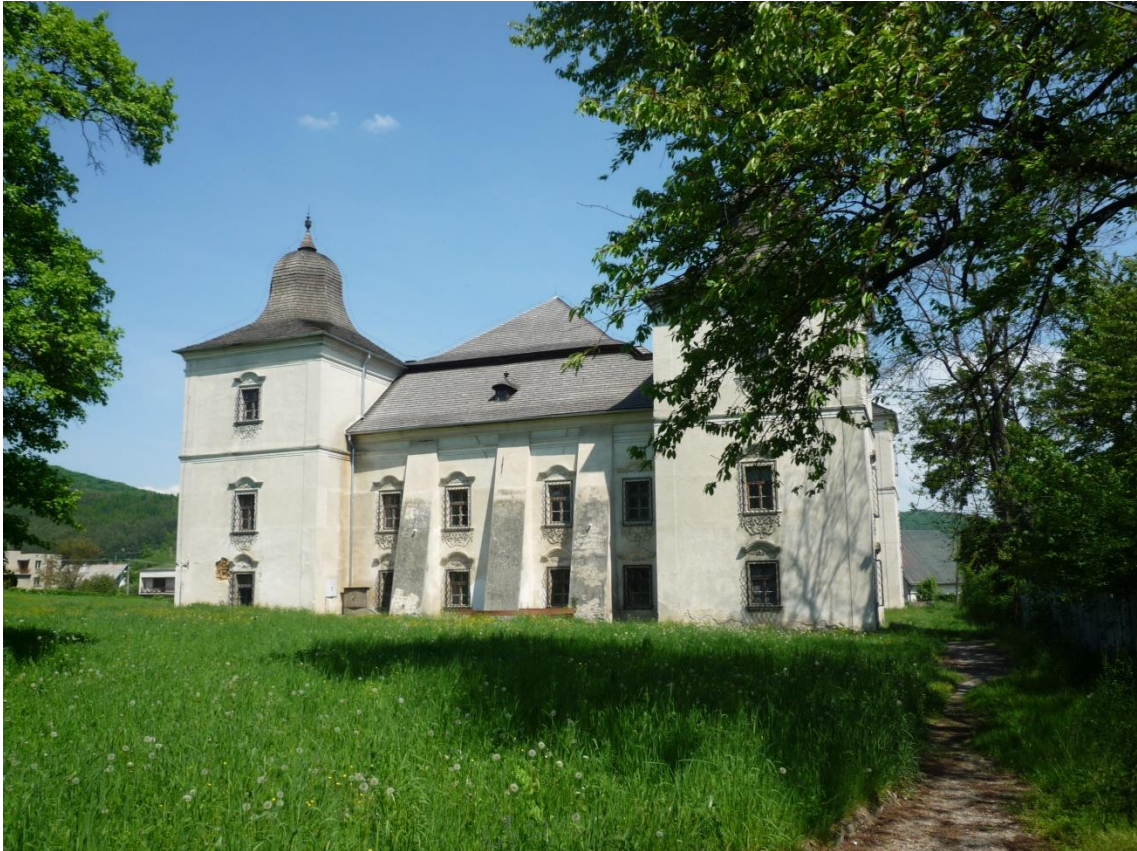
53. Juhozápadná fasáda „Veľkého kaštieľa“ (máj 2014)
