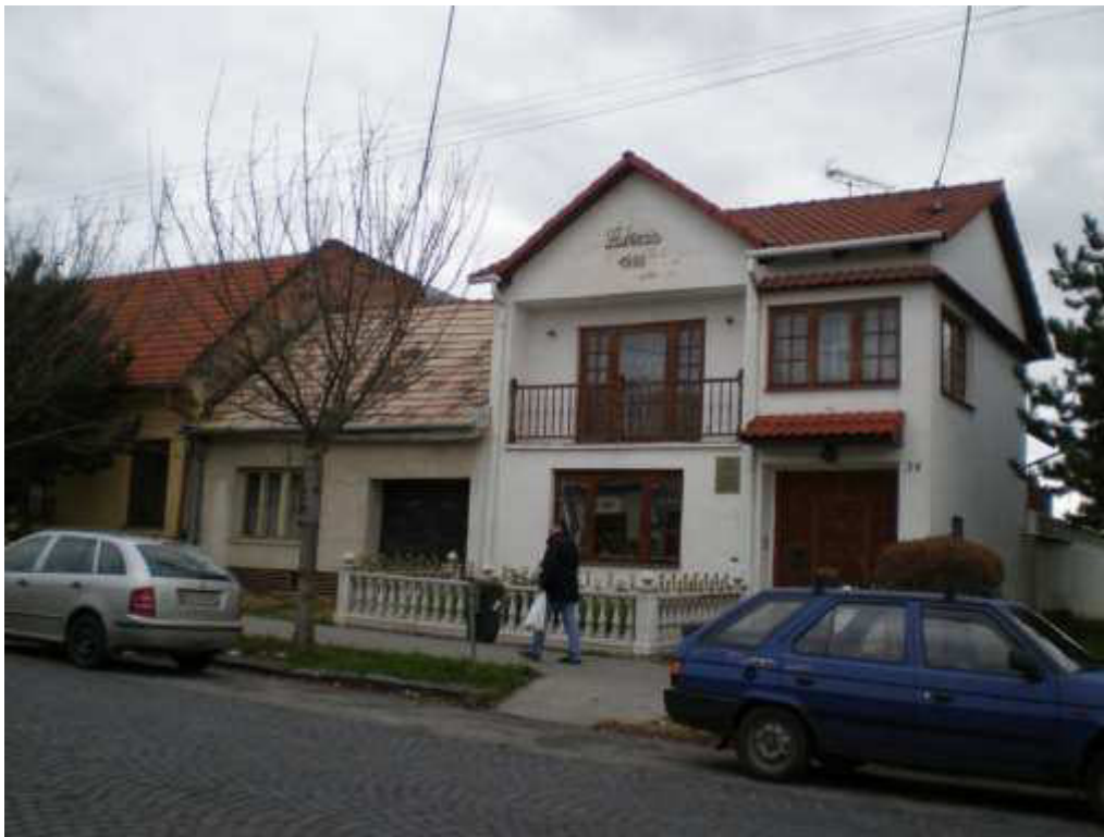
Pribinova 24 a 26, pohľad na hlavné fasády
