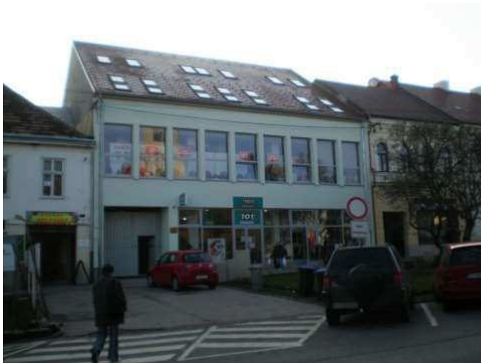
Námestie sv. Michala 5, hlavná fasáda novostavby (predtým Dom obuvi)
