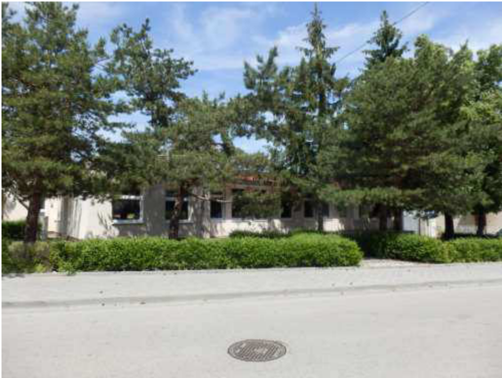
Za Poštou 7, hlavná fasáda (v súčasnosti budova bytového hospodárstva)
