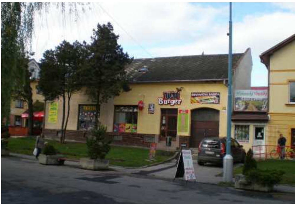
Námestie sv. Michala 21, pohľad na hlavnú východnú fasádu
