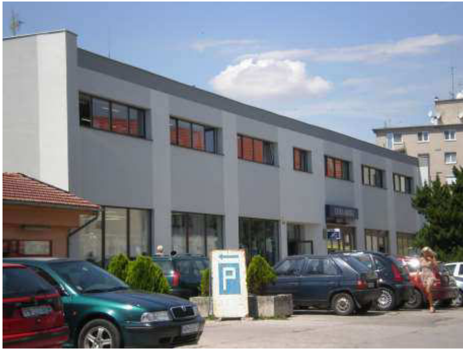
Zadný severný pohľad na Dom služieb zo strany dnešného parkoviska
