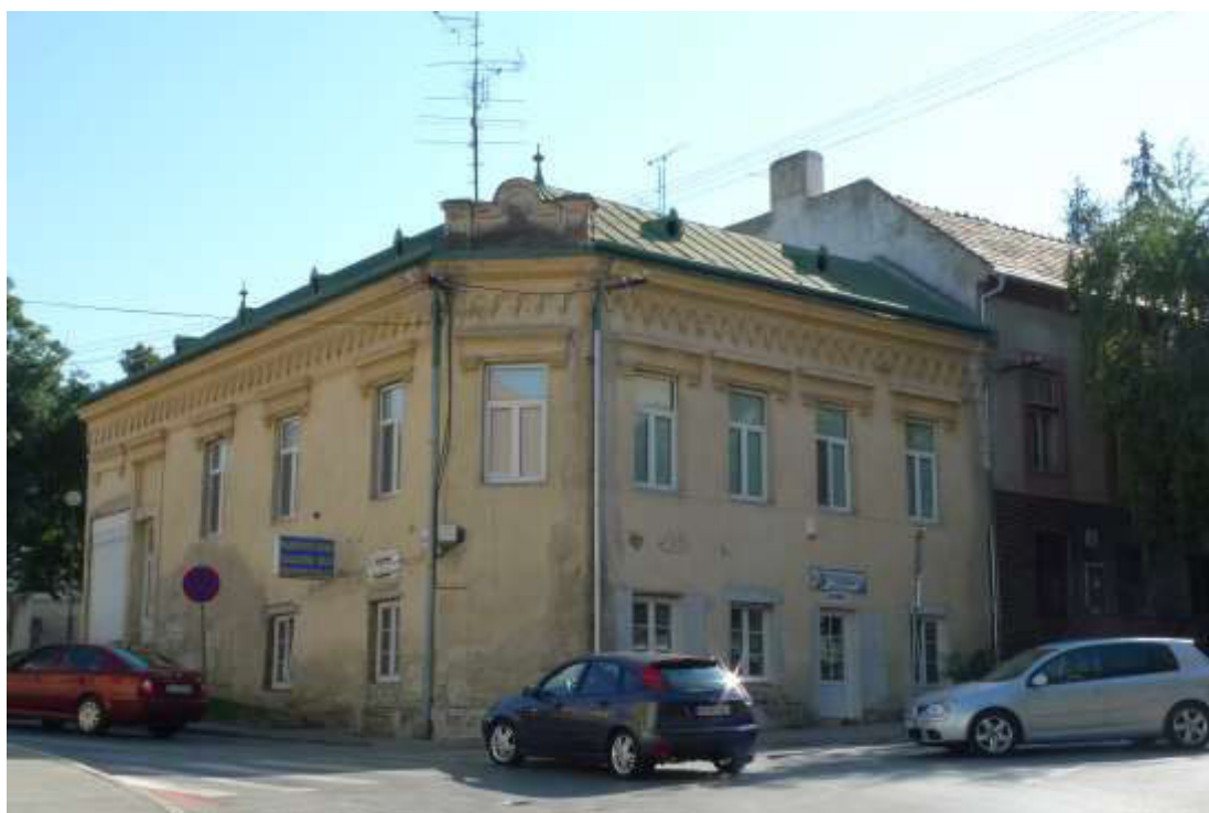
Hlohová 1, pohľad na uličné fasády (južnú a západnú) z Ul. Pod Beranom
