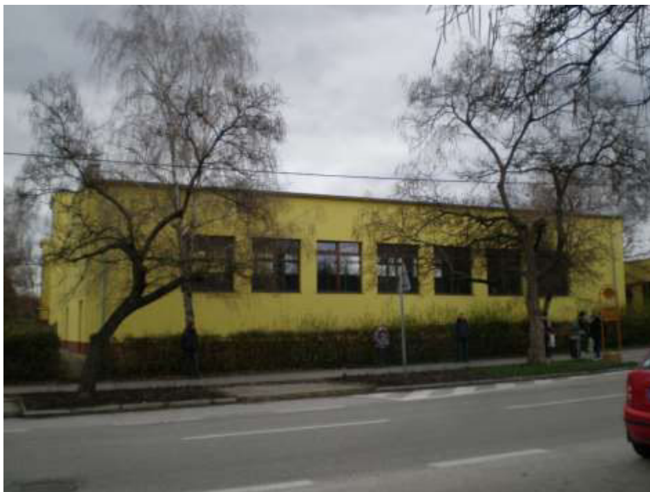
Hlohová ul., objekt telocvične pre ZŠ, č.p.2563, pohľad z Hlohovej ulice
