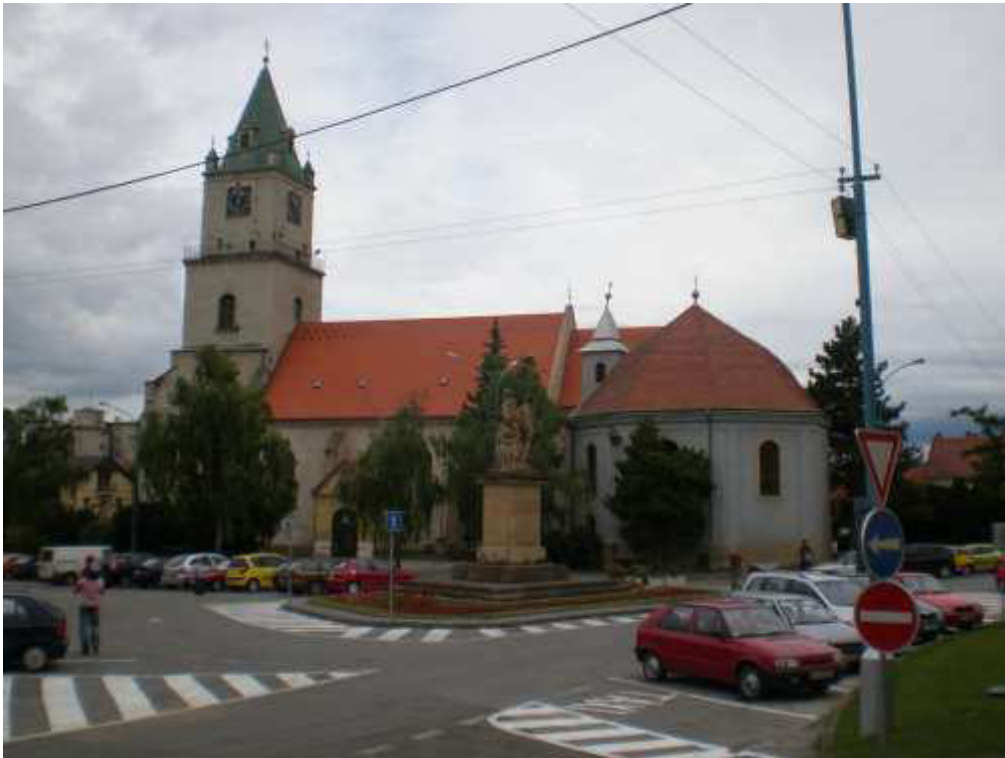
Pohľad na Kostol sv. Michala a Kaplnku sv. Anny z Podzámskej ulice
