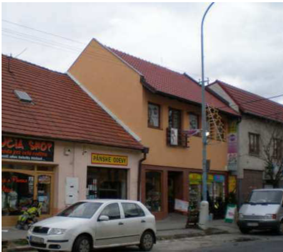
Pribinova 10 - hlavní fasáda po nadstavbě přízemního domu
