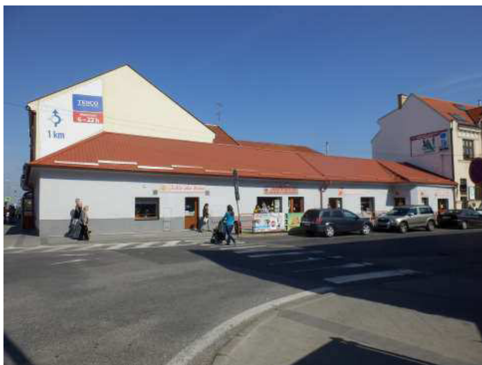
Pribinova 2, uličná fasáda z Pribinovej ulice
