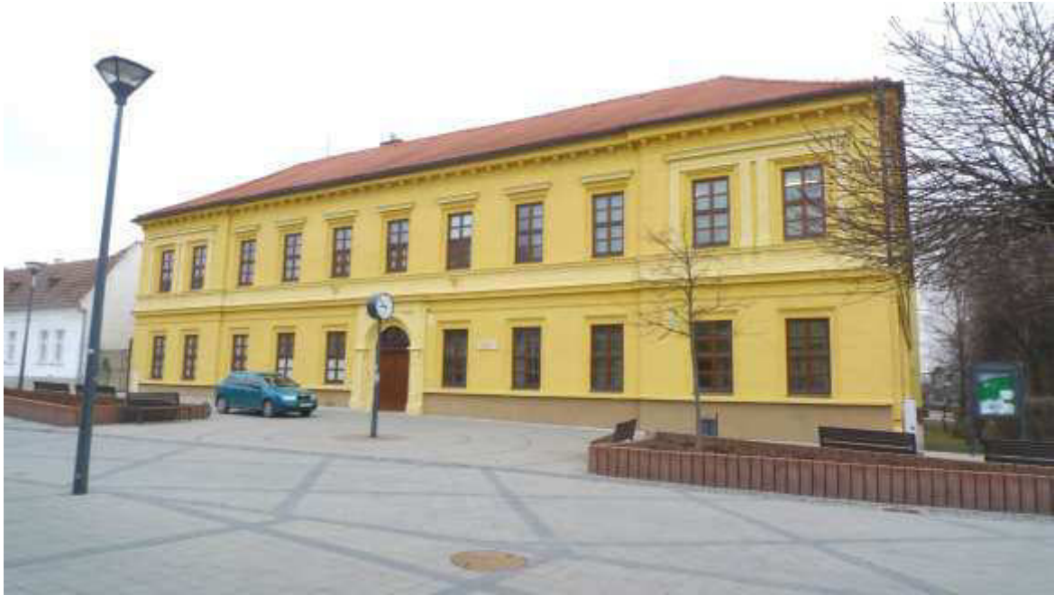
M.R.Štefánika 30, hlavná fasáda býv. meštianskej školy
