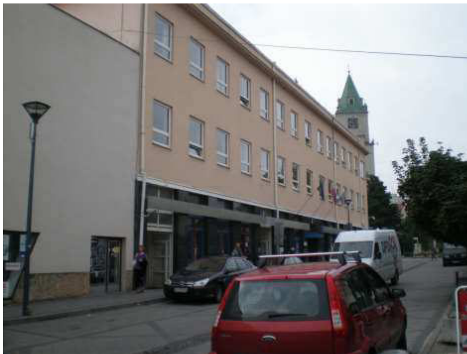
M.R.Štefánika 1, hlavná fasáda zo Štefánikovej ulice
