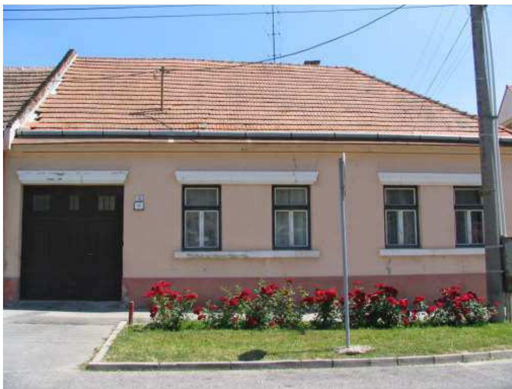
Podzámska 10, hlavná fasáda
