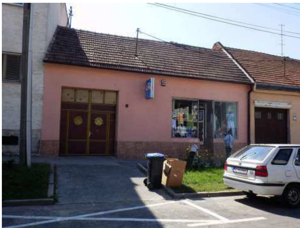
Podzámska 8, hlavná fasáda
