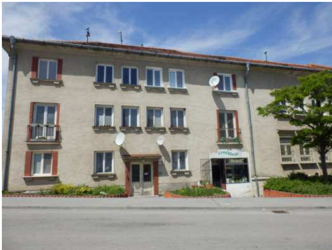
Za Poštou 1, hlavní fasáda
