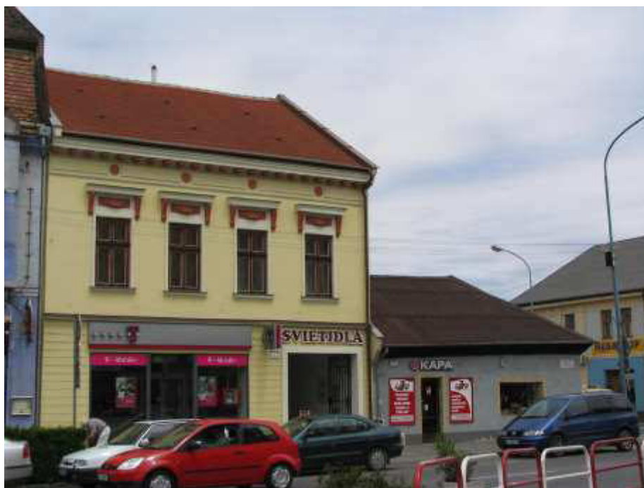
Námestie sv. Michala 8, pohľad na hlavnú fasádu (dvojpodlažný objekt)
