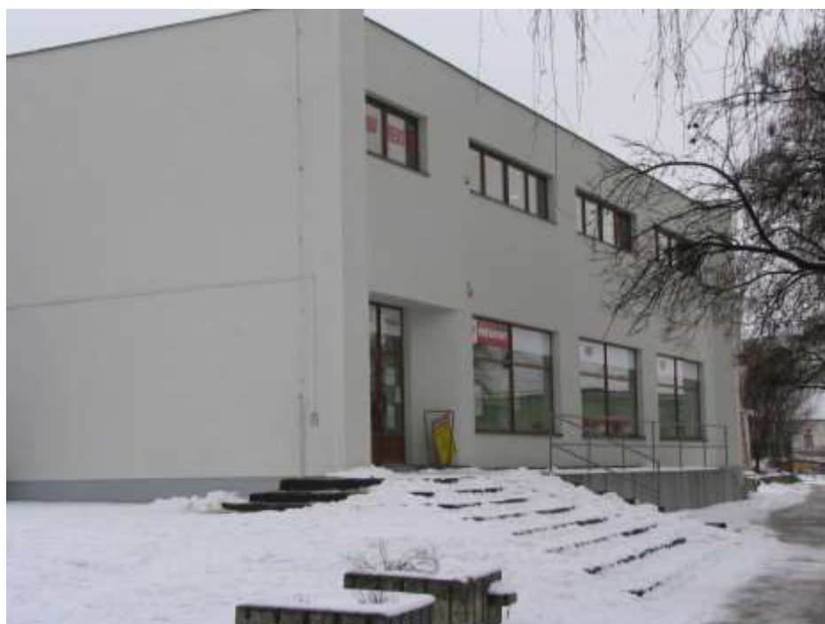
Hlohová ulica, pohľad na fasádu Domu služieb objektu s p.č. 300-3 (v súčasnosti Coop Jednota)
