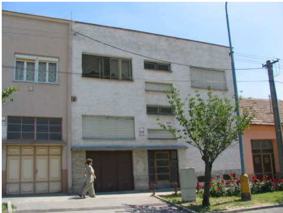
Podzámska 6, hlavná fasáda
