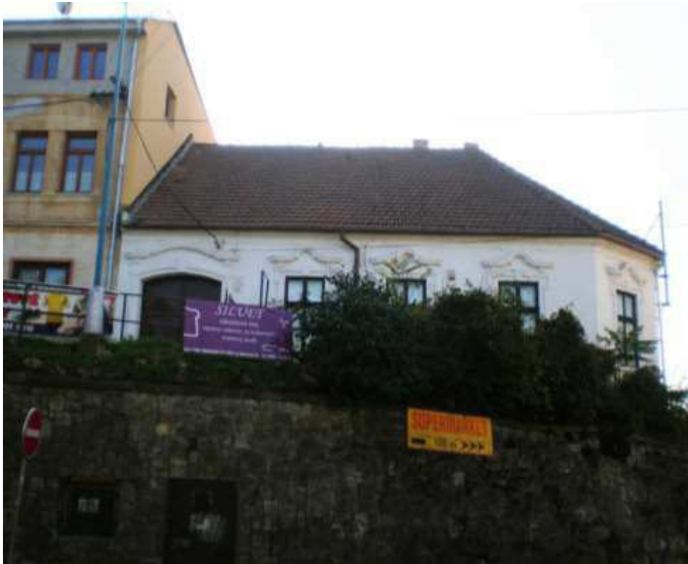
Námestie sv. Michala 23, pohľad na hlavnú severnú fasádu
