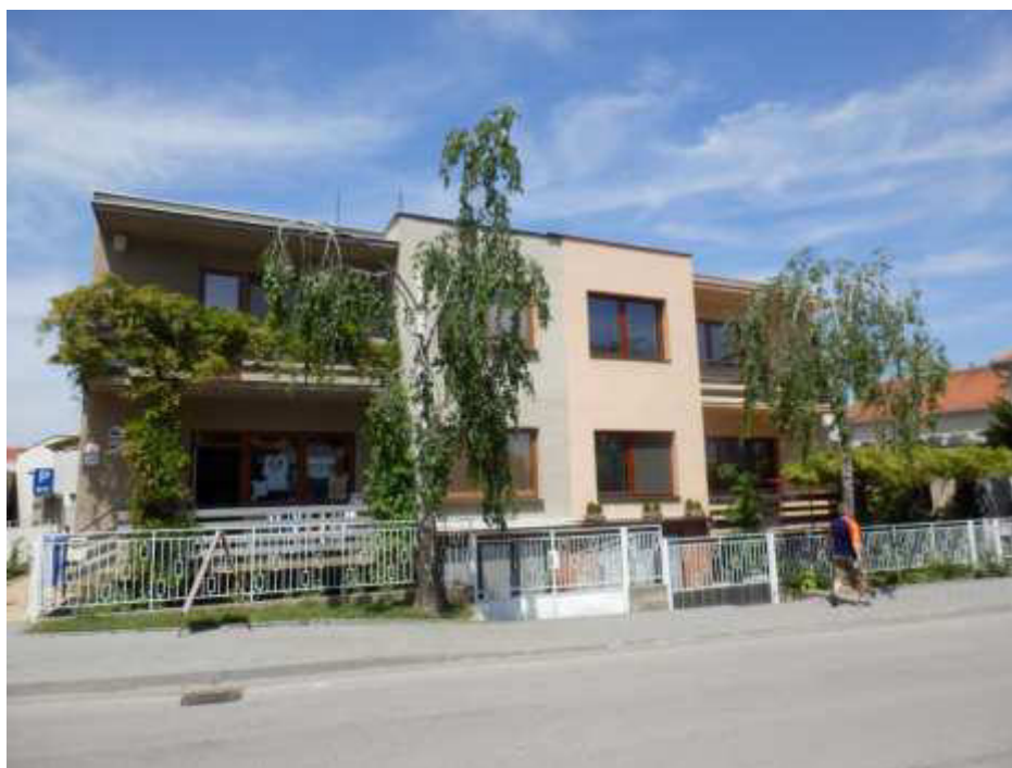
Za Poštou 3 a 5, pohľad na hlavné fasády
