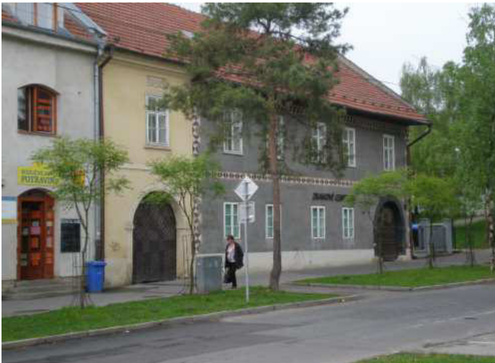
Podzámska 14, hlavná fasáda
