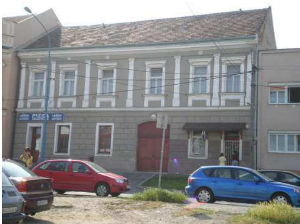
Podzámska 2, hlavná fasáda
