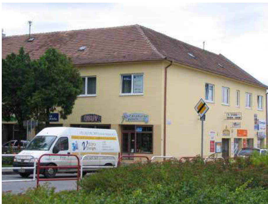
Námestie sv. Michala 19, pohľad na hlavné fasády - východnú a severnú
