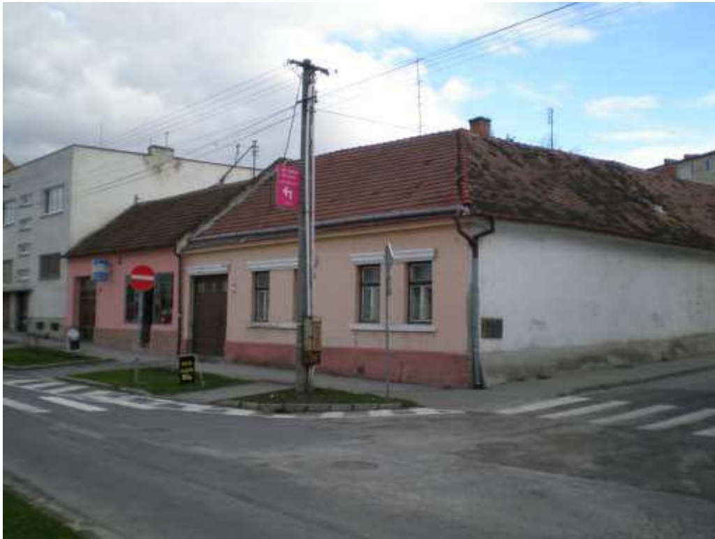
Podzámska 10,8 a 6, pohľad na hlavné fasády(západnú a južnú)
