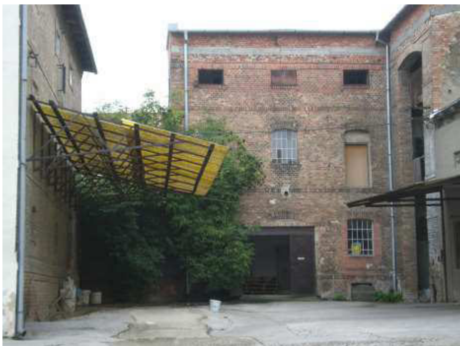
M.R.Štefánika 23, pohľad do dvora na objekt sila a sklad(vpravo) býv. sladovne
