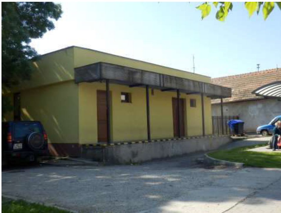
Hlohová ul., objekt s parc. č. 257, hlavná fasáda
