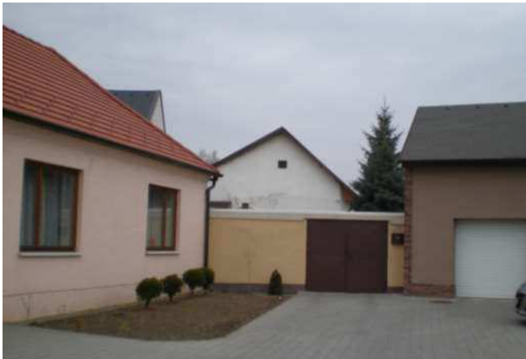
Historická ulička, pohľad na murované oplotenie vstupu do uličky zo zadnej časti parcely č.300/4
