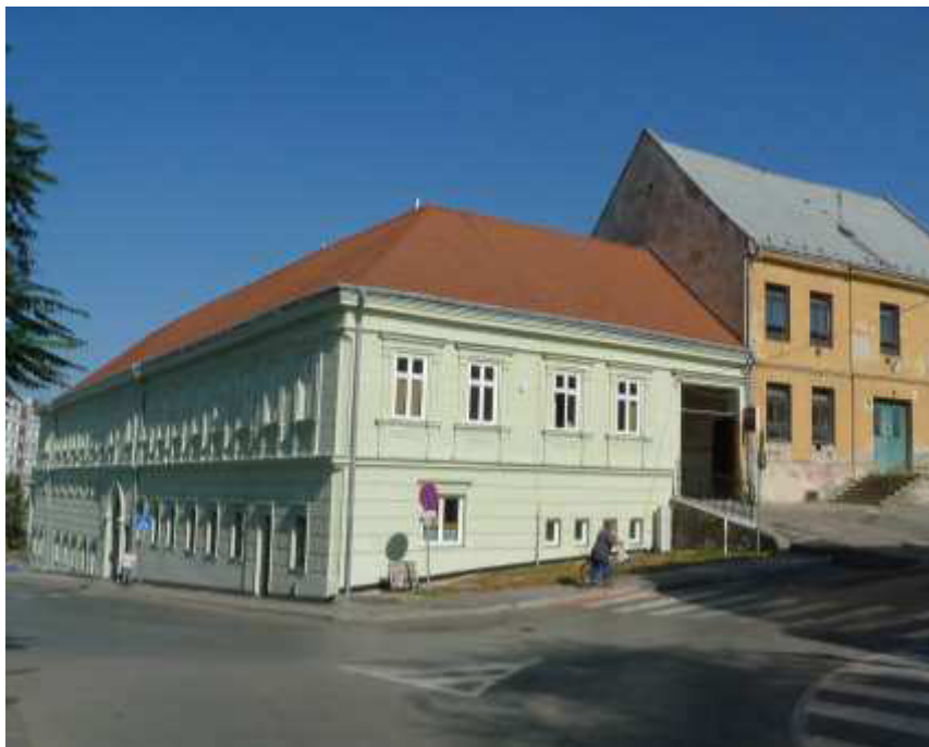
Pod Beranom 2, pohľad na uličné fasády (južnú a východnú) z námestia sv. Michala
