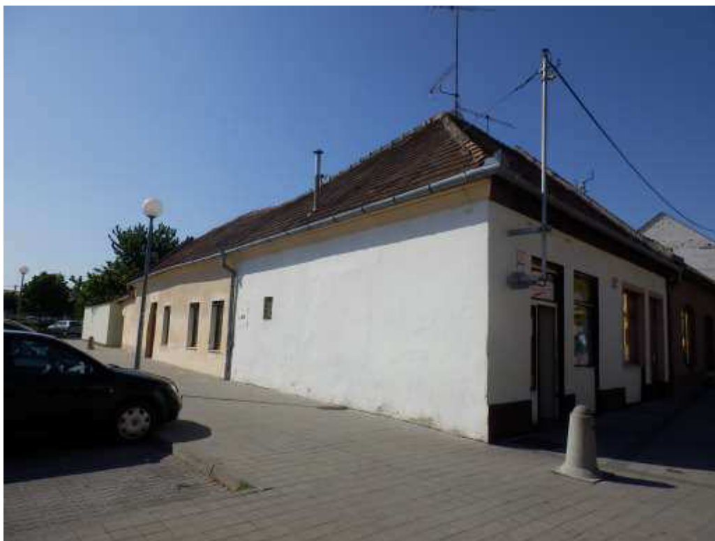
M.R.Štefánika 37, uličné fasády - západná zo Štefánikovej a severná z ulice Starý rínek
