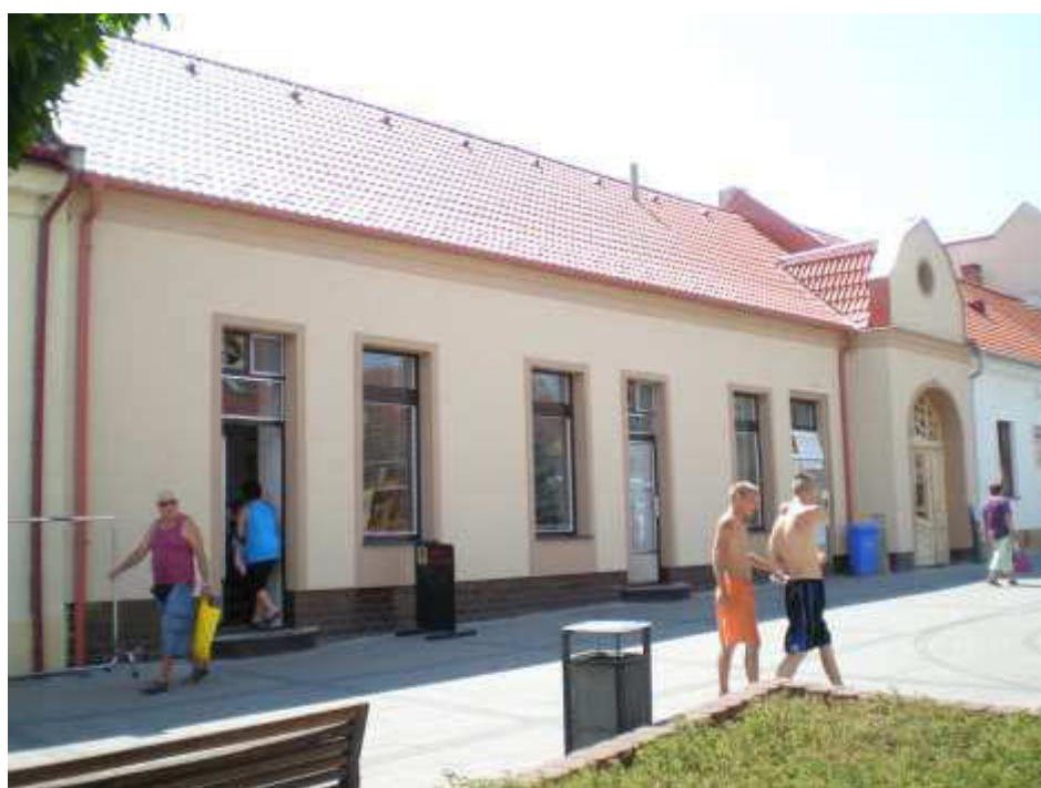
M.R.Štefánika 11, hlavná fasád
