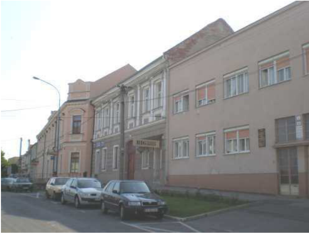
Podzámska 4 a 2, pohľad na hlavné fasády
