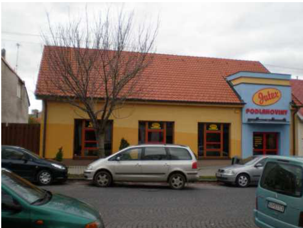
Pribinova 18, pohľad na fasádu (novostavba)
