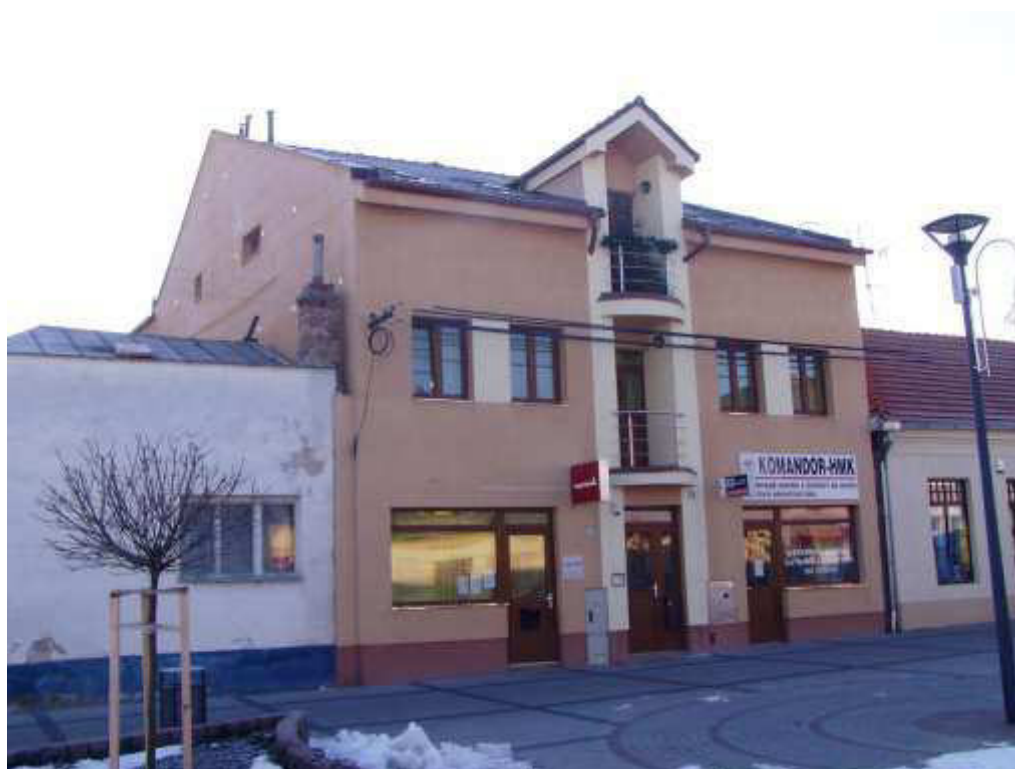
M.R.Štefánika 21, hlavná fasáda (novostavba)
