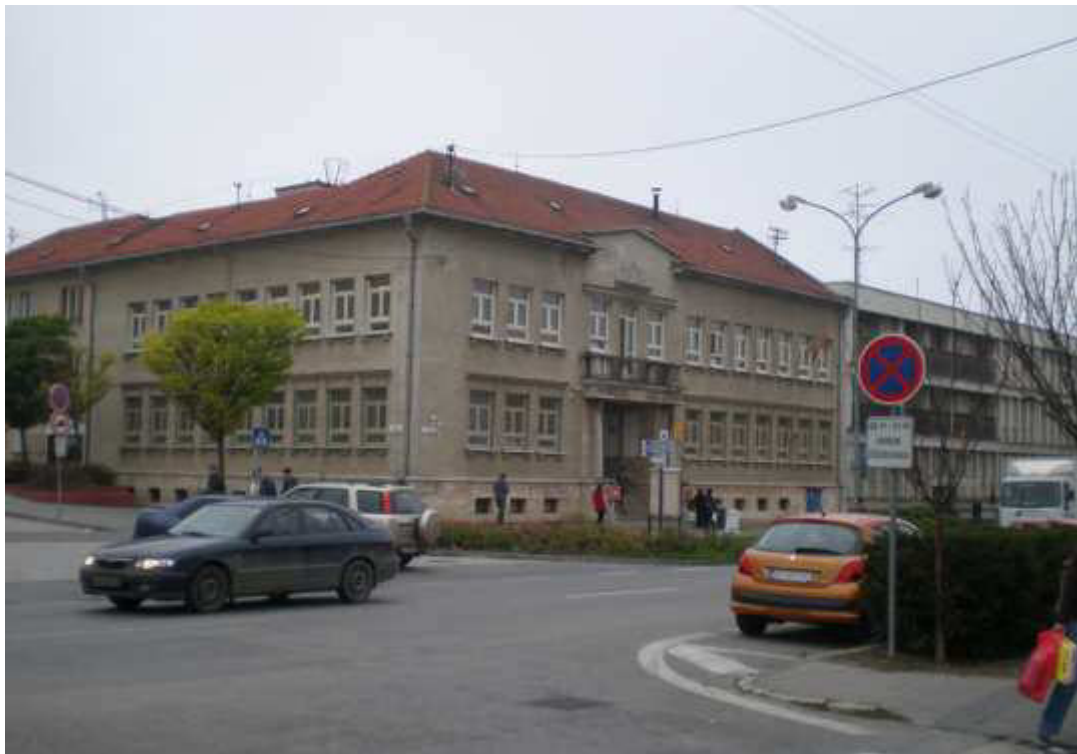
SNP 15, pohľad na hlavnú severnú a východnú fasádu budovy pošty
