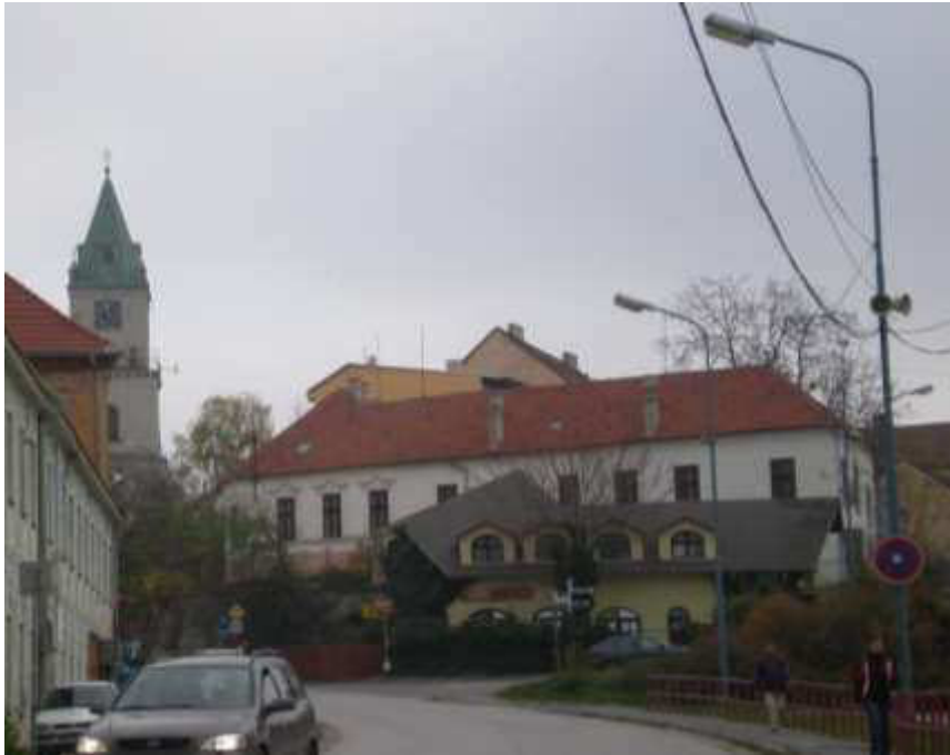
Pod Beranom 1, pohľad na hlavnú fasádu novostavby (prízemný objekt s vikiermi)
