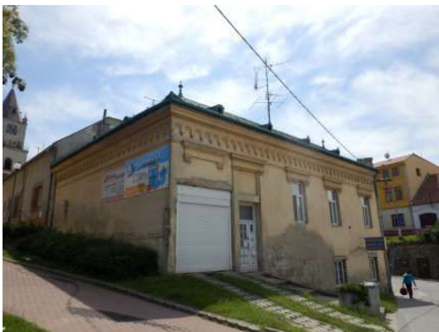
Hlohová 1, pohľad na uličné fasády (severnú a západnú) z Hlohovej ulice
