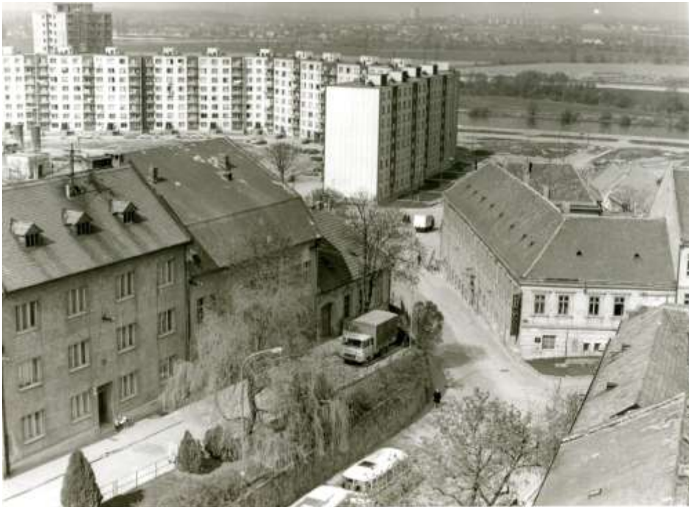
7. Vyústenie námestia smerom do ulice Pod Beranom, r.1977 (archív PUSR)
