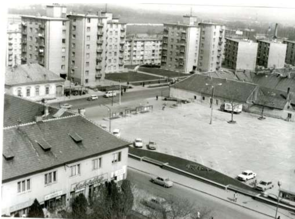
6. Pohľad na severozápadné vyústenie námestia, v pravo parkovisko (dnes Dom služieb), v pozadí nová bytová zástavba západnej strany Hlohovej ulice, r.1977 (archív PUSR)
