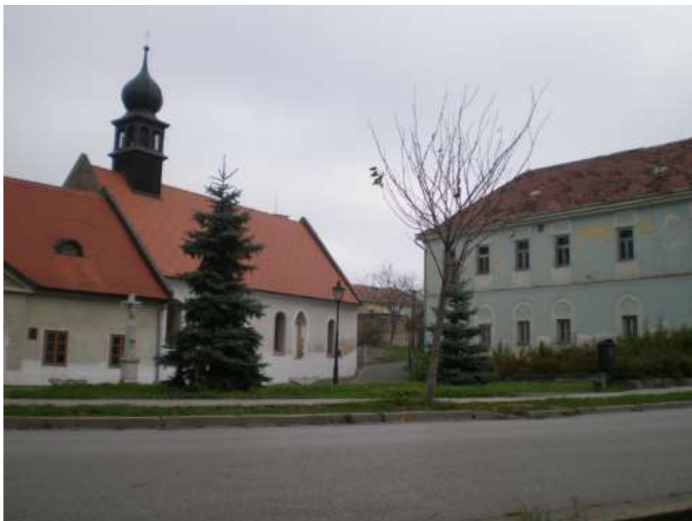
9 (A)- Pohľad z Nám. sv. Cyrila a Metoda smerom do Kamennej uličky, v ľavo Kostol sv. Ducha a špitál, vpravo budova býv. súdu (archív KPU TT)
