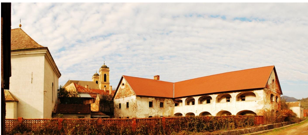
Pohľad č. C - pohľad z južnej časti pamiatkovej zóny, od potoka Jordán severným smerom na Kostol sv. Petra a Pavla a na evanjelickú školu
