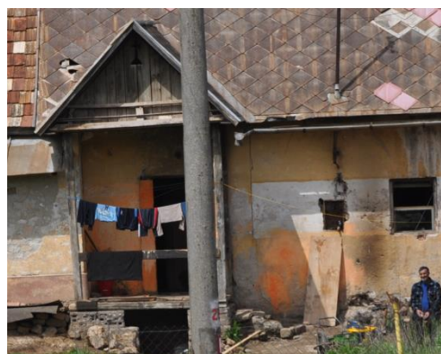
Vstup do domu z úrovne terénu
