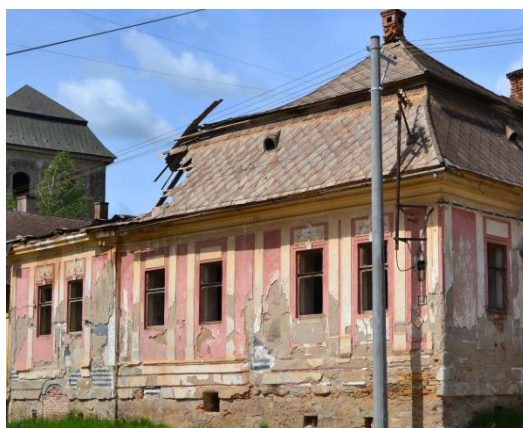
Súčasný stav - Dom správcu Coburgovského majetku
