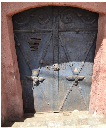
Detail kovových dverí vstupu do suterénu
