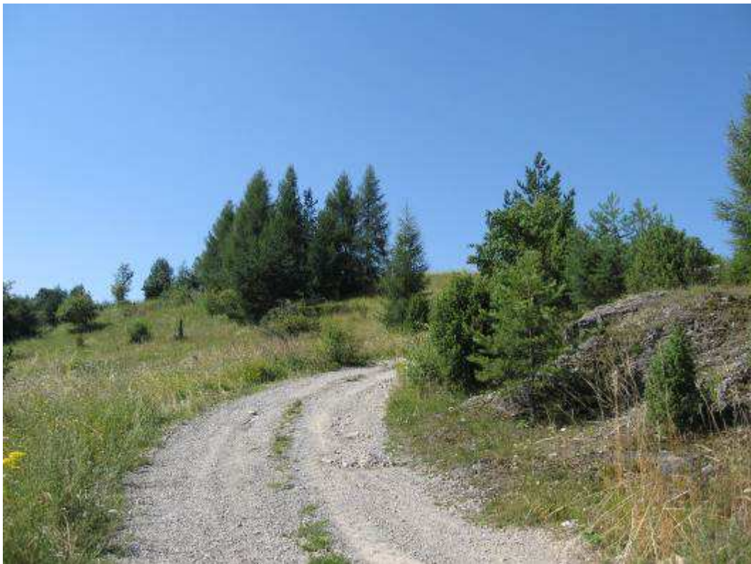
Obr. 130 – poľná komunikácia – povrch sypané kamenivo
