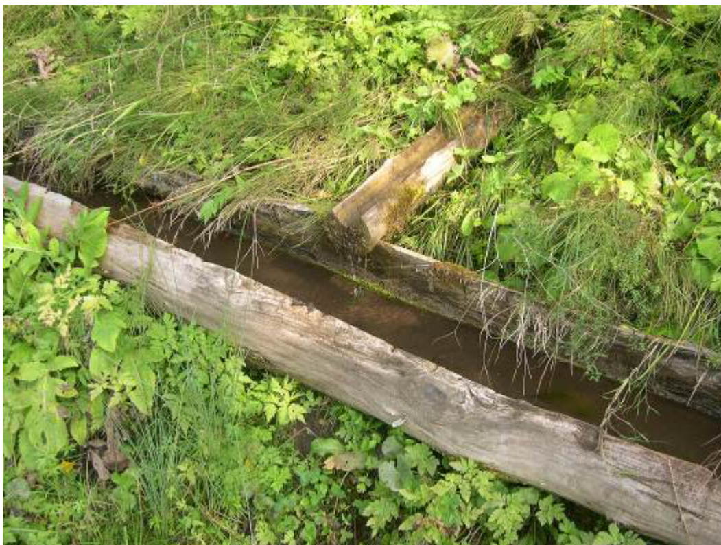
Obr. 124 – detail prívodu vody do napájadla
