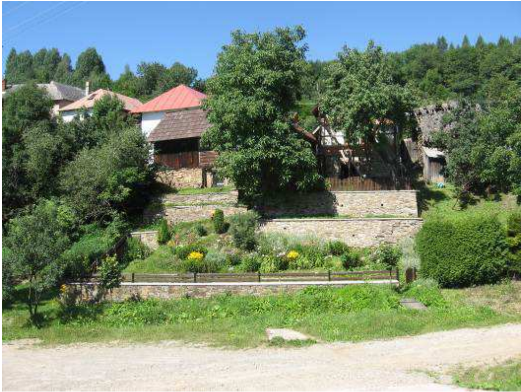
Obr. 143 – cudzorodé a krajne nevhodné terasovanie opornými múrmi pri úprave pozemku (parc. č. 103)
