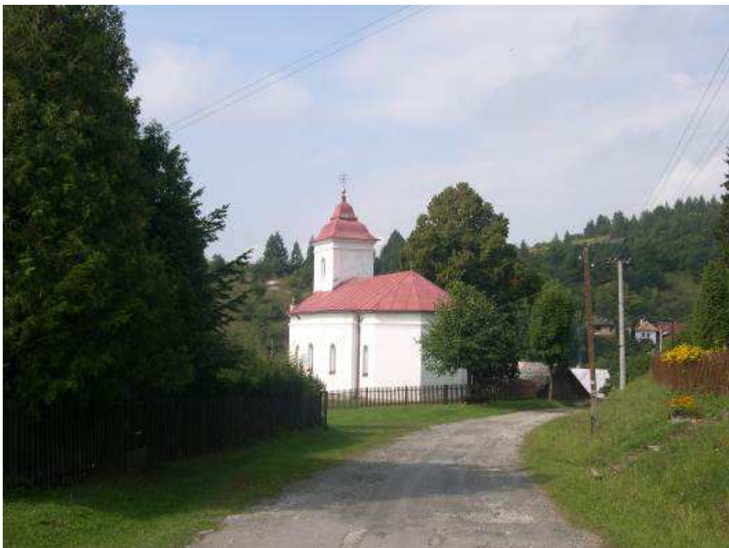
Obr. 128 – hlavná prístupová komunikácia – povrch asfalt
