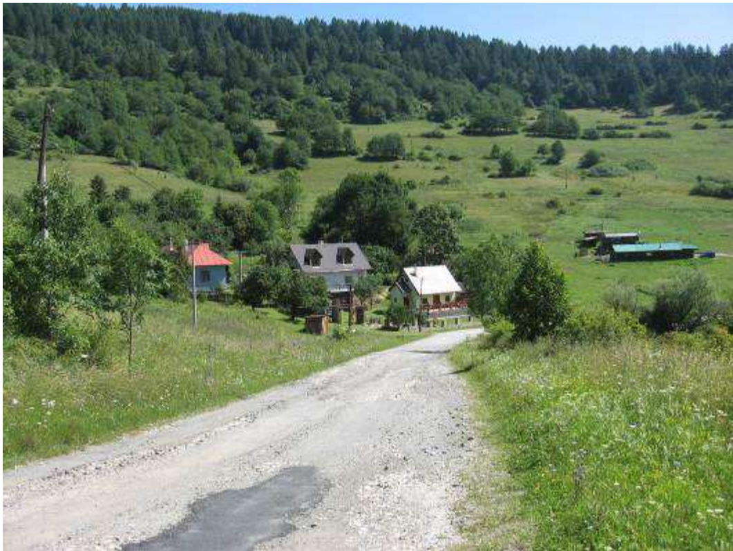
Obr. 145 – existujúca zástavba v ochrannom pásme pri prístupovej ceste
