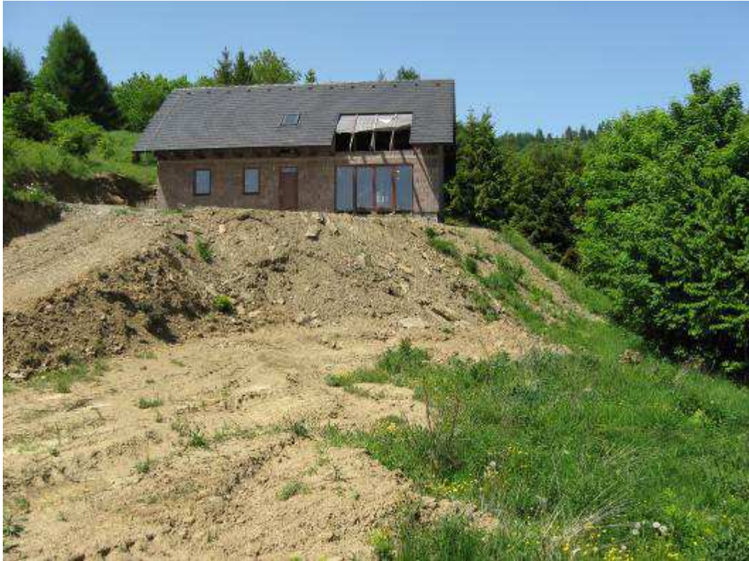
Obr. 141 – krajne nevhodná úprava prirodzeného terénu pre umiestnenie stavby na parcele č. 196
