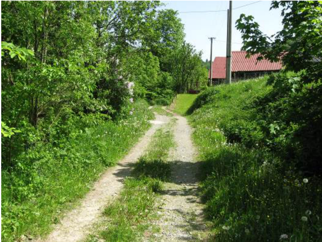
Obr. 129 – miestna komunikácia – povrch zavalcované kamenivo
