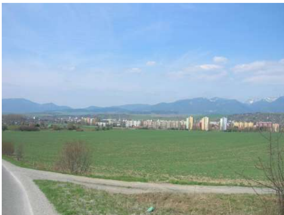
pohľadový uhol dokumentuje nevýrazné pôsobenie historickej štruktúry v rámci súčasnej zástavby sídla pohľad z cesty do lľanova na siluetu pamiatkovej zóny
