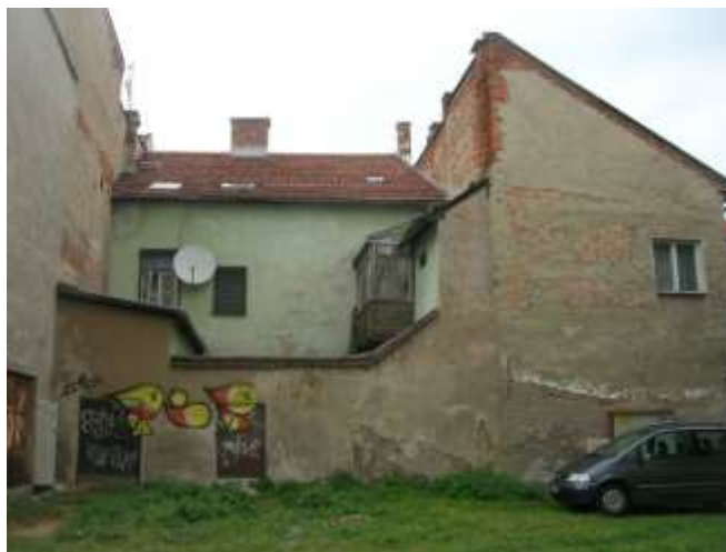
zástavba zadnej časti – južný blok Štúrova ulica
