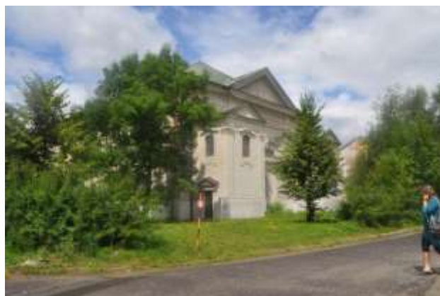
synagóga, úpravy okolia NKP – východná časť
