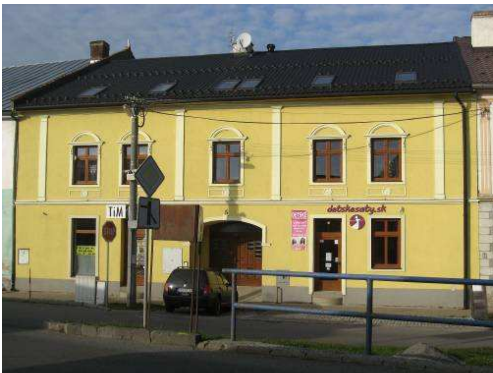
205. Bernolákova ulica č. 206/5, parc. č. 568 – objekt (novostavba) rešpektujúci pamiatkové hodnoty územia (nevhodná falzifikujúca úprava fasády novostavby– záklenok vstupu, štuková výzdoba)
