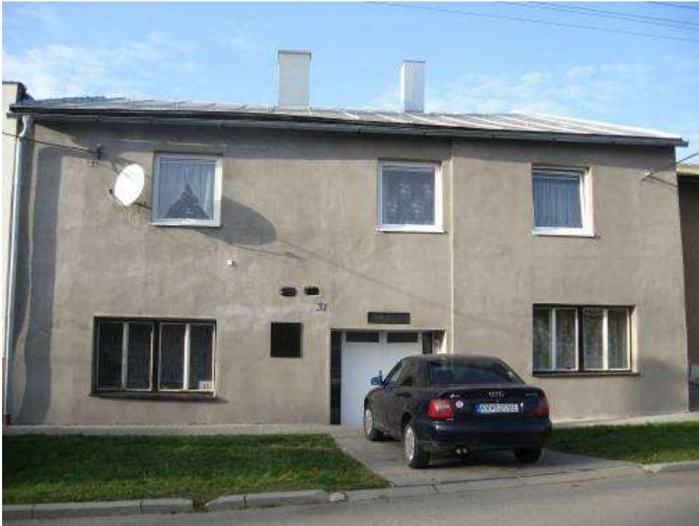
227. Bernolákova ulica č. 219/31, parc. č. 553 – objekt rešpektujúci pamiatkové hodnoty územia
