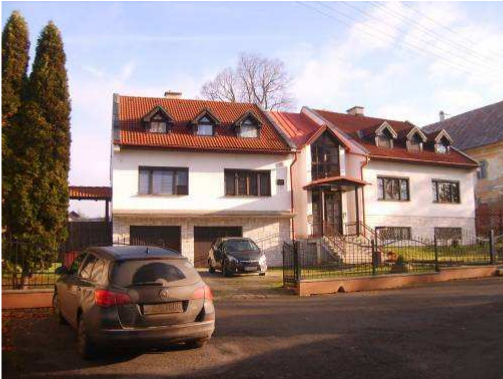
265. Povstalecká ulica č. 1085/47, parc. č. 147 a 148 – objekt (novostavba) nerešpektujúci pamiatkové hodnoty územia
