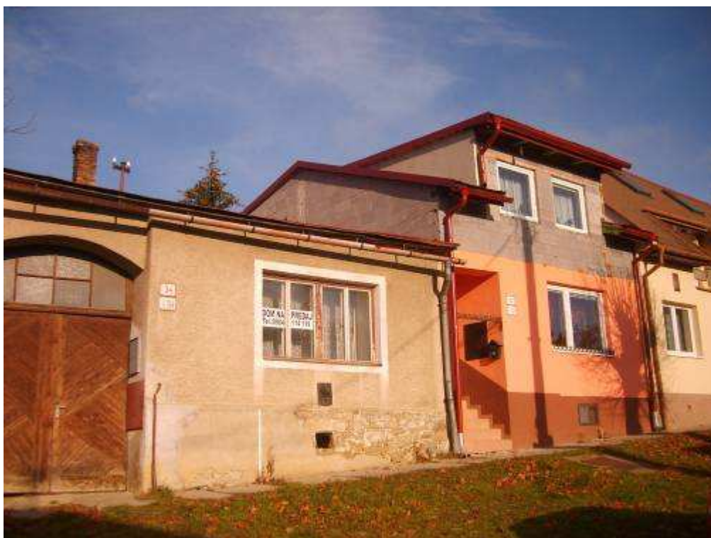
256. Povstalecká ulica č. 258/34, parc. č. 75 (vľavo) – objekt rešpektujúci pamiatkové hodnoty územia
