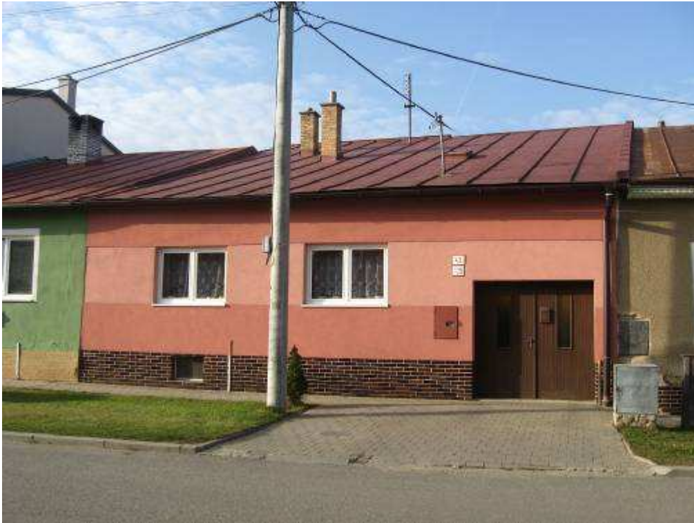
237. Bernolákova ulica č. 225/43, parc. č. 542 – objekt rešpektujúci pamiatkové hodnoty územia
