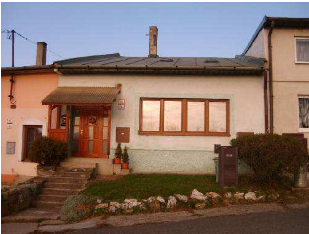
262. Povstalecká ulica č. 284/41, parc. č. 138 – objekt rešpektujúci pamiatkové hodnoty územia (konštrukcia markízy nad vstupom a široký okenný otvor sú v území cudzorodé a rušivé)
