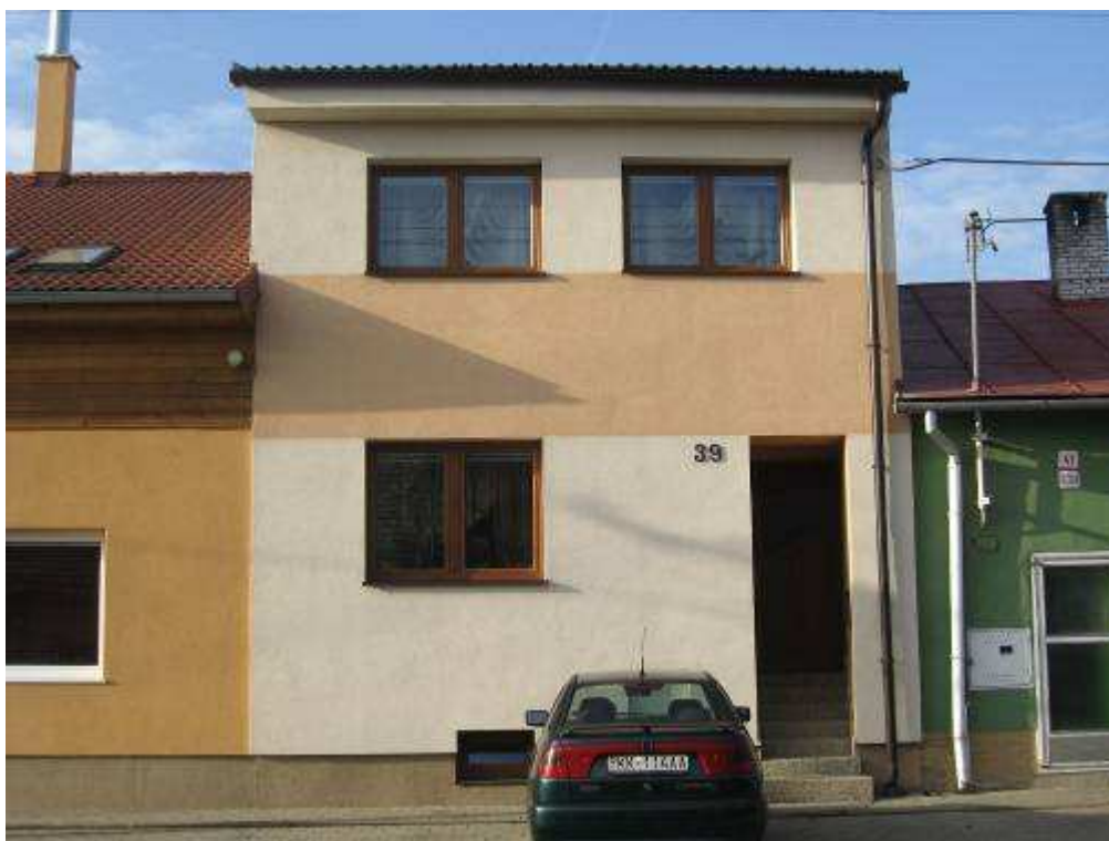
235. Bernolákova ulica č. 223/39, parc. č. 547 – objekt nerešpektujúci pamiatkové hodnoty územia
