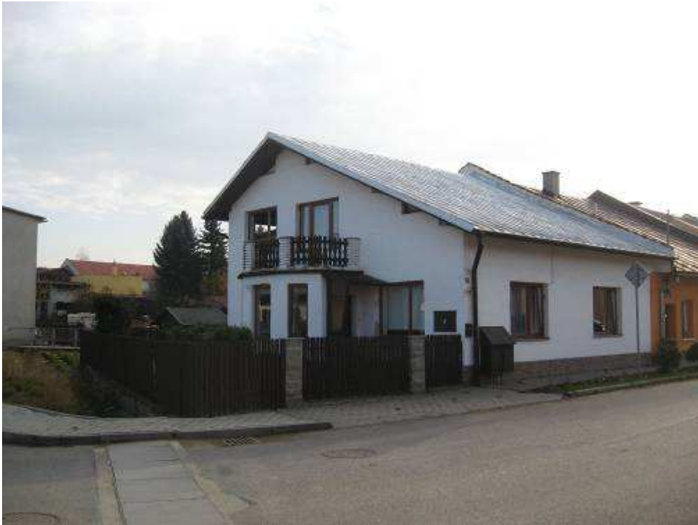
245. Bernolákova ulica č. 1086/10, parc. č. 471 – objekt (novostavba) rešpektujúci pamiatkové hodnoty územia (veranda s balkónom na nárožnom objekte je v území cudzorodá a rušivá)
