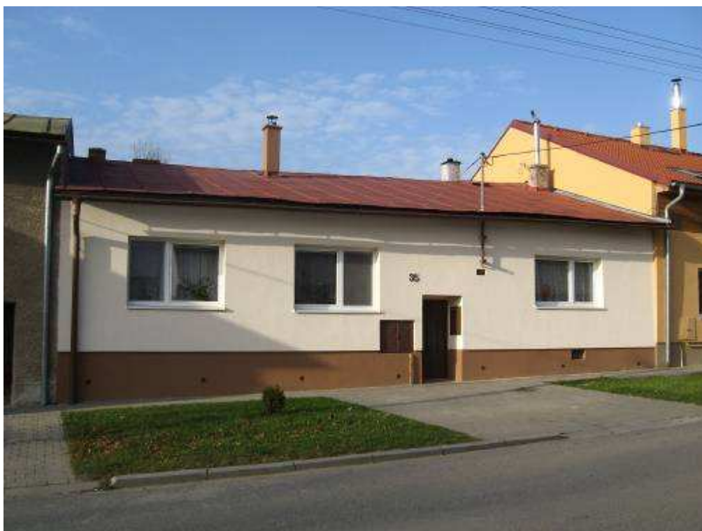
231. Bernolákova ulica č. 221/35, parc. č. 549 – objekt rešpektujúci pamiatkové hodnoty územia
