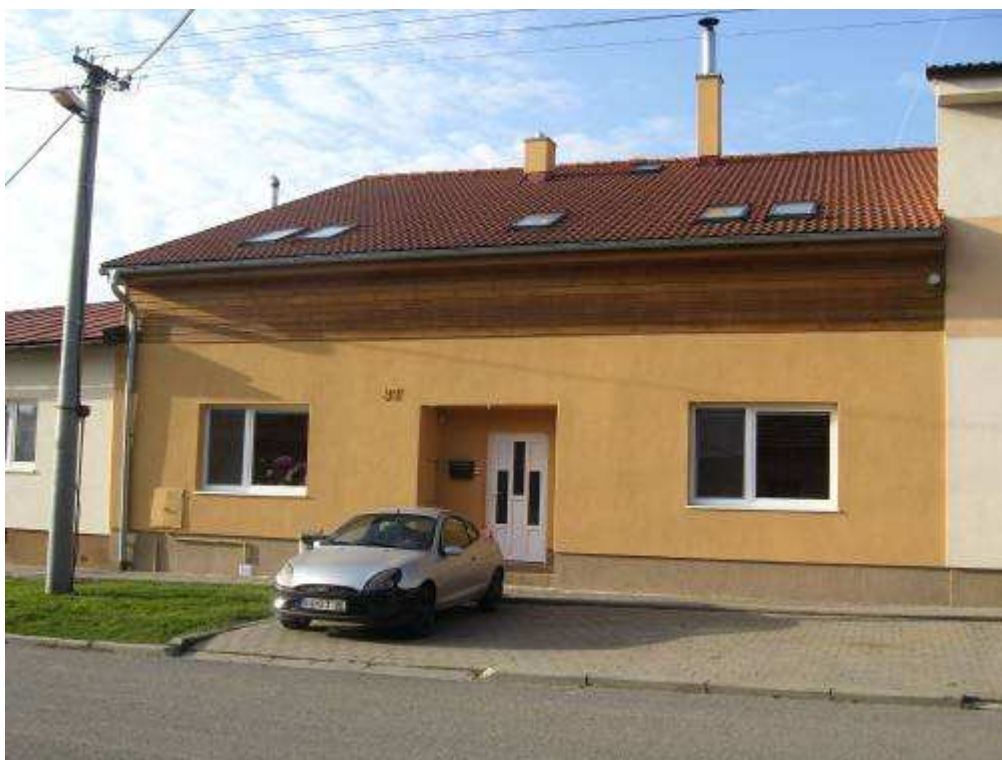
233. Bernolákova ulica č. 222/37, parc. č. 548 – objekt rešpektujúci pamiatkové hodnoty územia
