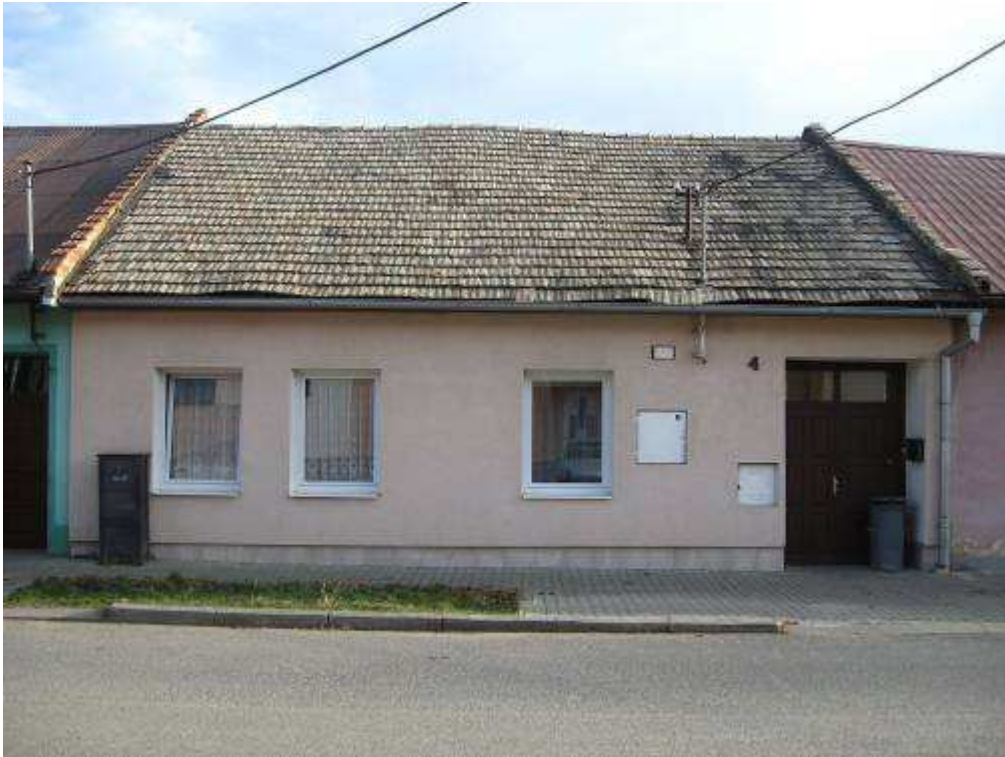
241. Bernolákova ulica č. 240/4, parc. č. 468 – objekt rešpektujúci pamiatkové hodnoty územia
