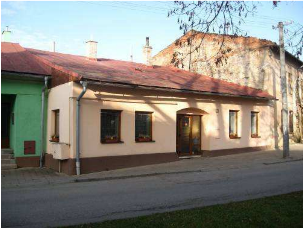
220. Bernolákova ulica č. 215/23, parc. č. 559 – objekt rešpektujúci pamiatkové hodnoty územia
