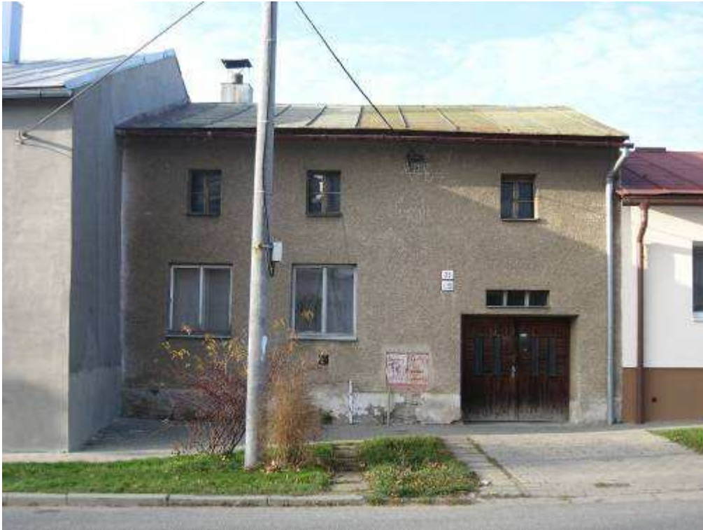
229. Bernolákova ulica č. 220/33, parc. č. 552 – objekt rešpektujúci pamiatkové hodnoty územia
