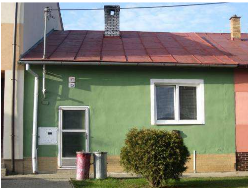
236. Bernolákova ulica č. 224/41, parc. č. 545 – objekt rešpektujúci pamiatkové hodnoty územia
