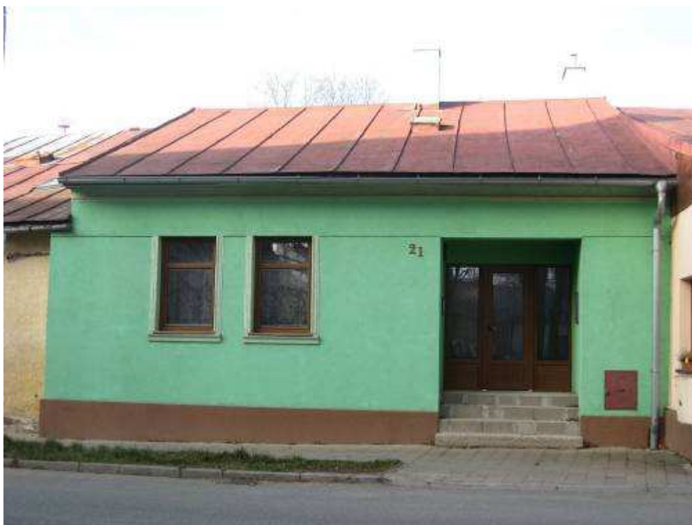
218. Bernolákova ulica č. 214/21, parc. č. 560 – objekt rešpektujúci pamiatkové hodnoty územia
