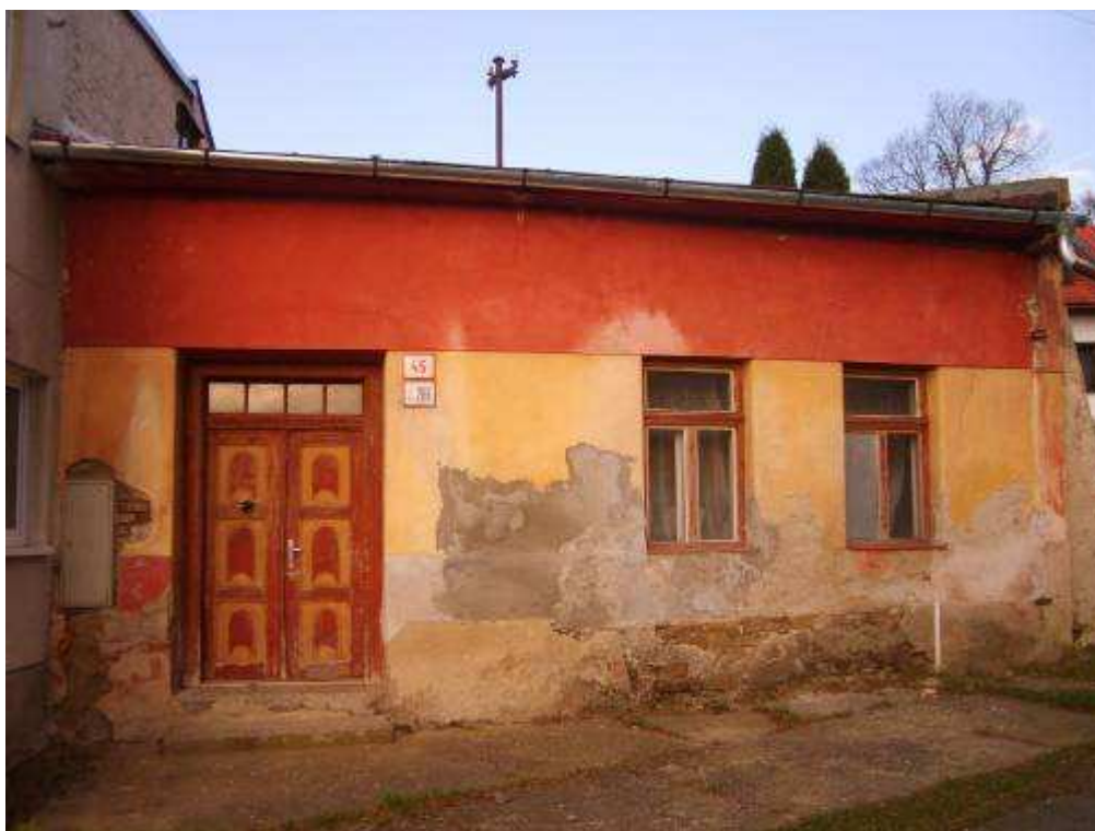
264. Povstalecká ulica č. 286/45, parc. č. 143/1 – objekt s pamiatkovými hodnotami
