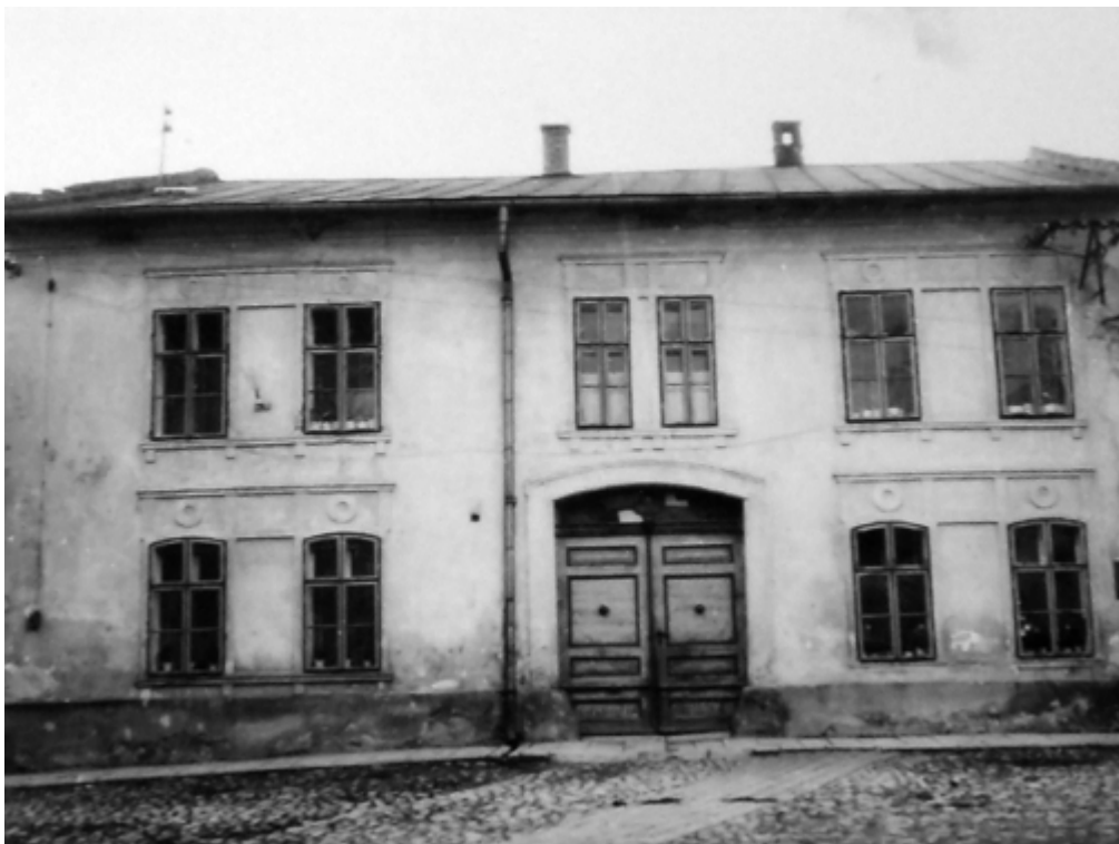
223. Bernolákova ulica č. 216/25, parc. č. 558/1 – objekt v roku 1962 (zdroj: Archív Pamiatkového úradu SR, Borodáč, č. negatívu 34826A)
