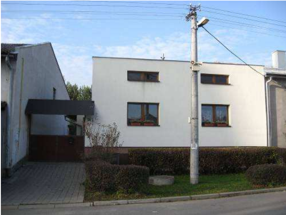
226. Bernolákova ulica č. 218/29, parc. č. 554 – objekt (novostavba) nerešpektujúci pamiatkové hodnoty územia
