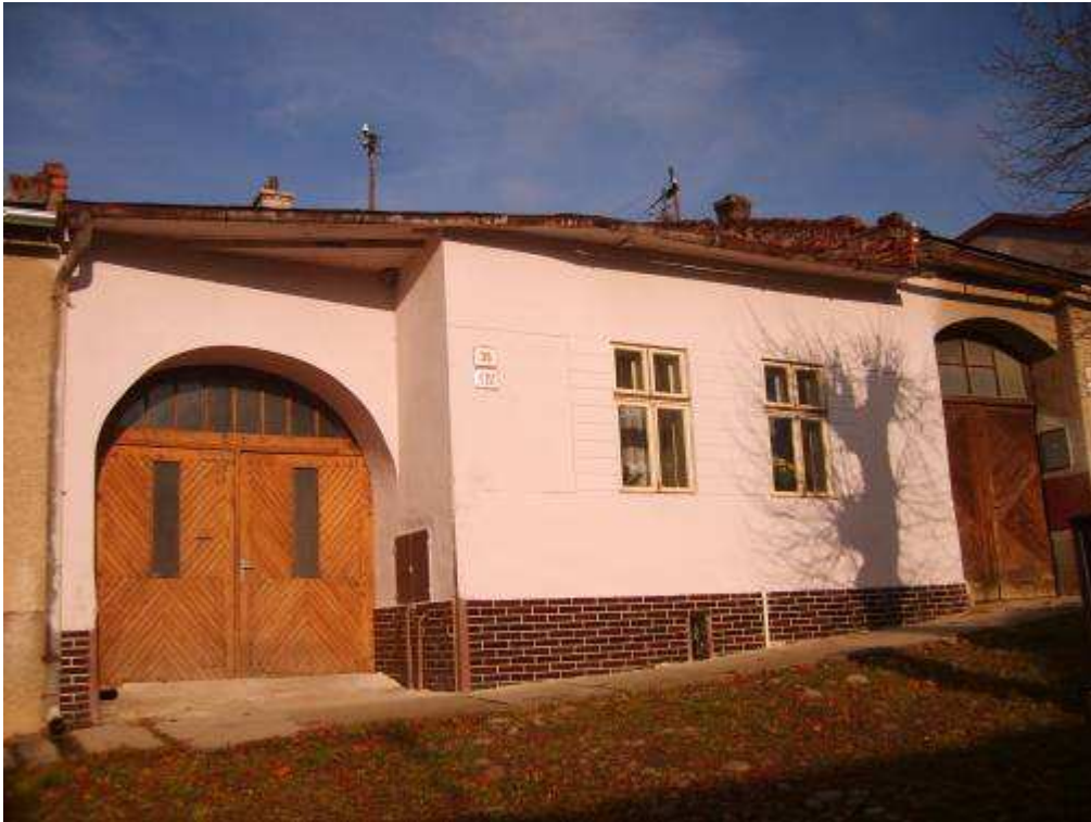
257. Povstalecká ulica č. 257/36, parc. č. 74 – objekt s pamiatkovými hodnotami
