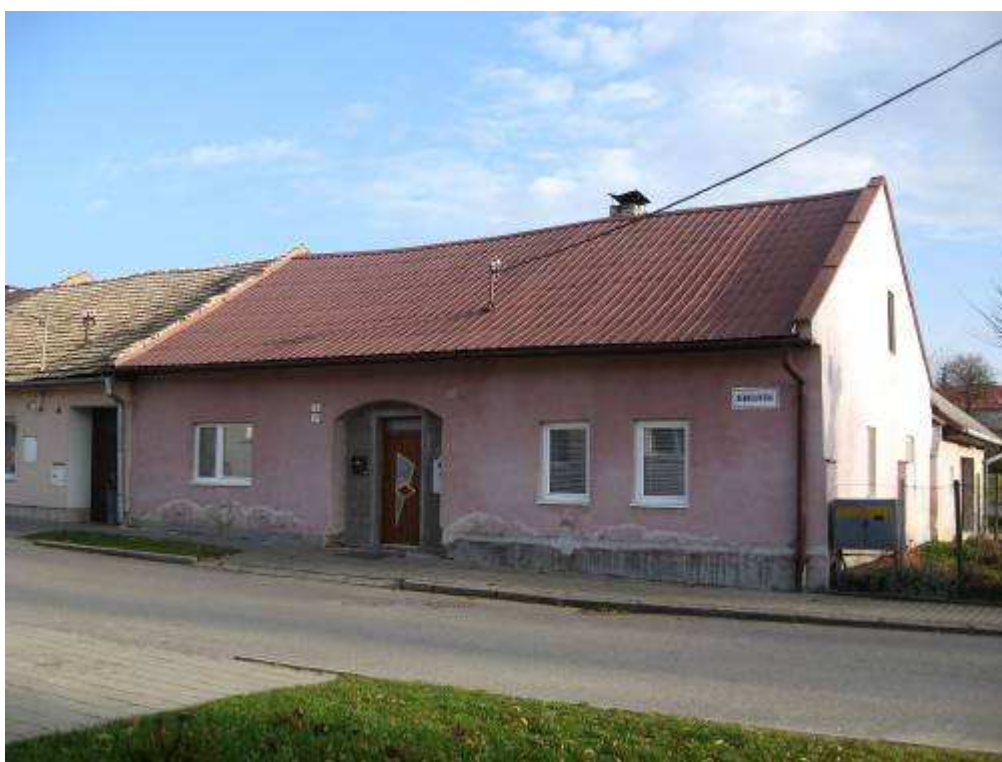
240. Bernolákova ulica č. 241/2, parc. č. 466 –objekt rešpektujúci pamiatkové hodnoty územia
