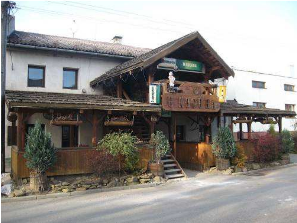
224. Bernolákova ulica č. 217/27, parc. č. 555 – objekt rešpektujúci pamiatkové hodnoty územia (predimenzovaná terasa pred hlavnou fasádou je v území cudzorodá a hmotovo rušivá)
