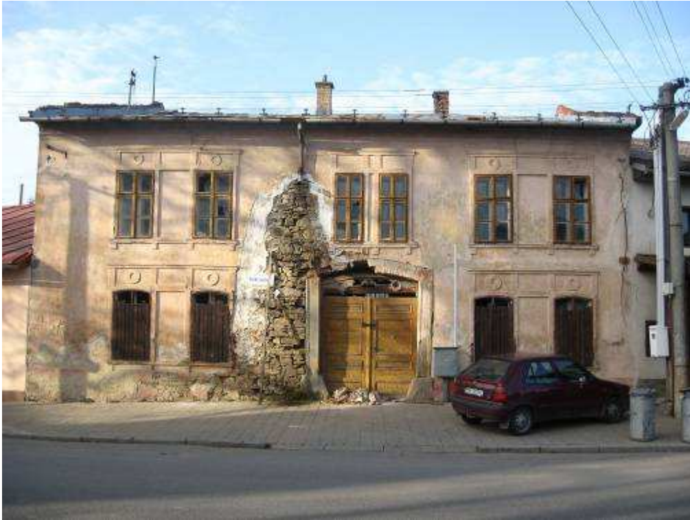
222. Bernolákova ulica č. 216/25, parc. č. 558/1 – objekt rešpektujúci pamiatkové hodnoty územia
