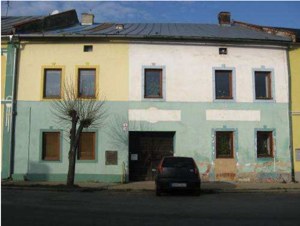
202. Bernolákova ulica č. 205/3, parc. č. 569 – objekt s pamiatkovými hodnotami
