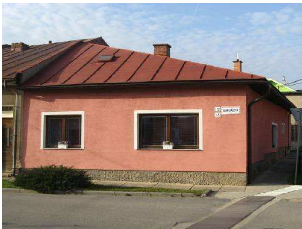
239. Bernolákova ulica č. 227/47, parc. č. 540 –objekt rešpektujúci pamiatkové hodnoty územia
