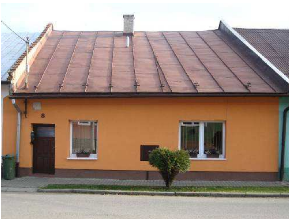
243. Bernolákova ulica č. 238/8, parc. č. 470 – objekt rešpektujúci pamiatkové hodnoty územia
