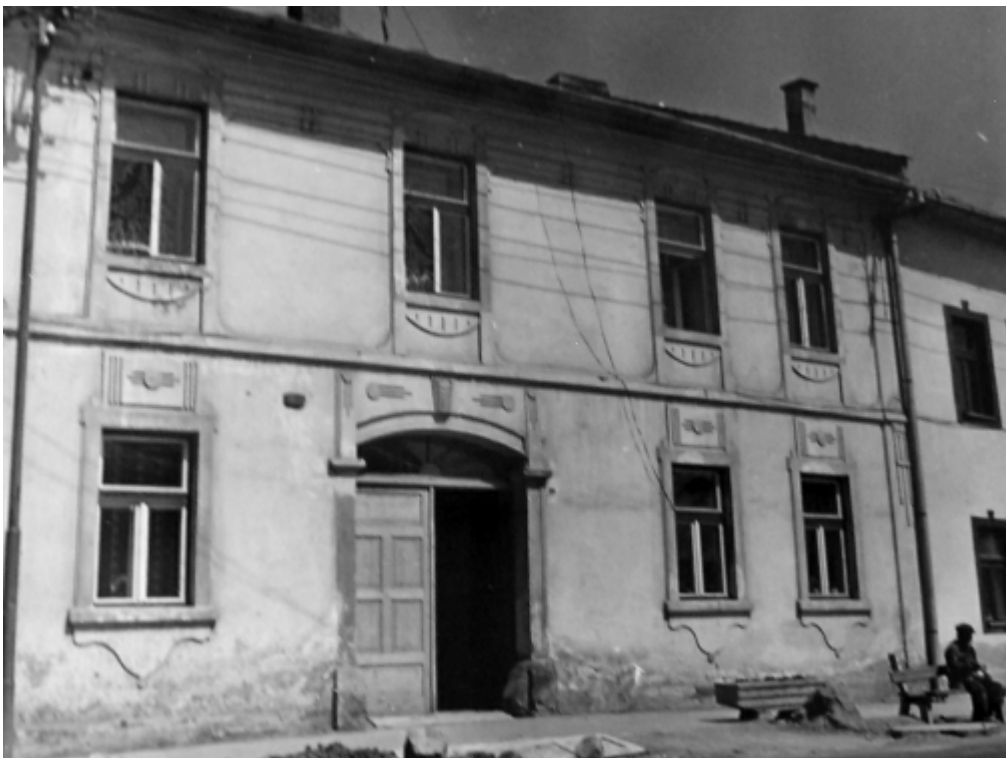
201. Bernolákova ulica č. 204/1, parc. č. 570 – objekt v roku 1976 (zdroj: Archív Pamiatkového úradu SR, Motaj, č. negatívu 75699)
