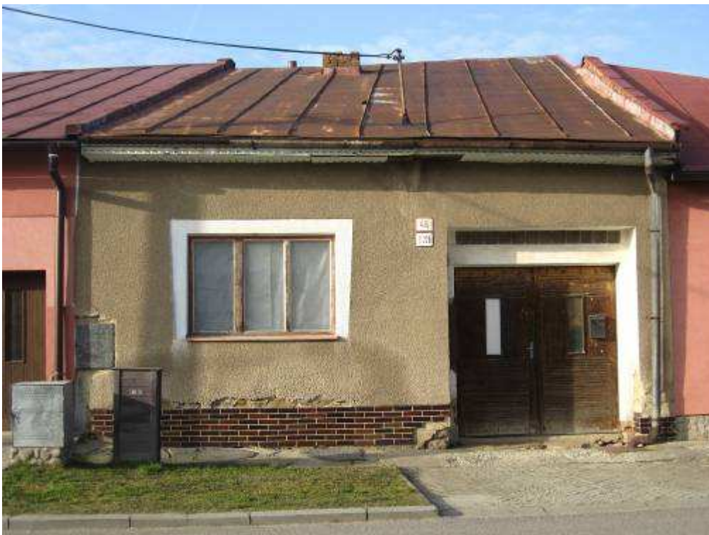
238. Bernolákova ulica č. 226/45, parc. č. 541/1 – objekt rešpektujúci pamiatkové hodnoty územia
