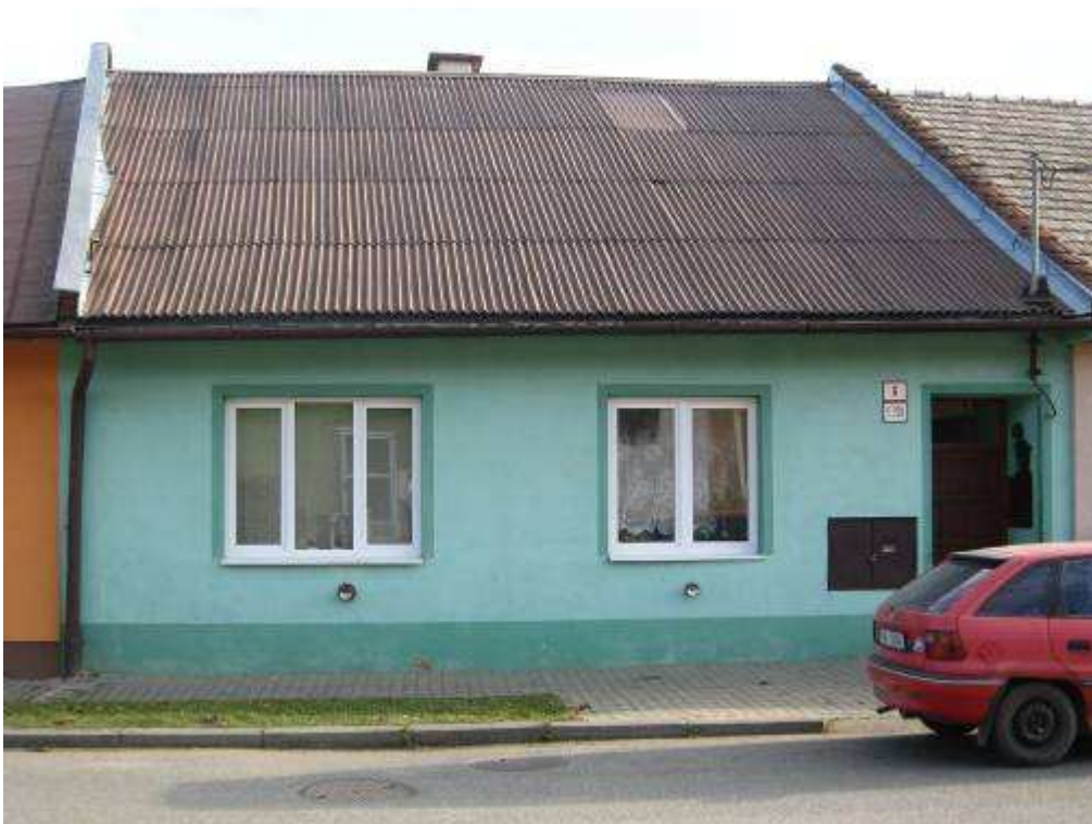
242. Bernolákova ulica č. 239/6, parc. č. 469 – objekt rešpektujúci pamiatkové hodnoty územia
