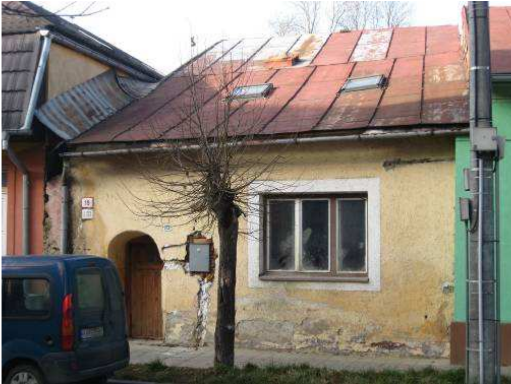
216. Bernolákova ulica č. 213/19, parc. č. 561 – objekt rešpektujúci pamiatkové hodnoty územia
