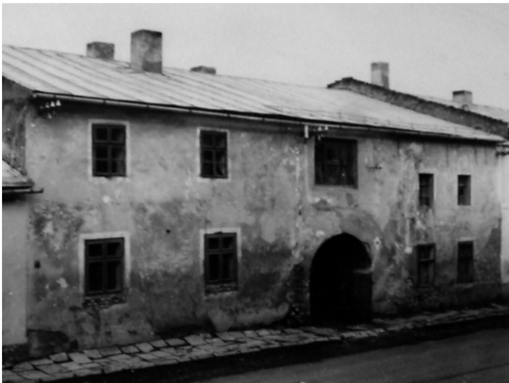
321. Športová ulica staré súp. č. 361 a 362 – pôvodný objekt v roku 1962 (zdroj: Archív Pamiatkového úradu SR, Borodáč, č. negatívu 34849A)
