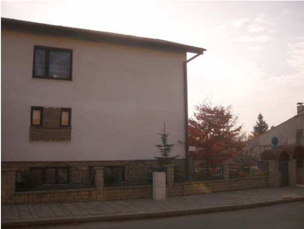
320. Športová ulica č. 1083/30, parc. č. 373/2 – objekt (novostavba) nerešpektujúci pamiatkové hodnoty územia
