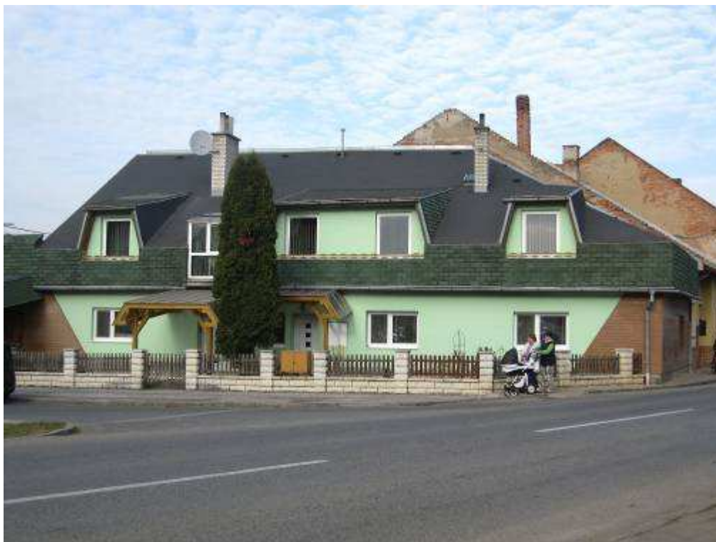
371. Vrbovská ulica č. 92/30, parc. č. 1461/1 – objekt (novostavba) nerešpektujúci pamiatkové hodnoty územia
