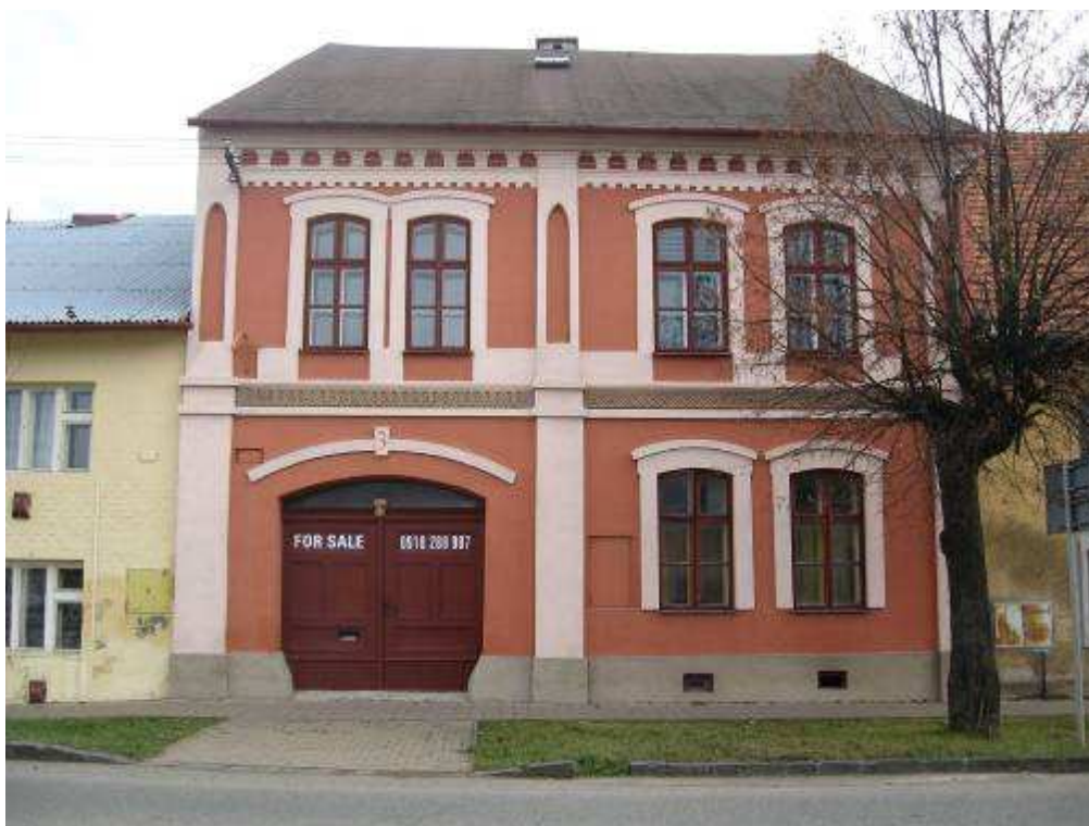
332. Vrbovská ulica č. 378/3, parc. č. 1472 – objekt vytypovaný na vyhlásenie za NKP
