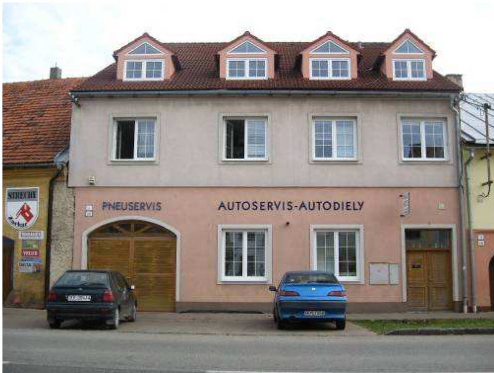
336. Vrbovská ulica č. 380/7, parc. č. 1474/2 – objekt (novostavba) nerešpektujúci pamiatkové hodnoty územia
