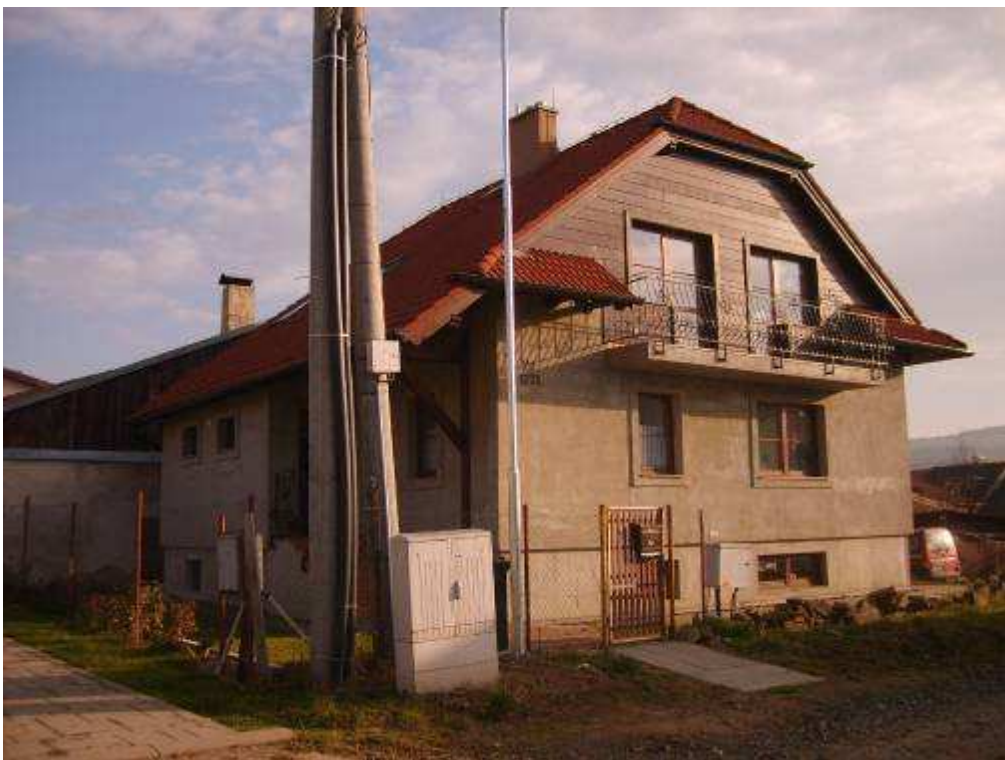
316. Športová ulica č. 1771/24, parc. č. 380 – objekt (novostavba) nerešpektujúci pamiatkové hodnoty územia
