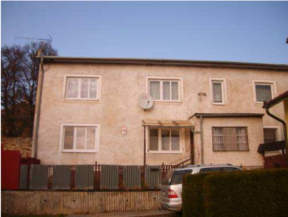
299. Športová ulica č. 311/29, parc. č. 153 – objekt (novostavba) nerešpektujúci pamiatkové hodnoty územia
