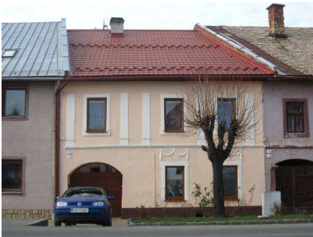
358. Vrbovská ulica č. 100/16, parc. č. 1448/3 – objekt vytypovaný na vyhlásenie za NKP
