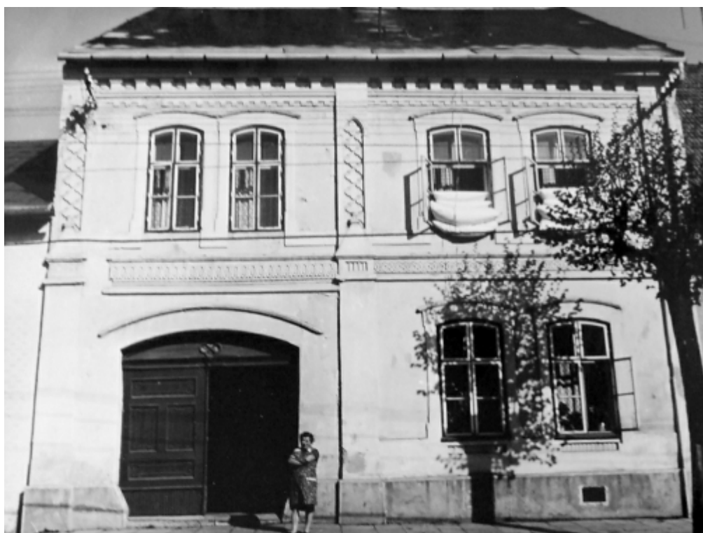
333. Vrbovská ulica č. 378/3, parc. č. 1472 – objekt v roku 1976 (zdroj: Archív Pamiatkového úradu SR, Motaj, č. negatívu 75709)
