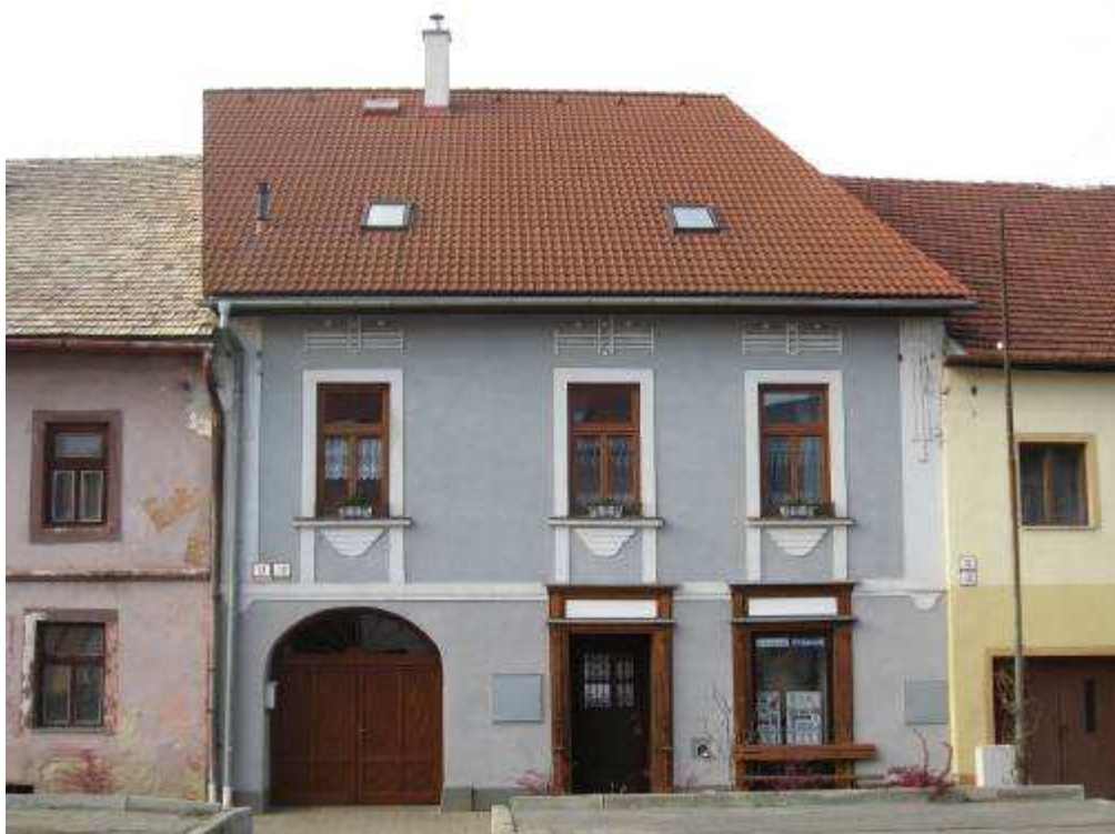
354. Vrbovská ulica č. 102/12, parc. č. 1446 – objekt vytypovaný na vyhlásenie za NKP
