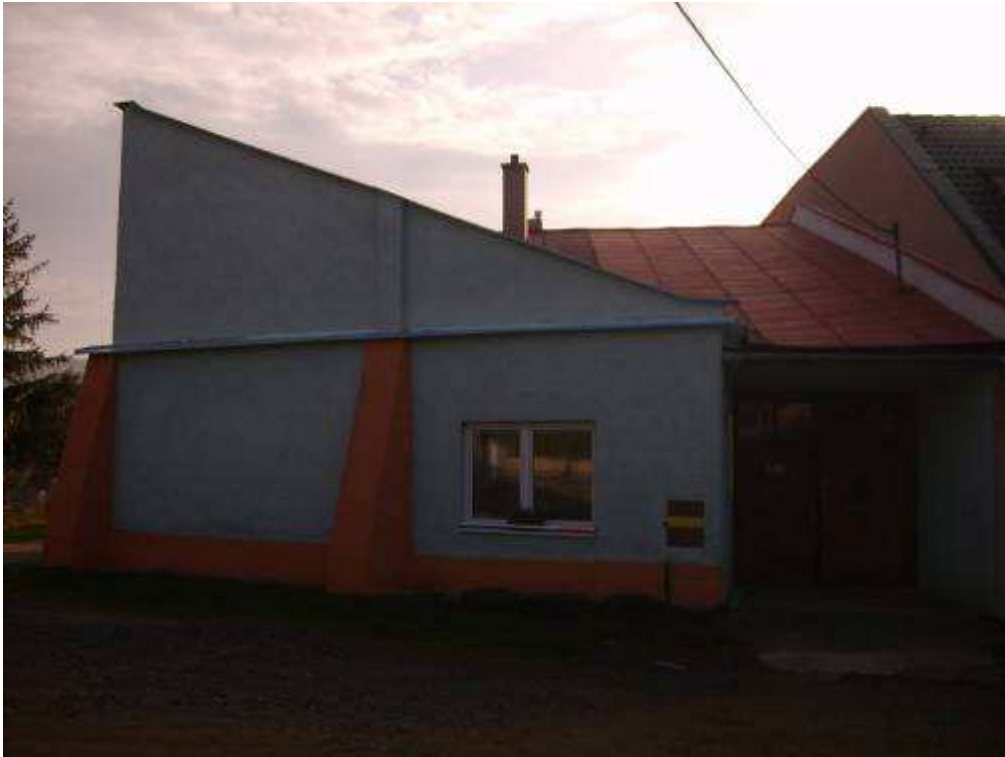
315. Športová ulica č. 368/18, parc. č. 386 – objekt nerešpektujúci pamiatkové hodnoty územia (štít, ktorý vznikol po odstránení susedného objektu, je v dnešnej situácii rušivý )
