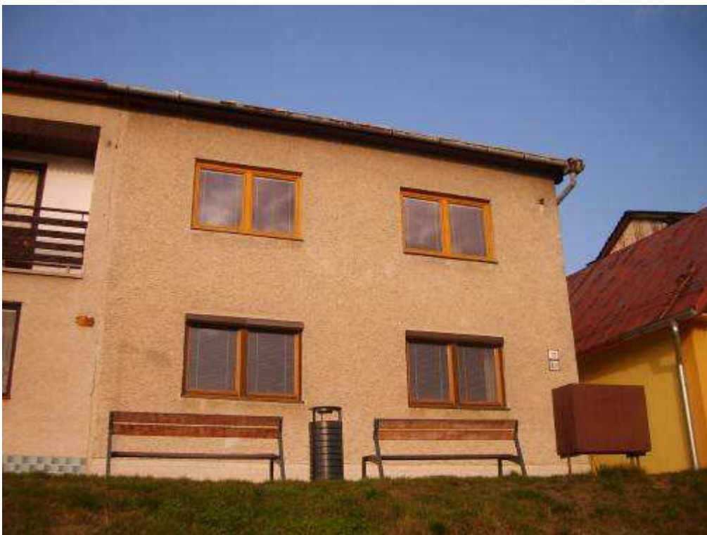
286. Športová ulica č. 958/13, parc. č. 18 – objekt (novostavba) nerešpektujúci pamiatkové hodnoty územia
