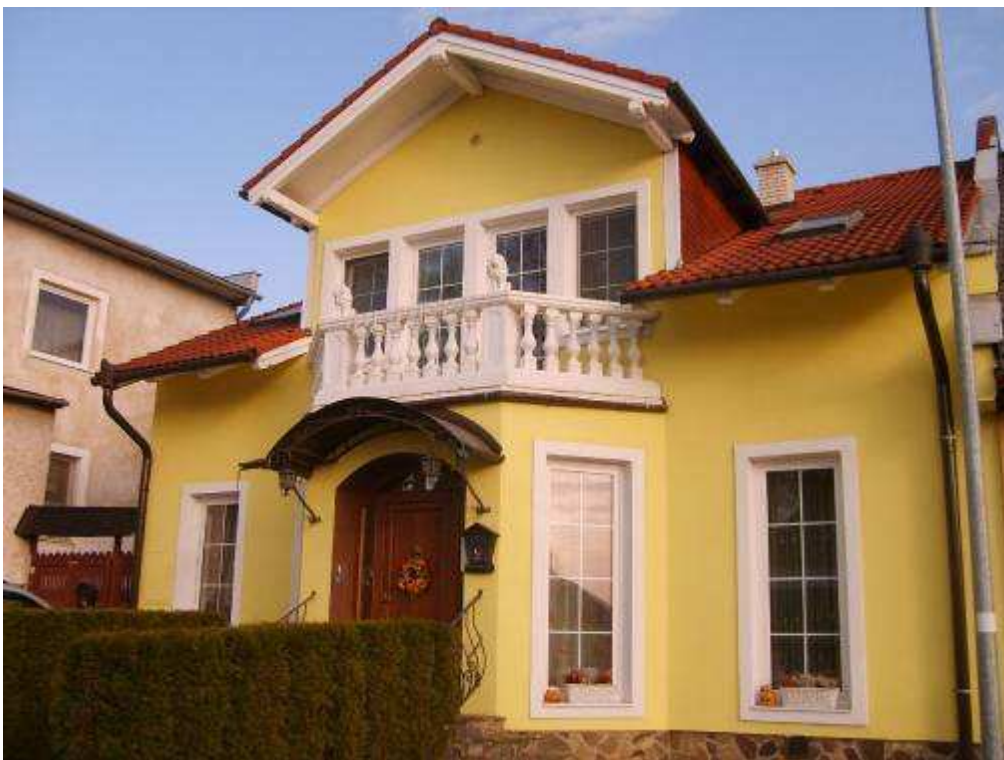
300. Športová ulica č. 312/31, parc. č. 154 – objekt (novostavba) nerešpektujúci pamiatkové hodnoty územia
