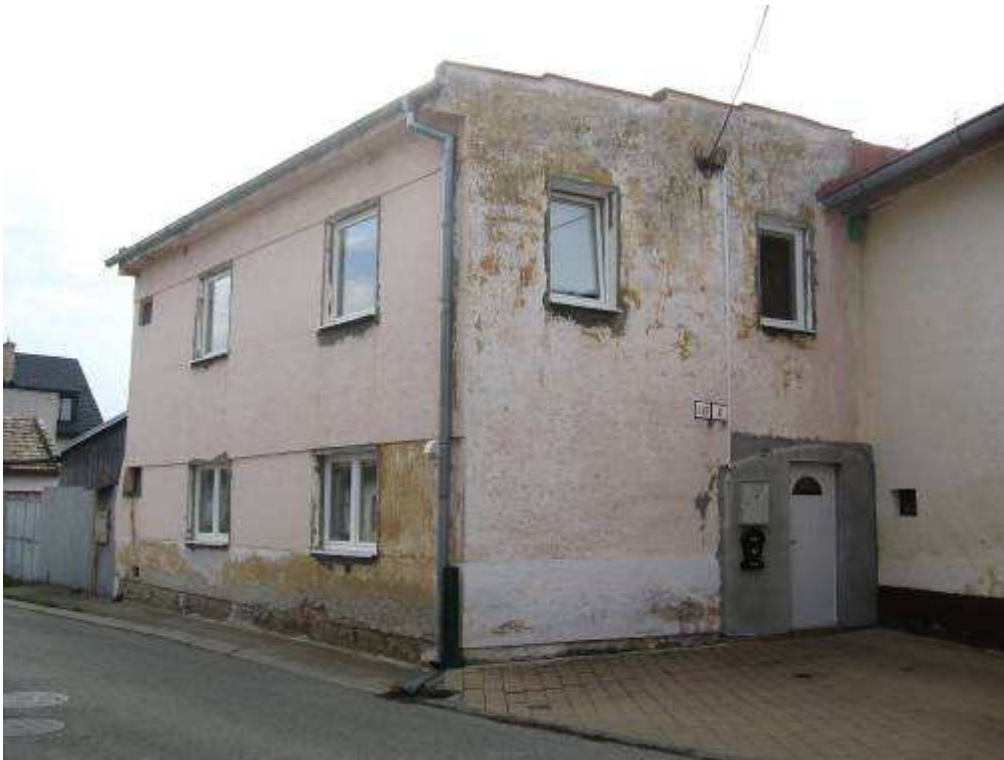
378. Kruhov ulica . 431/6, parc. . 1678 – objekt (novostavba) repektujci pamiatkov hodnoty zemia
