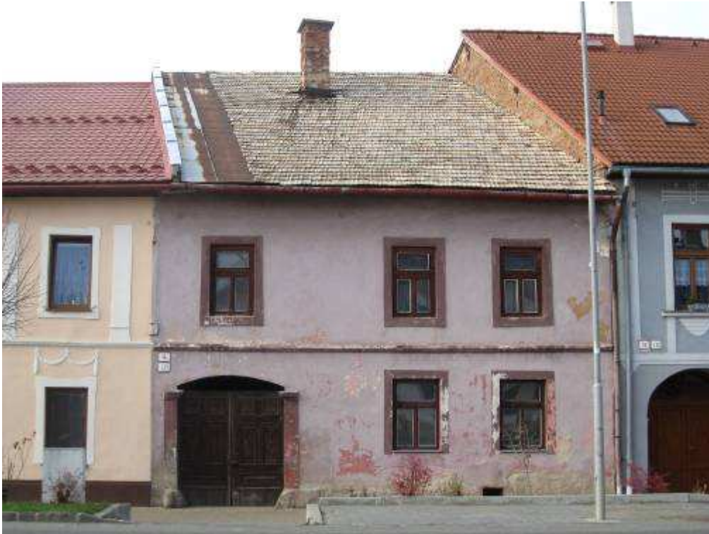
356. Vrbovská ulica č. 101/14, parc. č. 1447 – objekt vytypovaný na vyhlásenie za NKP
