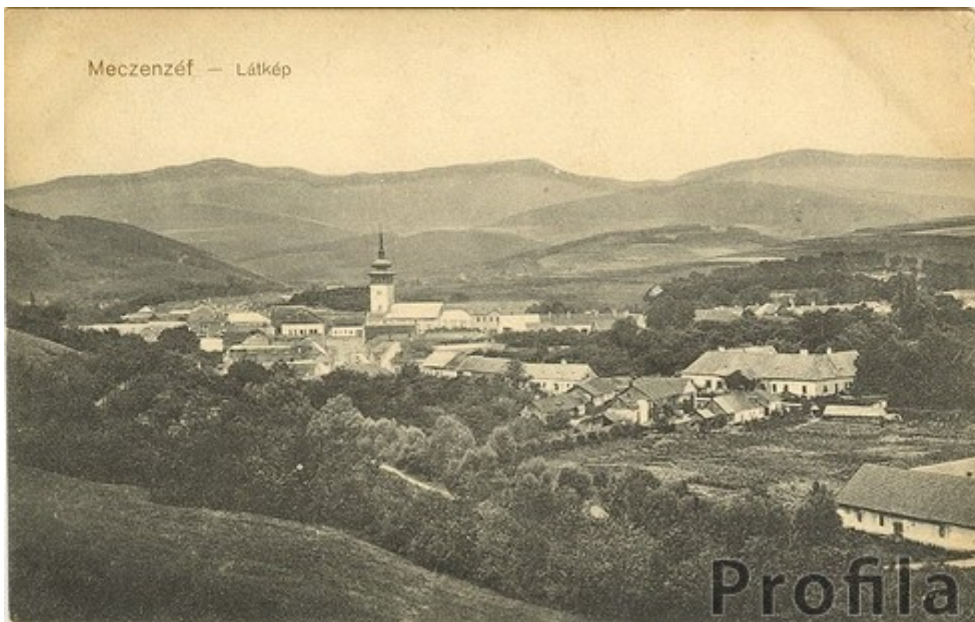
11. Pohľad na strednú a východnú časť mesta od Strážneho kopca na začiatku 20. storočia.
