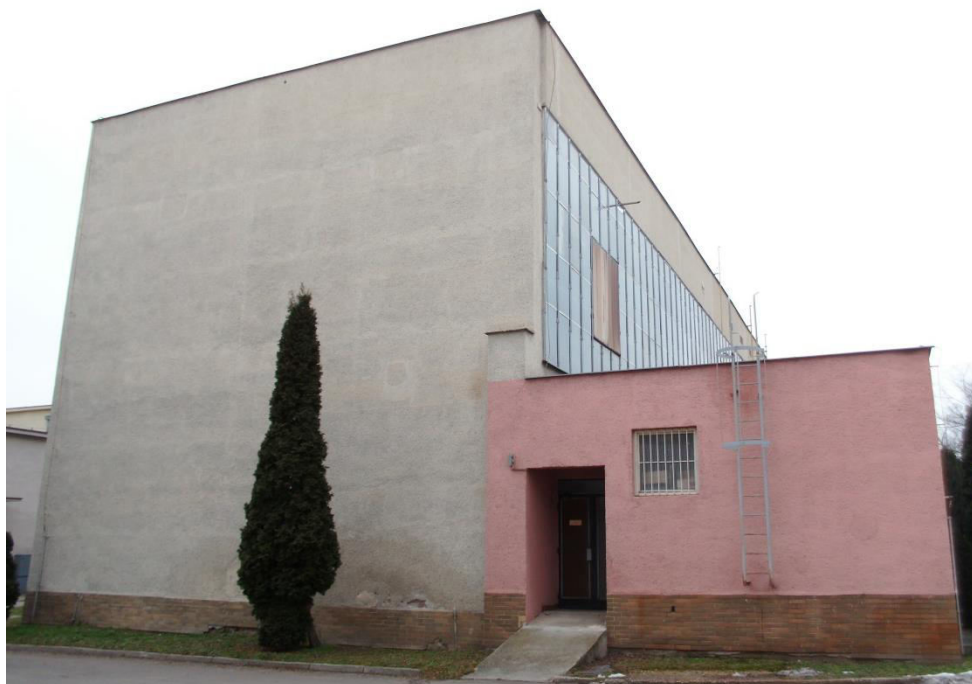
pohľad zo severovýchodu
