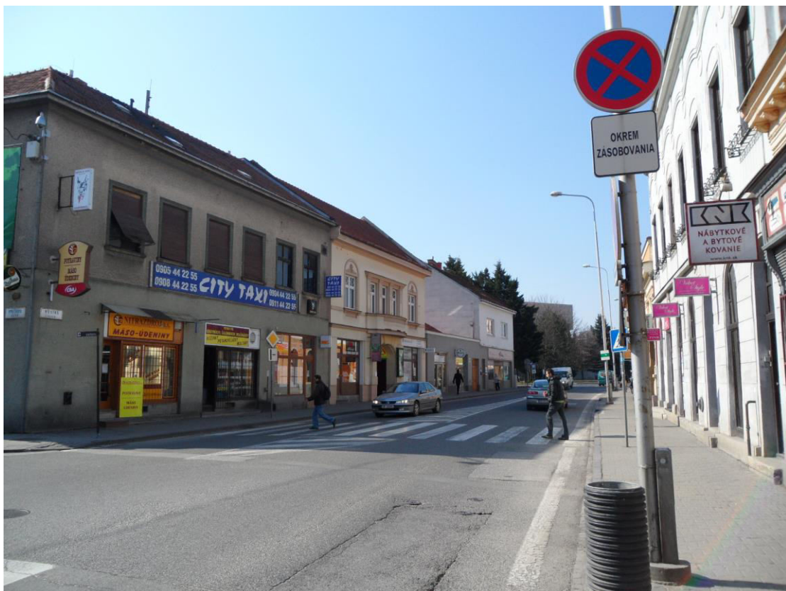
D. 8 Pohľad na pôvodnú zástavbu ulice Mostná
