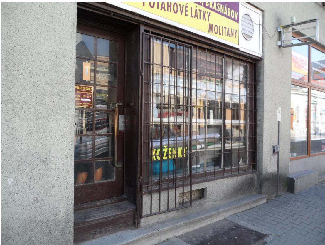
D. 9 Pohľad na pôvodný funkcionalistický výkladec na objekte Kmeťkova č. 2 (parc. č. 1605/1)
