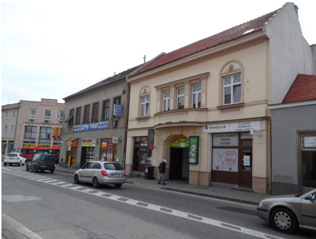
D. 2 Ulica Mostná, pôvodná pamiatkovo hodnotná zástavba
