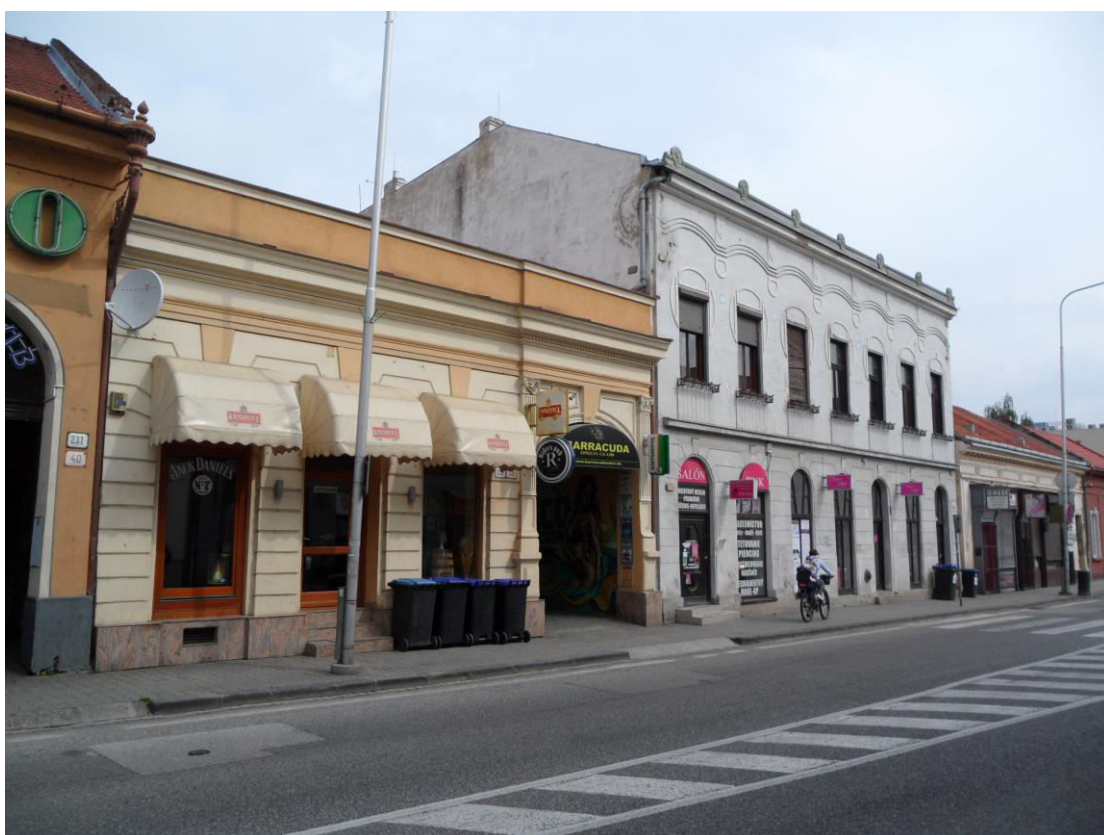
D. 4 Pohľad na pamiatkovo hodnotnú pôvodnú zástavbu na ulici Mostná
