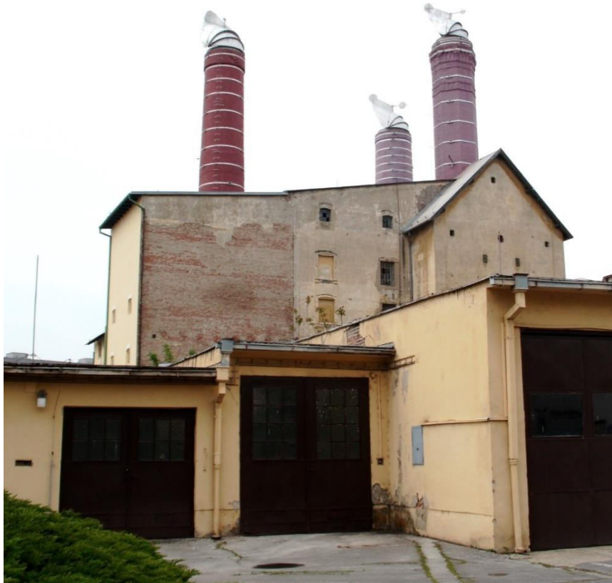
N. 7 Pohľad na bývalú sladovňu z juhovýchodu, koniec 19. storočia
