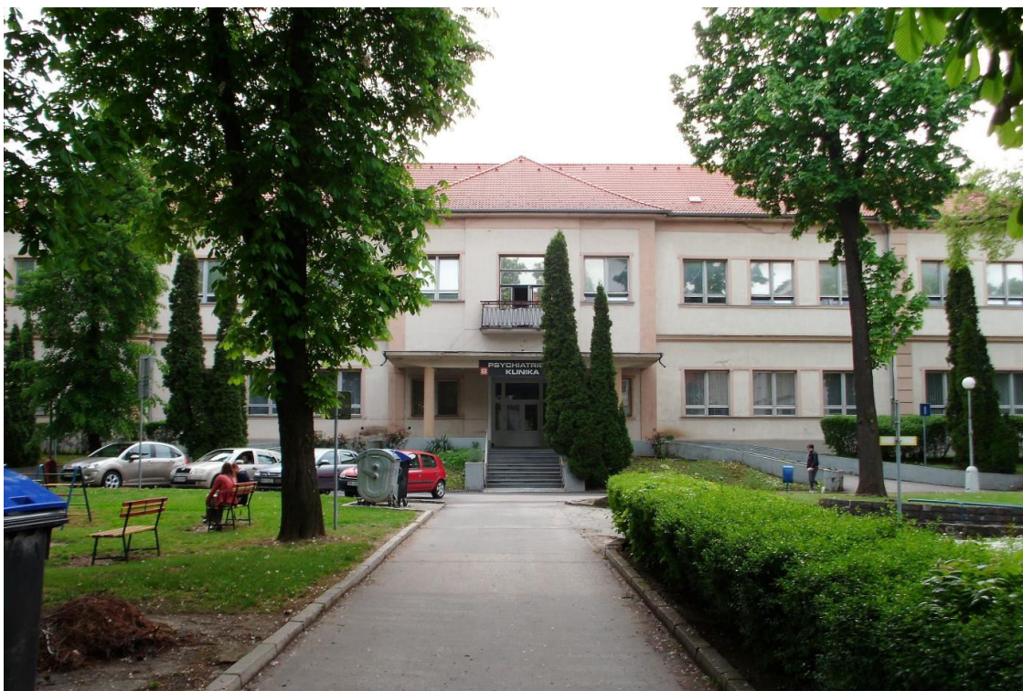
N. 11 Pohľad na severovýchodnú fasádu nadstavaného pavilónu psychiatrického oddelenia orientovanú smerom k hlavnej budove bývalej župnej nemocnice a sadovú úpravu medzi oboma objektmi
