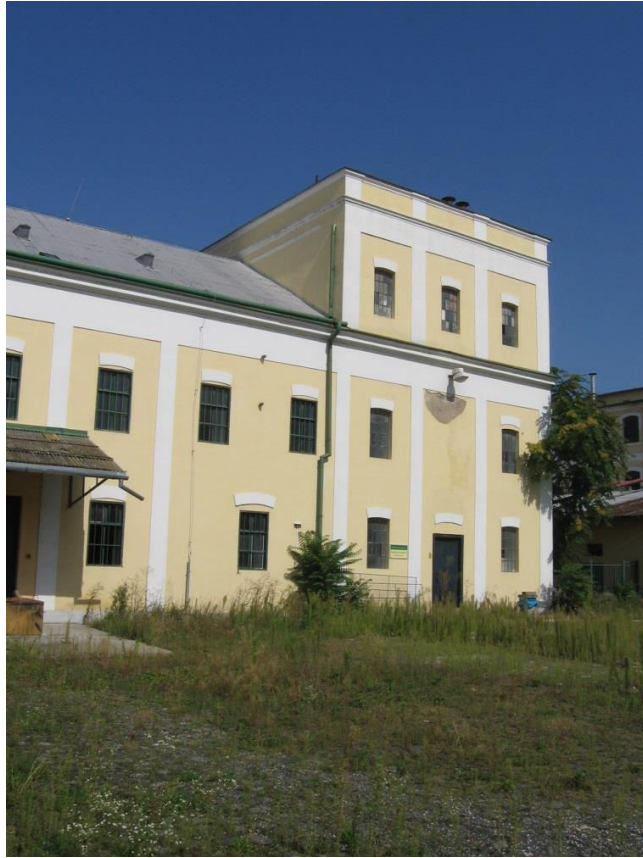
N. 5 Severozápadné krídlo budovy skladu a úpravy jačmeňa v areáli bývalej sladovne z nádvorja
