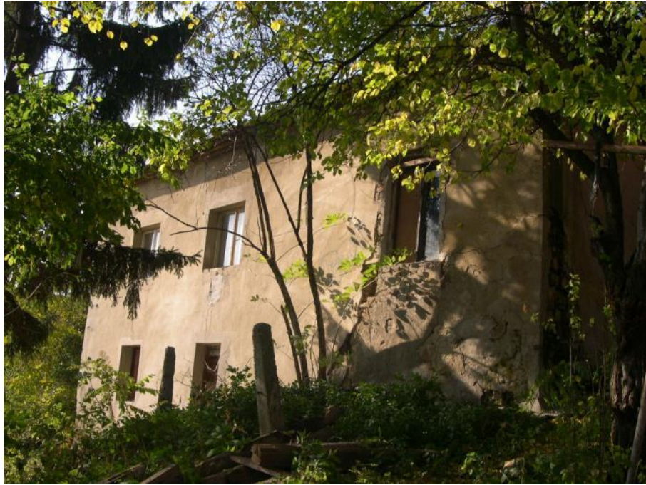
65. Gabrišova ul. – dvorová fasáda objektu vo východnej zástavbe
