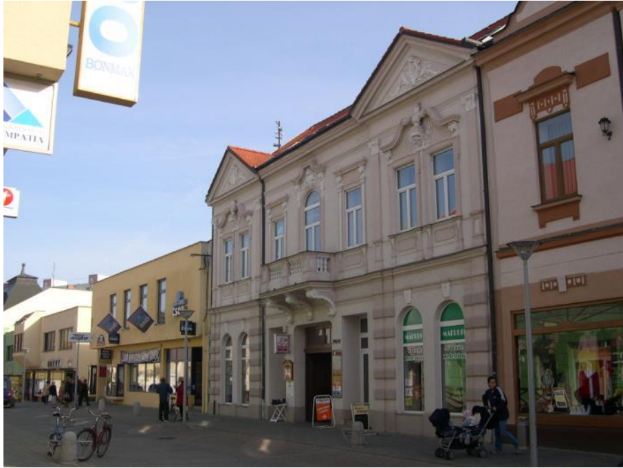
19. Ul. Čsl. armády – zástavba východnej časti
