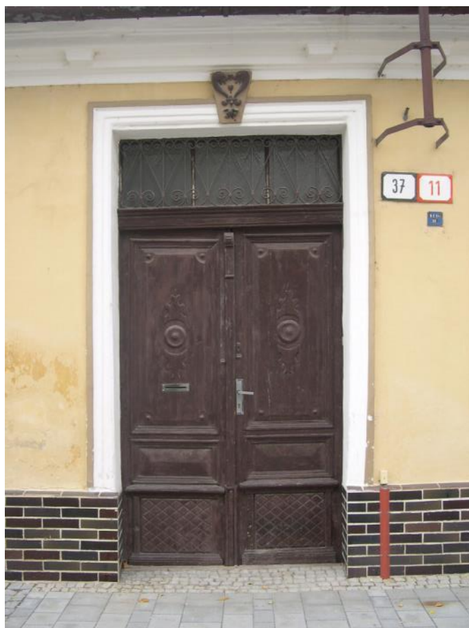
57. Detail vchodových dverí na Ul. P. Matejku
