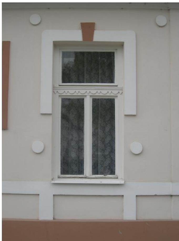
53. Detail okna – objekt na Ulici P. Matejku
