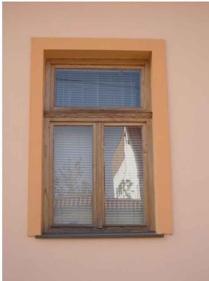
66. Gábrišova ul. – západná zástavba, okenný otvor
