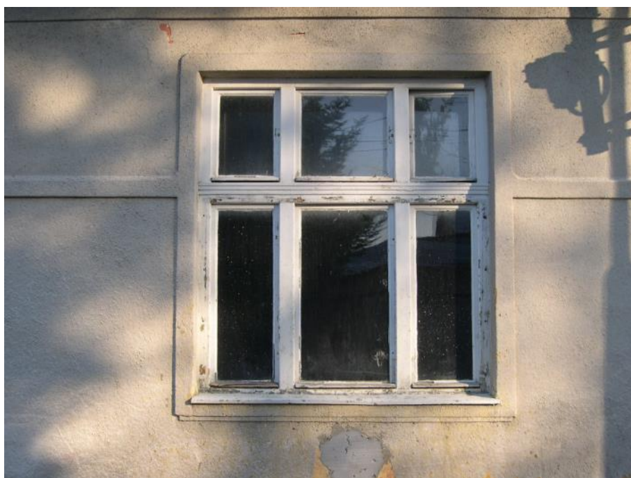
4. Kmeťova ulica -detail okna
