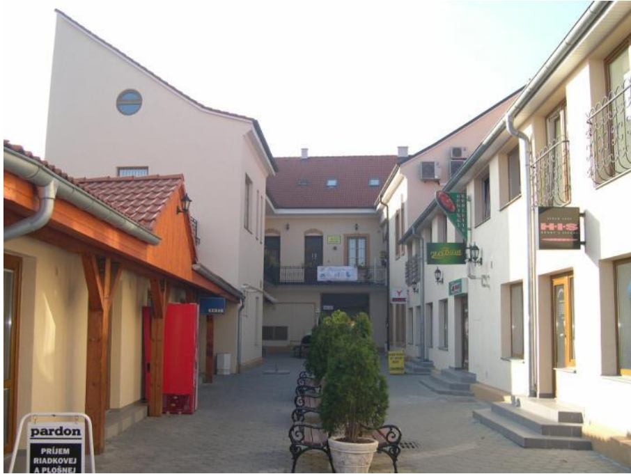
69. Dvorová časť objektu na Ulici Čsl. armády – východná zástavba
