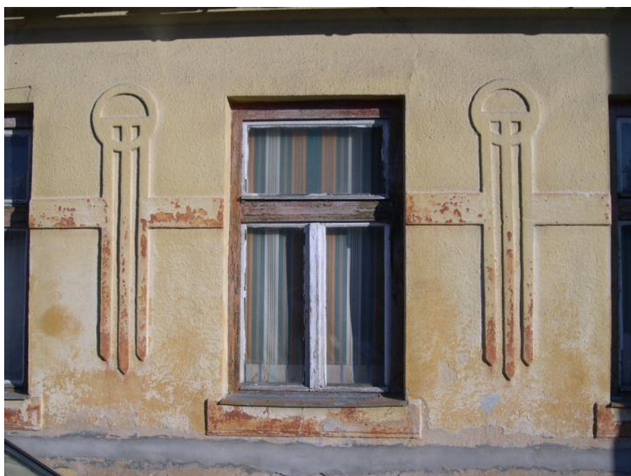
6. Kmeťova ulica, detail okna – secesné
