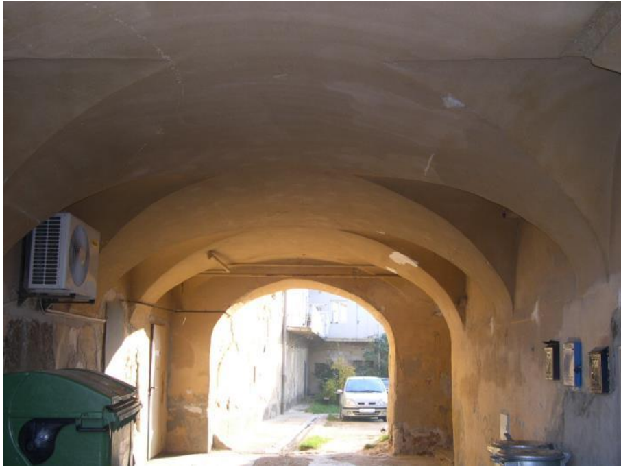
77. Podbránie objektu č. 5 na Palkovičovej ulici
