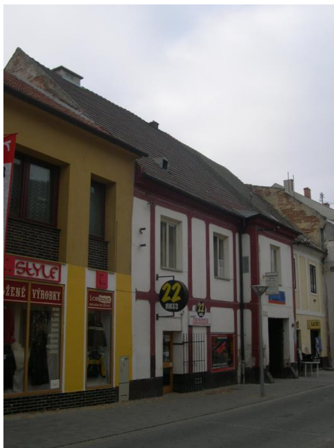
61. Palkovičova ulica – južná zástavba
