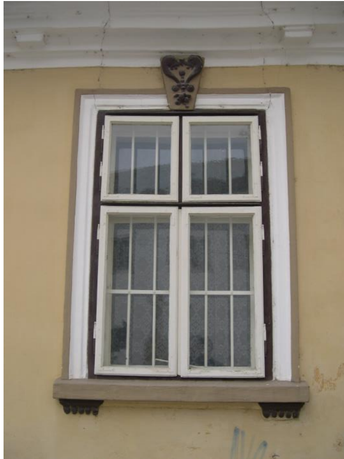
56. Detail okna – objekt na Ulici P. Matejku
