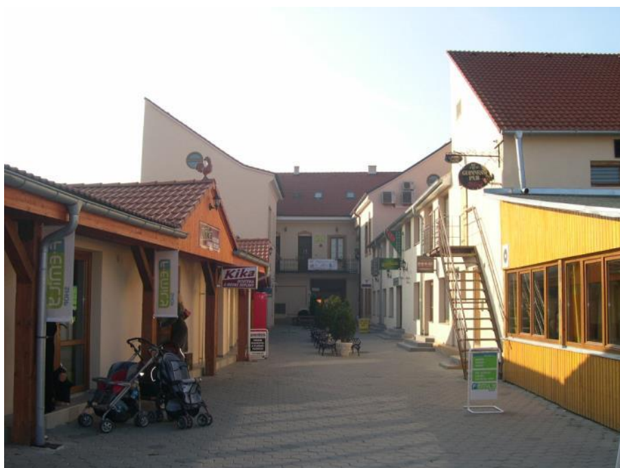
68. Dvorová časť objektu na Ulici Čsl. armády – východná zástavba
