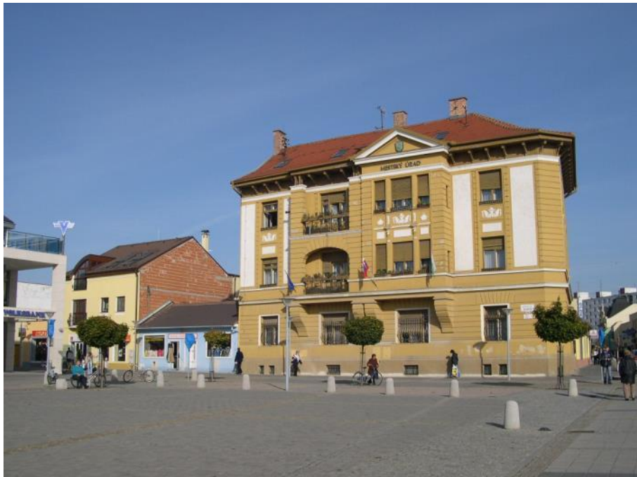
22. Objekt Mestského úradu – fasáda orientovaná do Námestia Slobody
