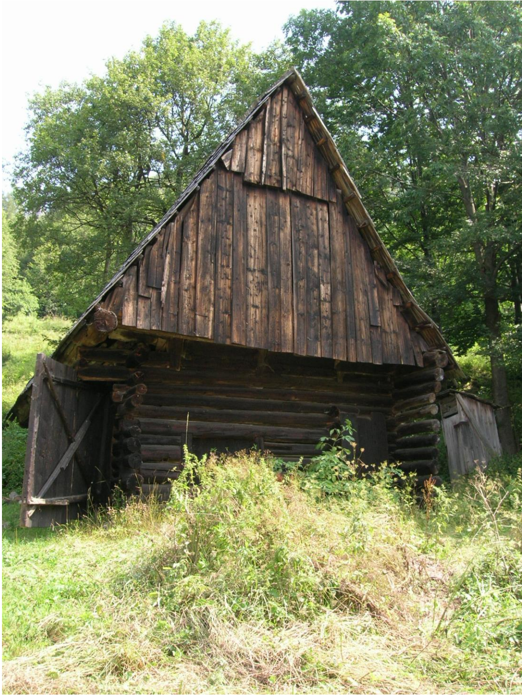
5 hospodársky objekt č.1, pohľad na juhozápadnú fasádu
