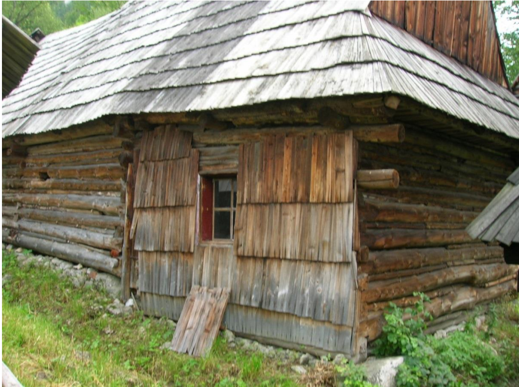
30 detail úpravy zrubovej steny domu č.5
