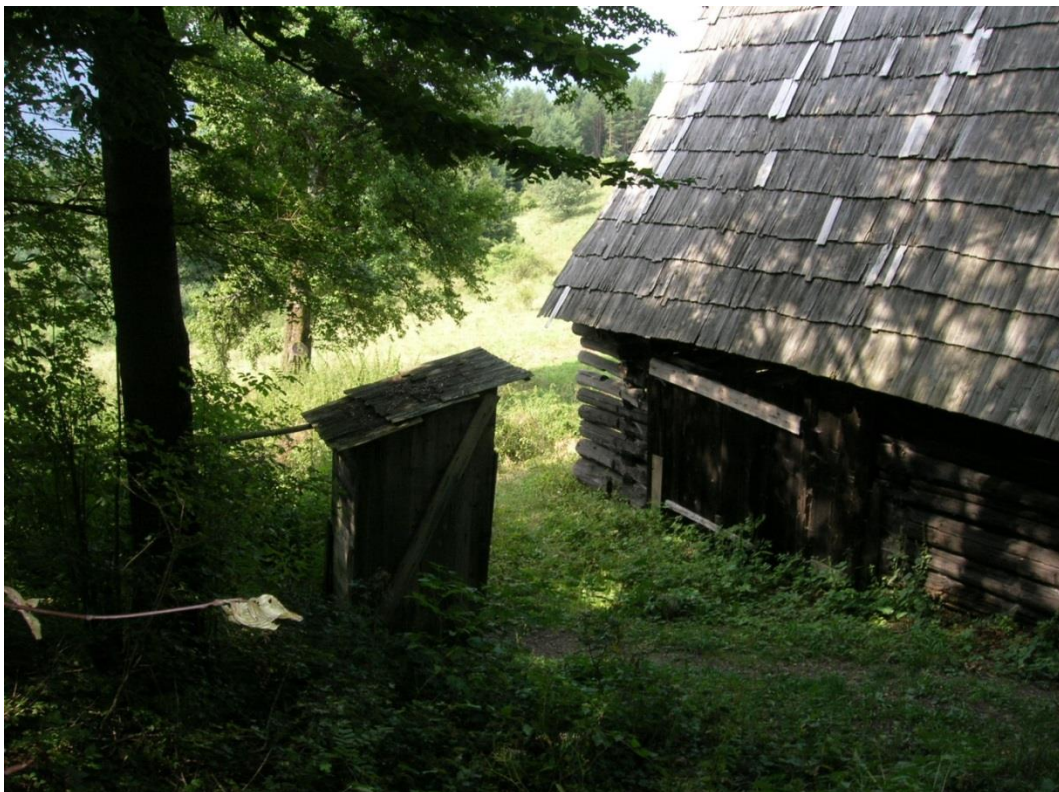
7 hospodársky objekt č.1, pohľad juhovýchodná fasáda
