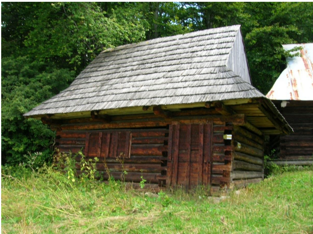
25 pôvodne hospodársky objekt č. 11, západná fasáda
