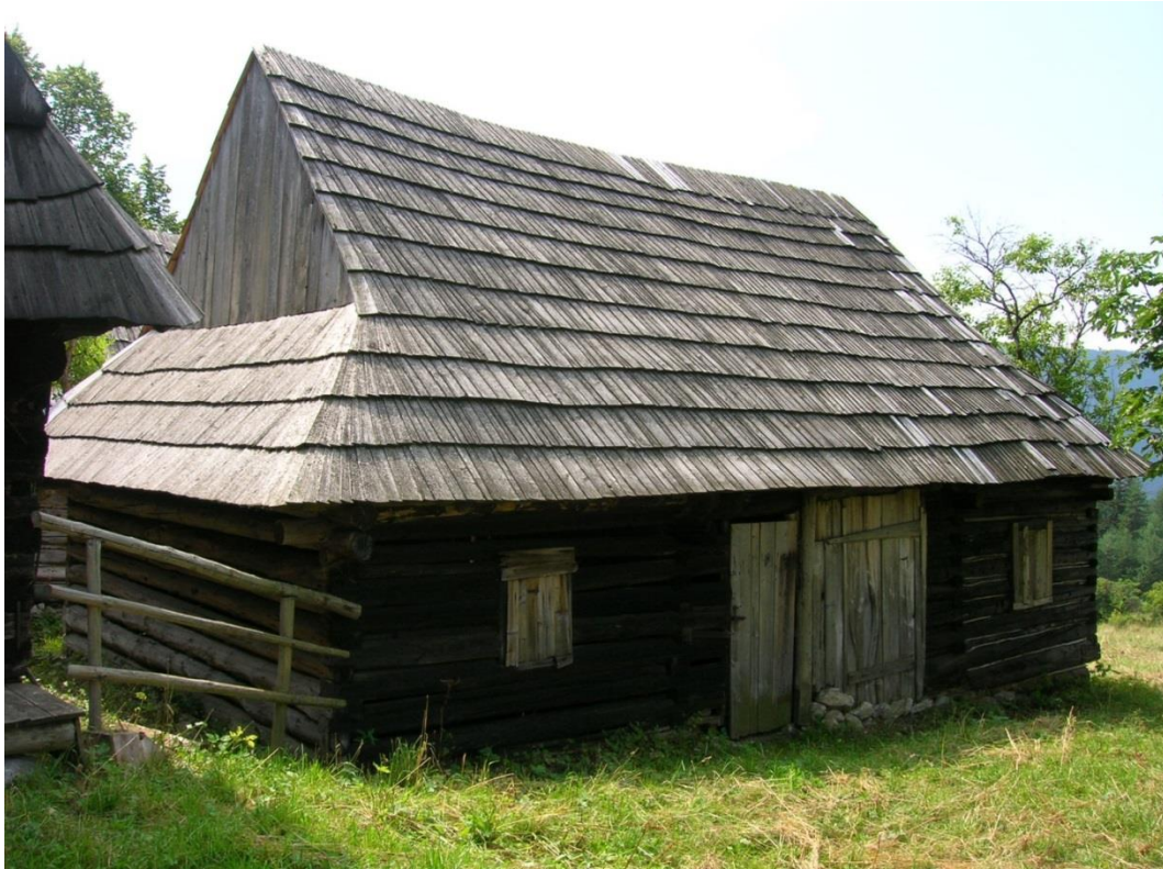
18 obytný dom č.7, severozápadná fasáda
