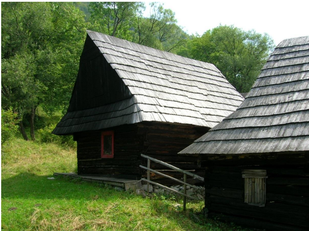
19 obytný dom č.8, západná fasáda
