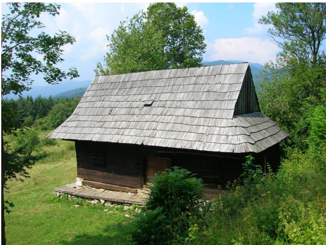
14obytný dom č. 2, juhovýchodná fasáda
