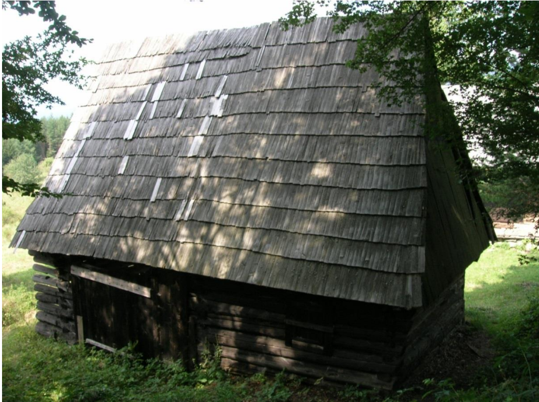
6 hospodársky objekt č.1, pohľad na východnú fasádu
