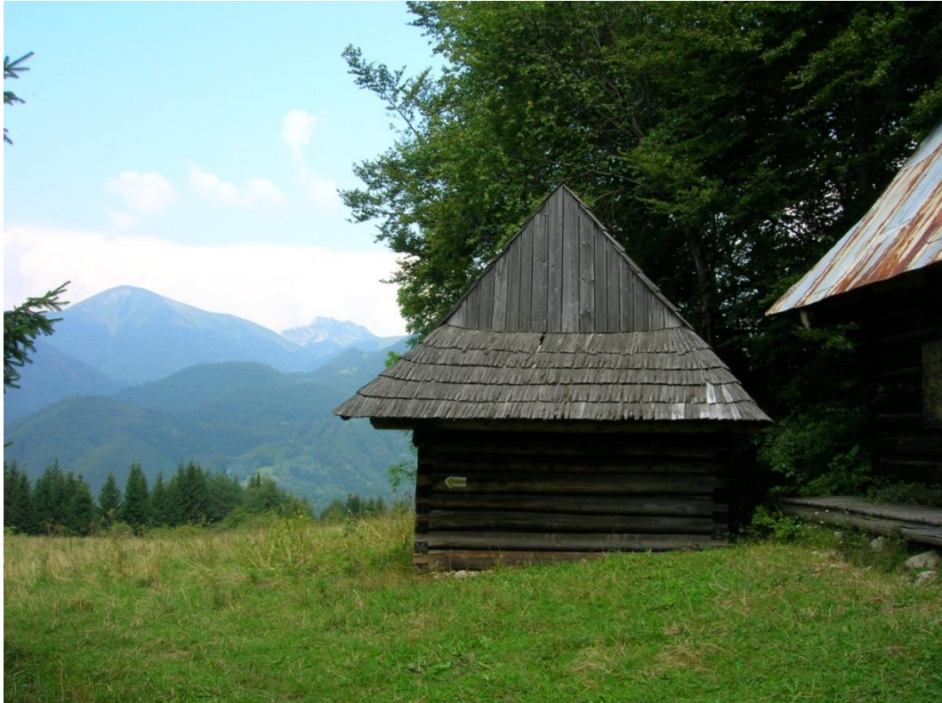
24 pôvodne hospodársky objekt č.11, južná fasáda - pohľad na masív Malej Fatry
