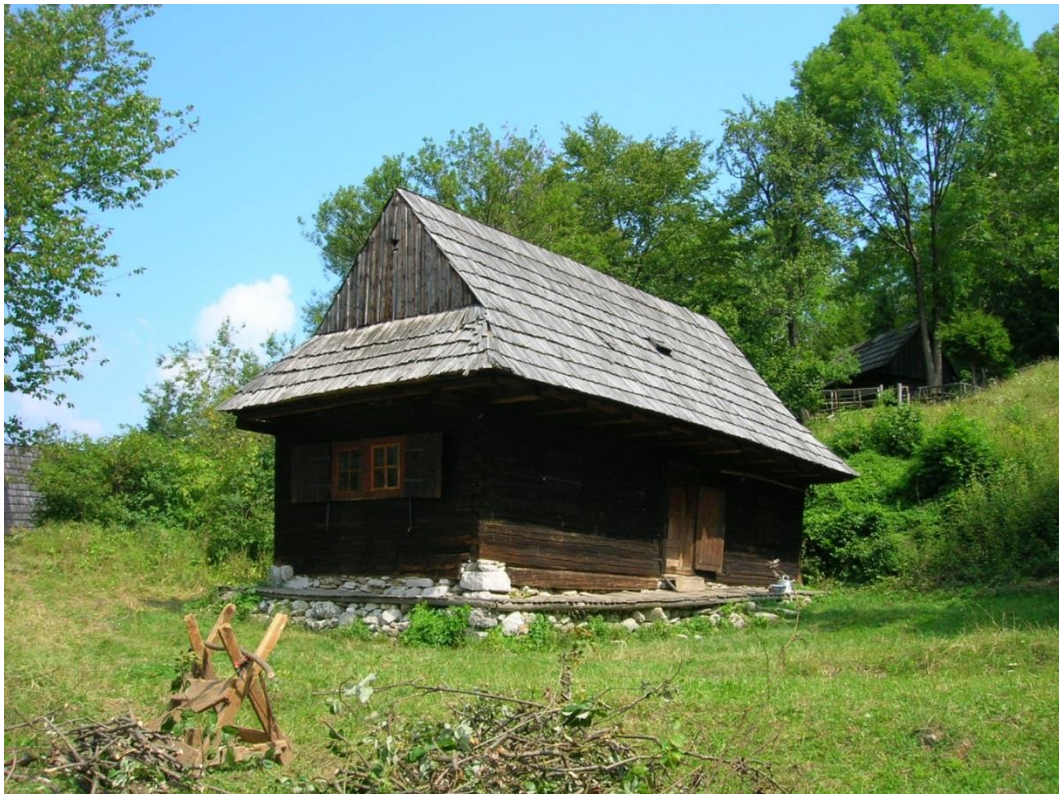
12 obytný dom č. 2, juhozápadná fasáda - objekt navrhovaný do ÚZPF
