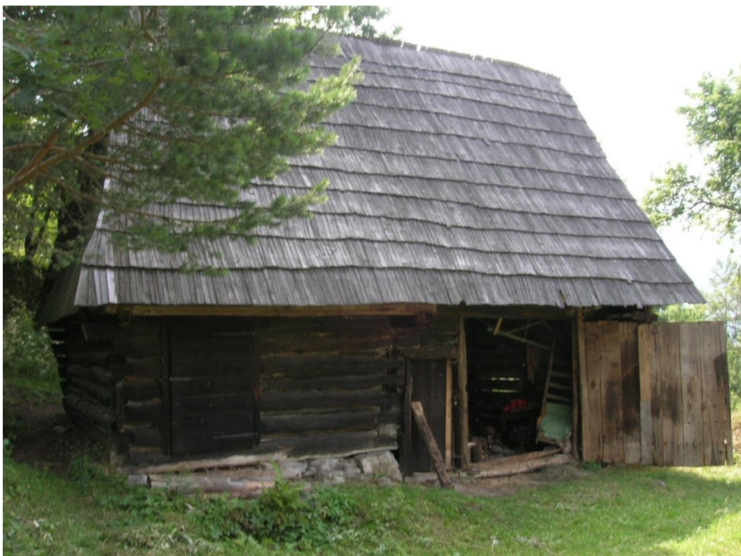
8 hospodársky objekt č.1 , severozápadná fasáda
