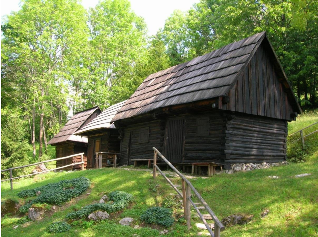
26 pôvodne hospodárske objekty č.14, 13 a 12, južné fasády
