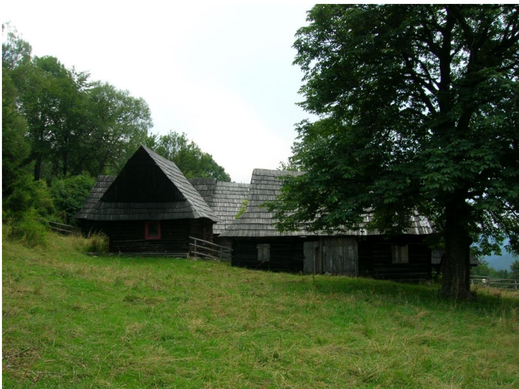
15 zástavba obytných domov č. 8 a 7, severné fasády
