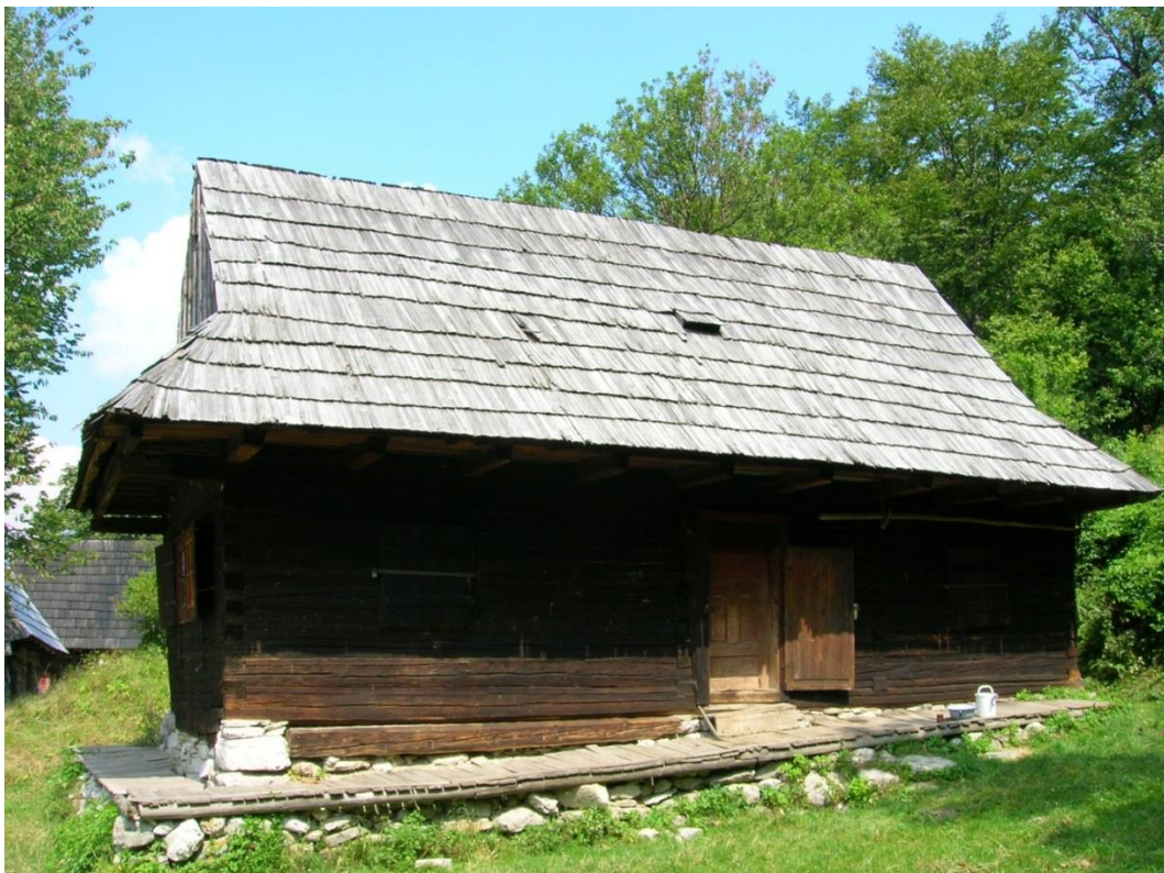
13 obytný dom č.2, južná fasáda
