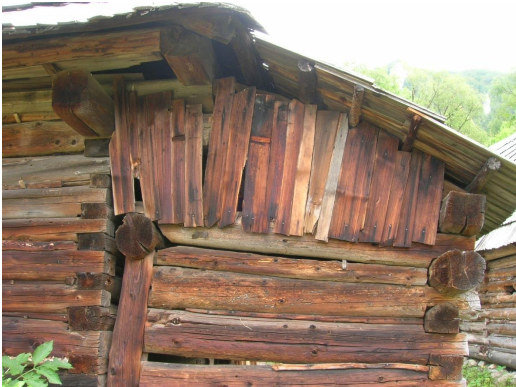
33 konštrukčný detail a úprava zrubovej steny
