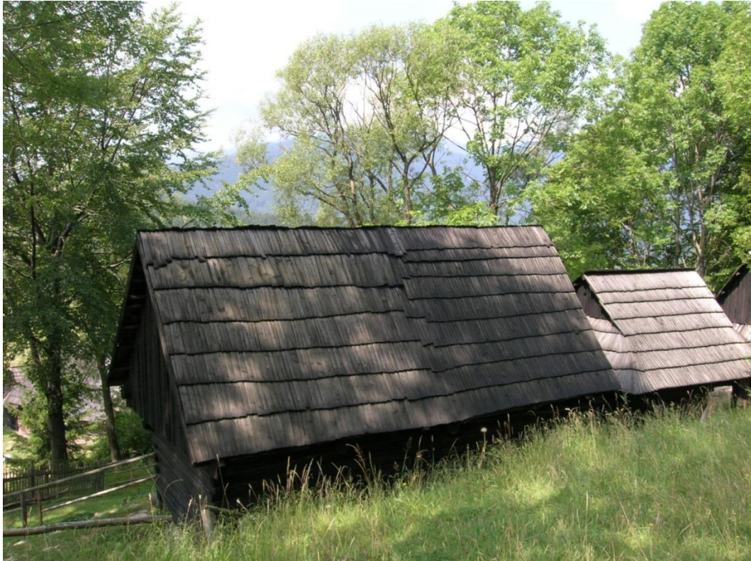
28 pôvodne hosp. objekty č.14, sedlová strecha
