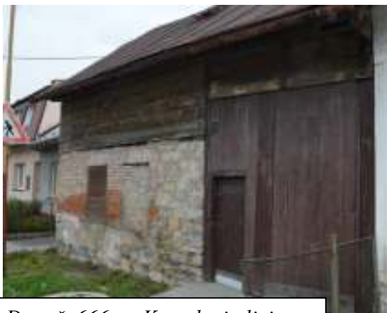
Dom č. 666 na Kostolnej ulici s podstrešným debnením
