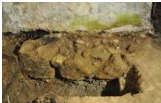
Masívne stredoveké murivo v suteréne budovy mestského múzea. Foto K. Vlaszatá
