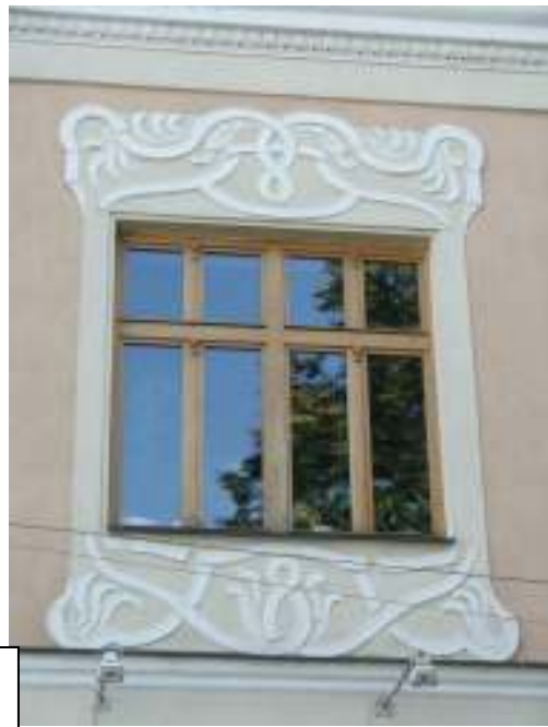
Fasáda objektu č. 17 na Námestí SNP
