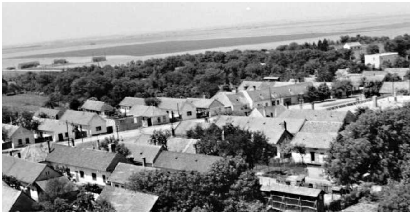
Pohľad z veže kostola na SZ, 1964
