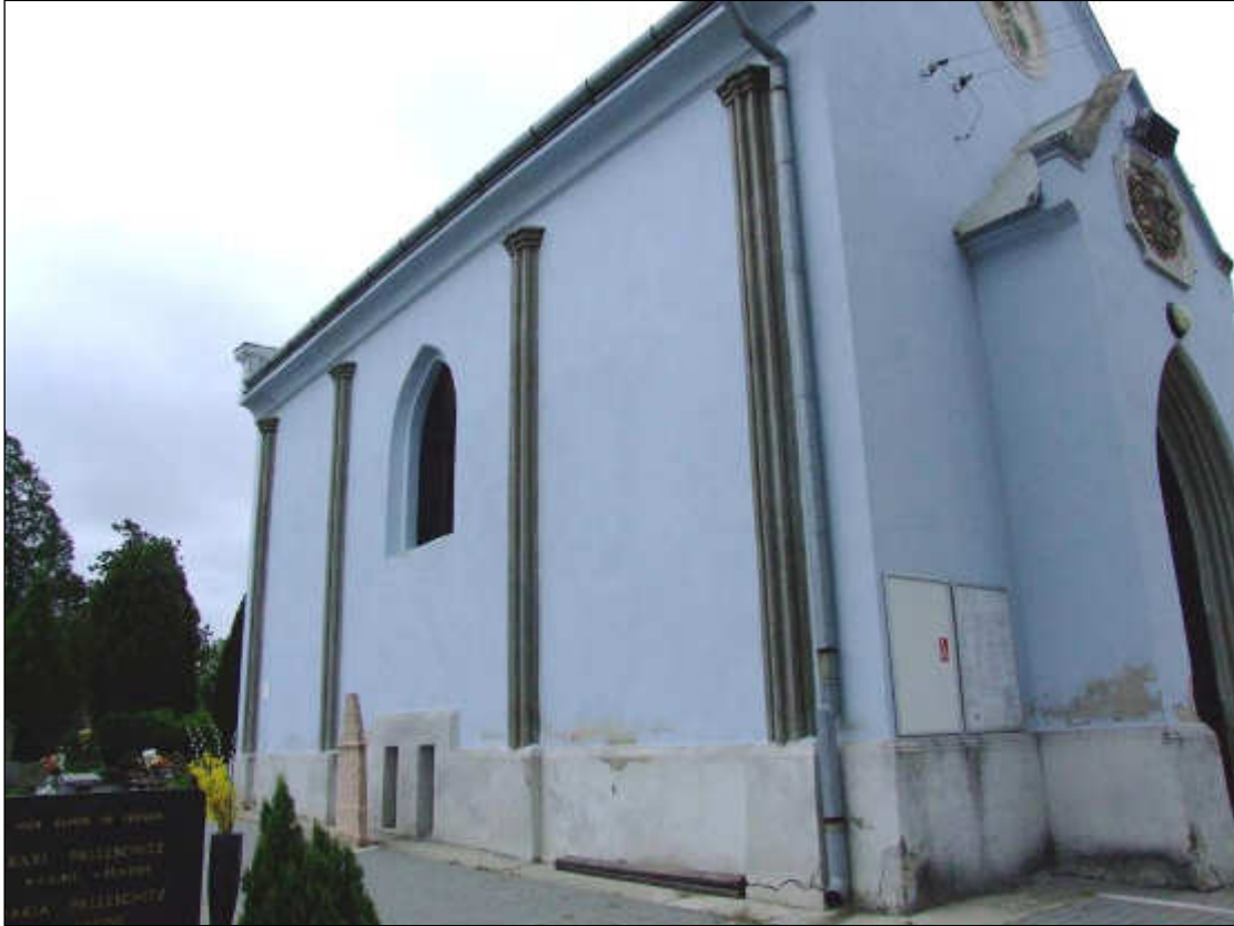
Bočný pohľad na kaplnku
