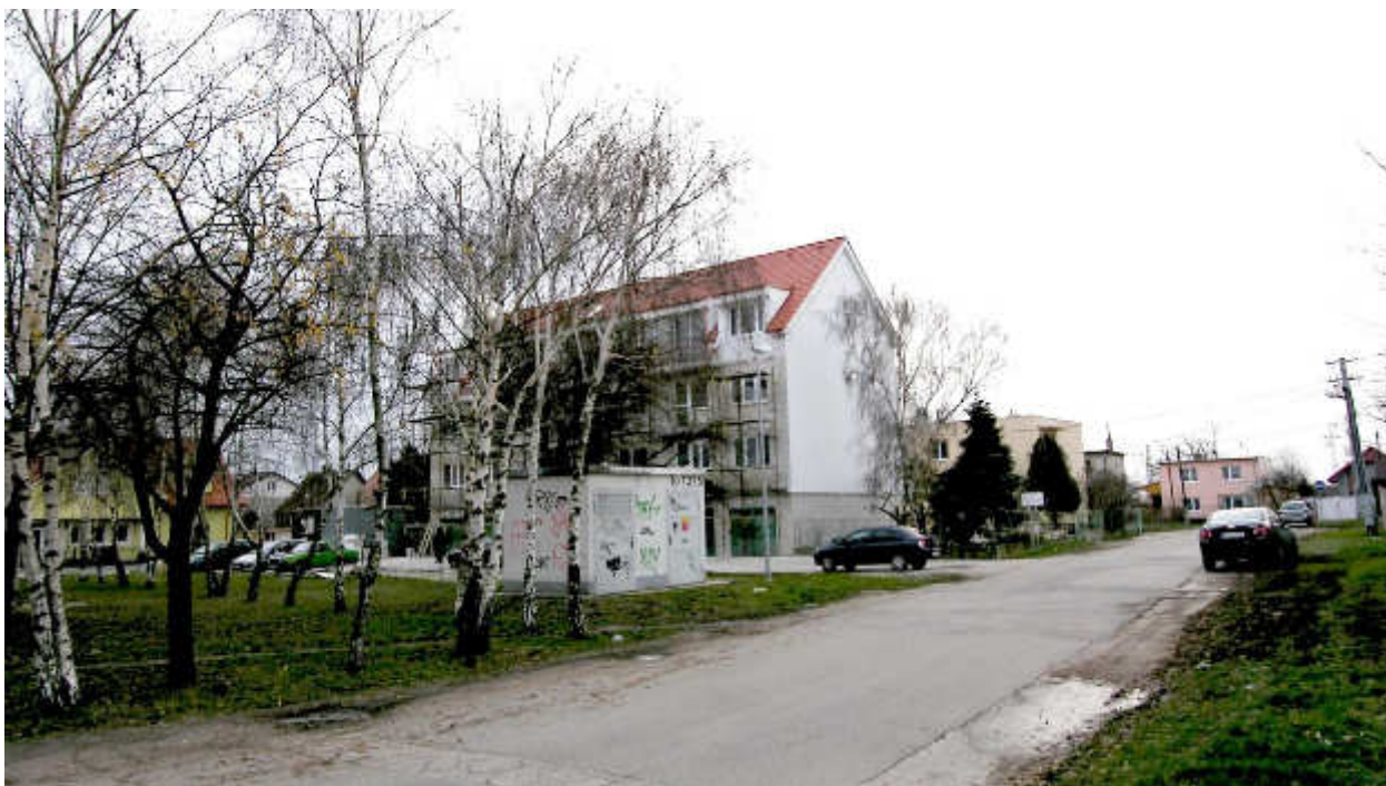
Balkánska ul., J strana, rezervná plocha R3 na mieste bývalej jazdiarne
