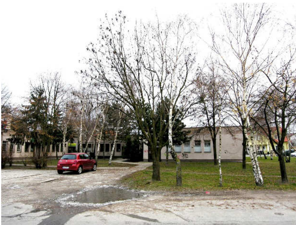
Balkánska ul., J strana, rezervná plocha R3 na mieste bývalej jazdiarne
