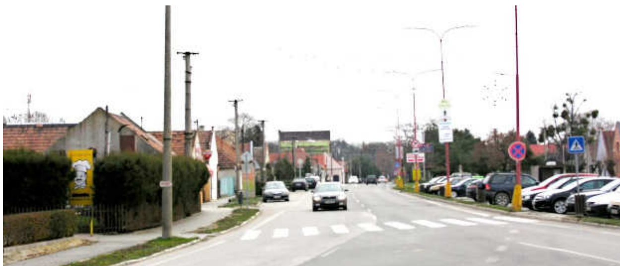
Balkánska ul, pohľad na JV 23
