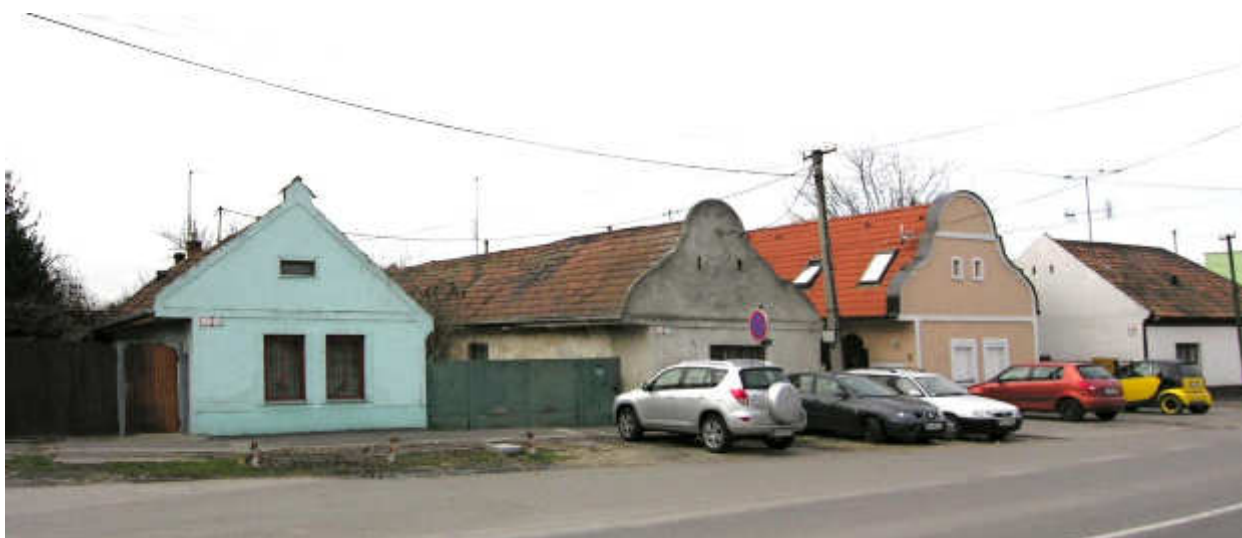
Križovatka Balkánskej ul. a Rusoveckej cesty, pohľad na JV pohľad na J, skupina troch pôvodných ľudových domov 21
