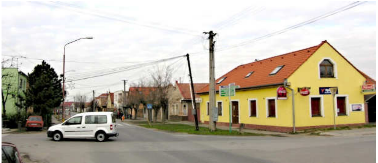
Križovatka Balkánskej ul. a Rusoveckej cesty, pohľad na JV
