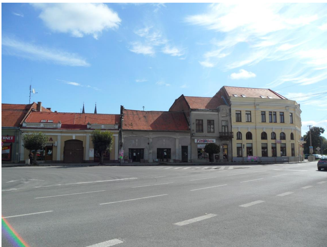
H.3.10. Hlavné námestie, časť radovej zástavby meštianskych domov.
