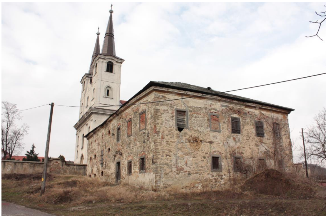
H.3.18. Kapitulska ulica, bývalý kláštorňý komplex – baroková sýpka a r. k. kostol.
