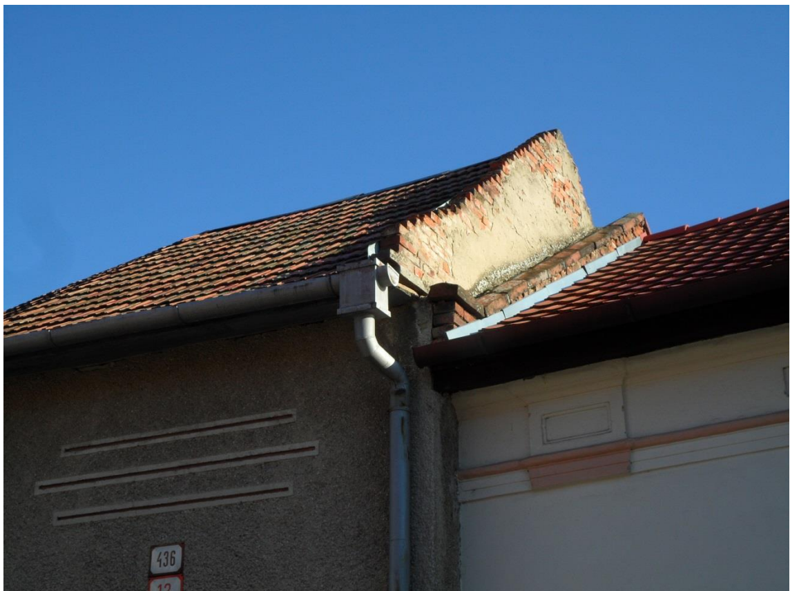
H.3.20. Ul. J. Rotaridesa, typické tehlové ukončenie štítov domov so sedlovou strechou.
