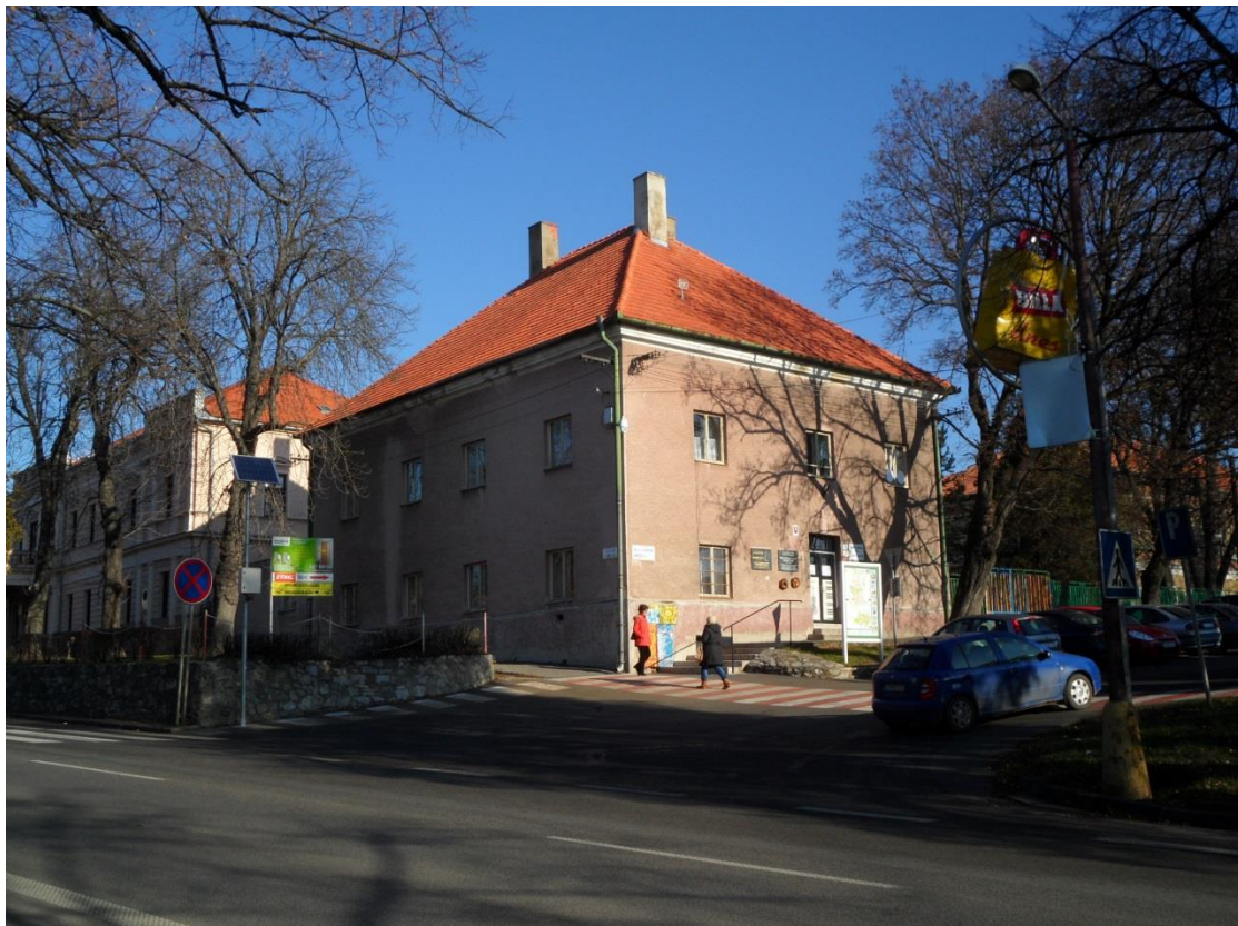
H.3.24. Ul. SNP, jedna z najstarších stavieb – baroková budova bývalého sol'ného skladu (dnes ZUŠ).
