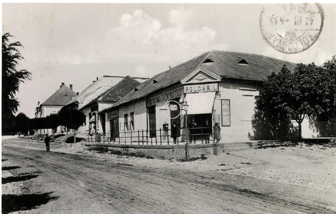
H.2.14. Nárožie dnešnej Ul. SNP a Nám. B. Bartóka, na mieste hotela Blankyt, pôvodná asanovaná zástavba – mestské tlačiarne, zač. 20 stor.
