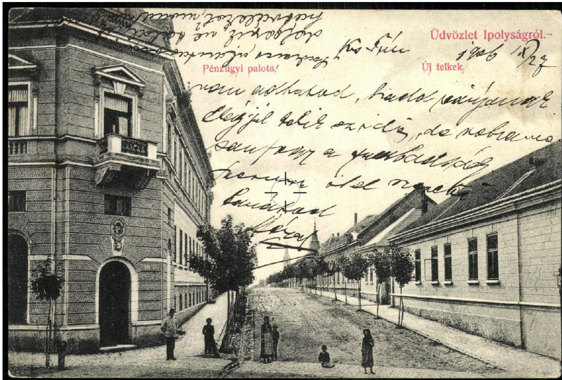
H.2.19. Ulica F. Rákocziho II., r. 1906, naľavo Sporiteľňa postavená 1900, parc. č. 1760/2
