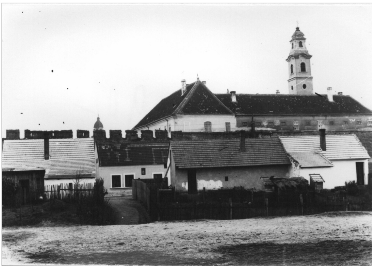
Hradby pri františkánskom kláštore, pohľad od Mýtnej, v priehľade veža farského kostola (archív PÚ SR)
