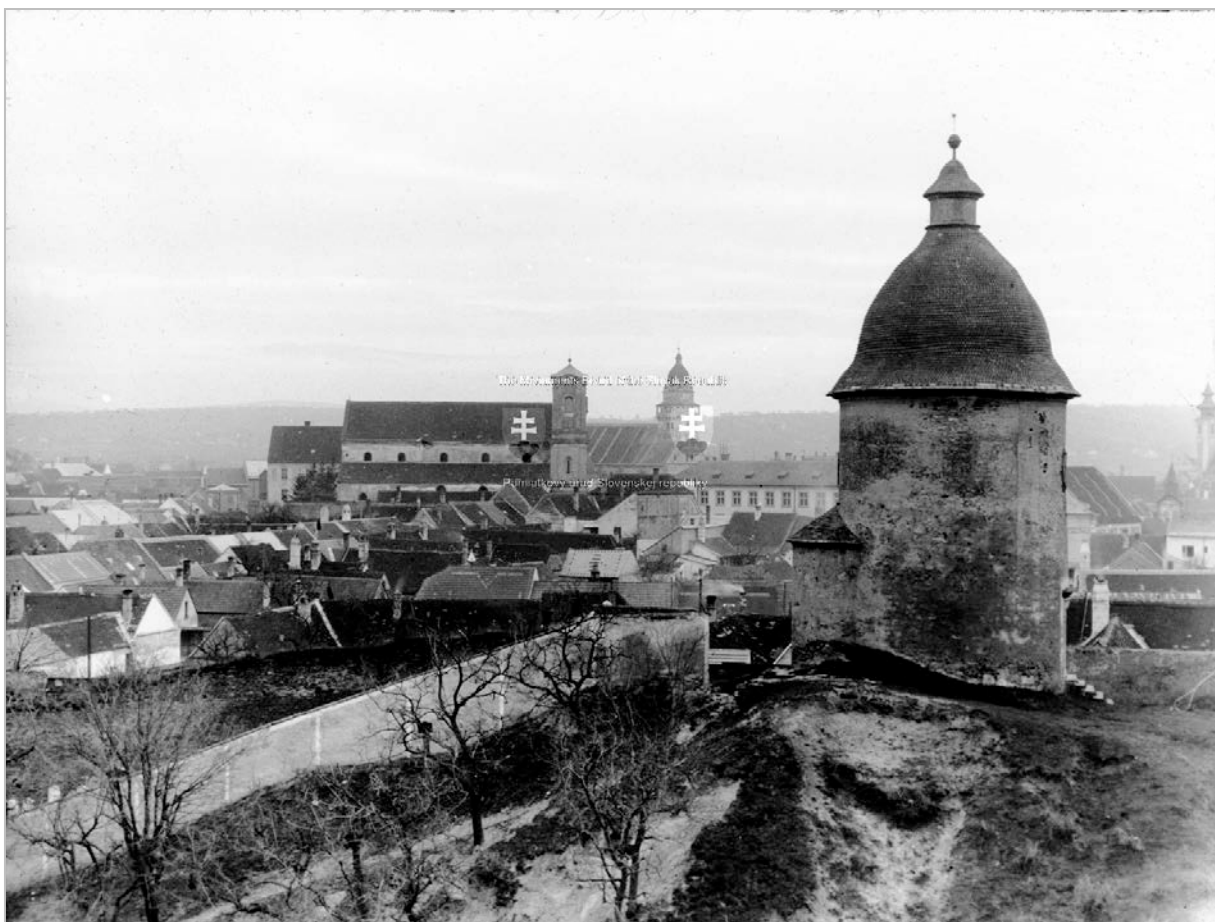
Pohľad na Skalicu z kalvárie, rotunda a časť židovského cintorína, 30.r., 20.stor., (archív PÚ SR)
