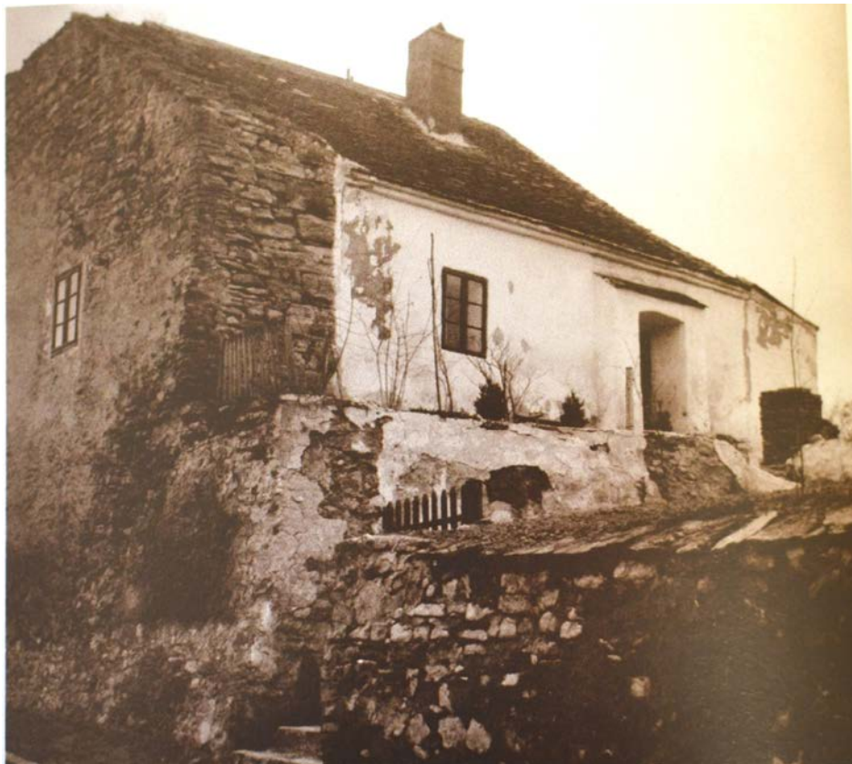
Severná veža mestského opevnenia, s pristavaným obytným domom, 40.r.,20.stor., (monografia Skalica 2014)
