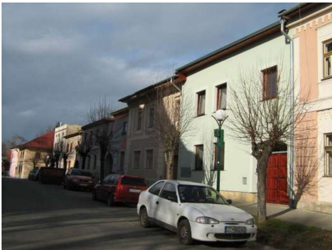
112. Štefánikova ulica č. 10 - 18 – stav v roku 2010
