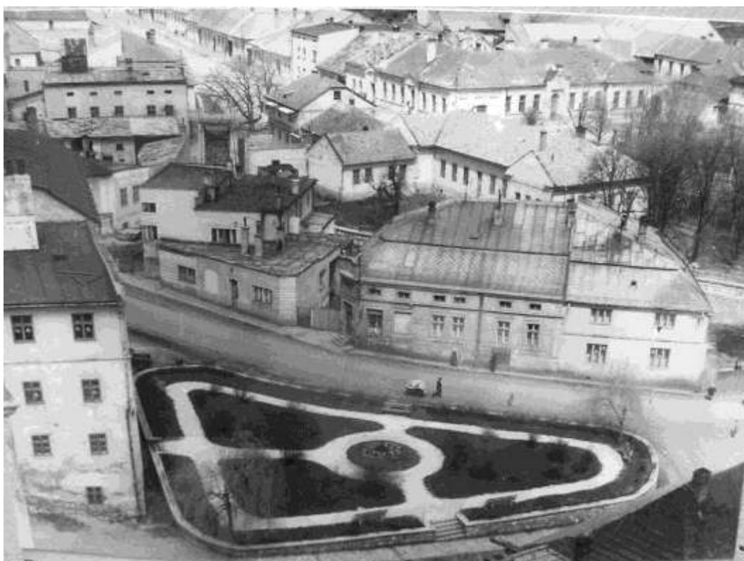
8. Úprava plochy na severnej strane mestského úradu, zaniknutá zástavba Petzvalovej ulice, vzadu objekt základnej školy na Štefánikovej ulici asanovanej v 90. rokoch 20. storočia (z kroniky mesta Spišská Belá, 60. roky 20. storočia)
