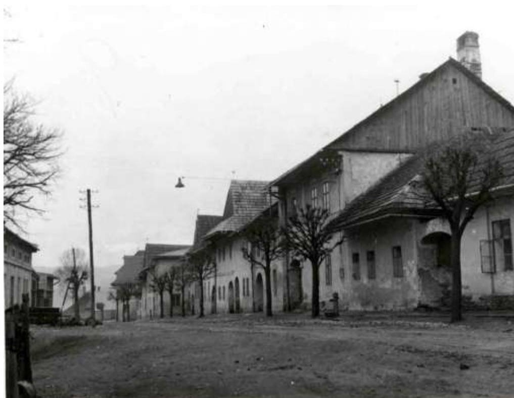
20. Z – časť Hviezdoslavovej ulice, objekty od č. 40, 50. roky 20. storočia (z archívu PÚ SR)
