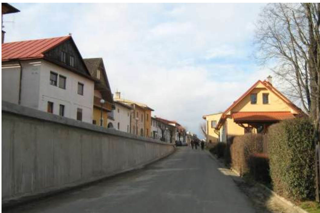
87. Hviezdoslavova ulica po č. 53, východný vstup do pamiatkovej zóny od Krížovej Vsi – stav v roku 2010
