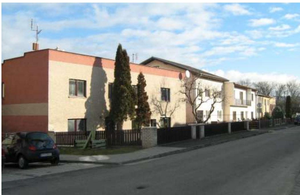
95. Petzvalova ulica 46 – 51 – stav v roku 2010
