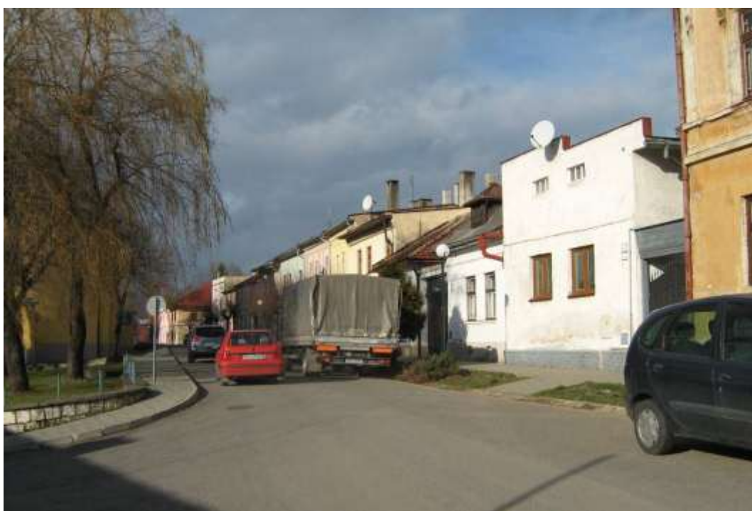
110. Štefánikova ulica č. 4 - 18 – stav v roku 2010
