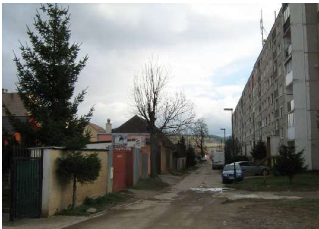
88. Západná časť Hviezdoslavovej ulice – pohľad zo západu na zástavbu pozdĺž južnej hranice pamiatkovej zóny - stav v roku 2010
