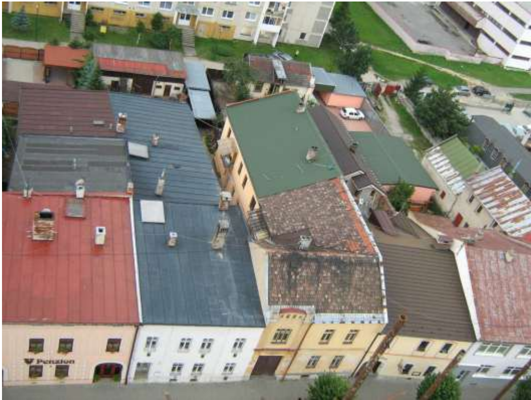
51. Strešná krajina Hviezdoslavovej ulice č. 11 – 15 – stav v roku 2010
