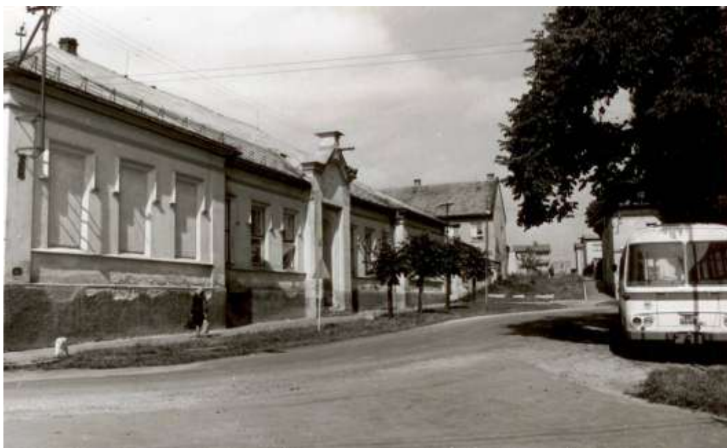
117. Areál základnej školy na Štefánikovej ulici s objektom školy asanovaným v r. 1994 – stav v roku 1984 (z materiálu KÚŠPSaOP Prešov, Spišská Belá – Rámcové zásady pamiatkovej starostlivosti pre historické jadro mesta, 1984)
