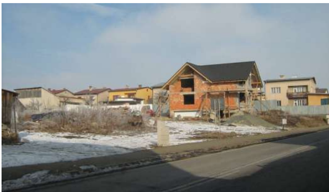
106. Novostavba rodinného domu v narušenom urbanistickom priestore (revitalizačná plocha R1) severne od Štefánikovej ulice, pri štátnej ceste v smere Bušovce – stav v roku 2010
