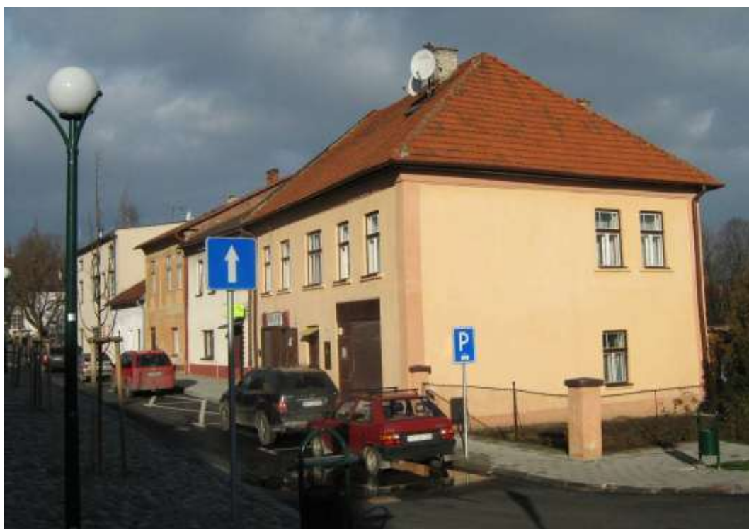
102. Petzvalova ulica č. 1 - 5 – stav v roku 2010
