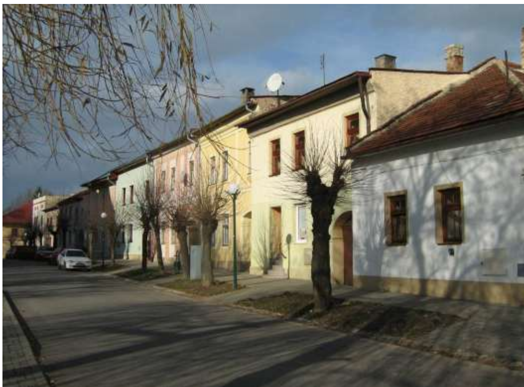
111. Štefánikova ulica č. 6 - 16 – stav v roku 2010
