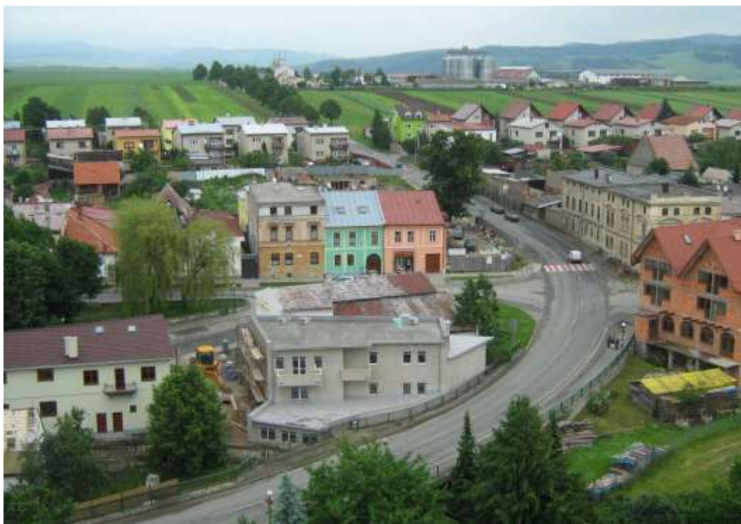
37. Hlavná cestná komunikácia v smere Stará Ľubovňa, vľavo zástavba Štefánikovej a Letnej ulice, vpravo začína Slniečná ulica – stav v roku 2010
