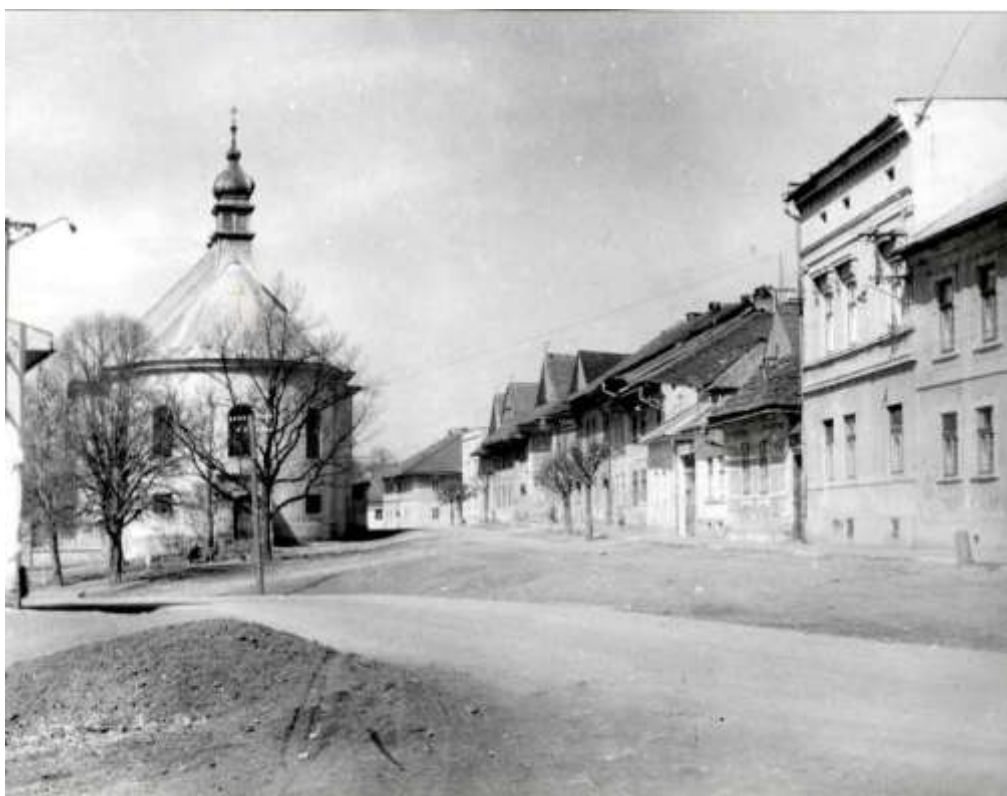
11. Z - pohľad na zástavbu Štefánikovej ulice s Evanjelickým kostolom, 50. roky 20. storočia (z archívu PÚ SR)
