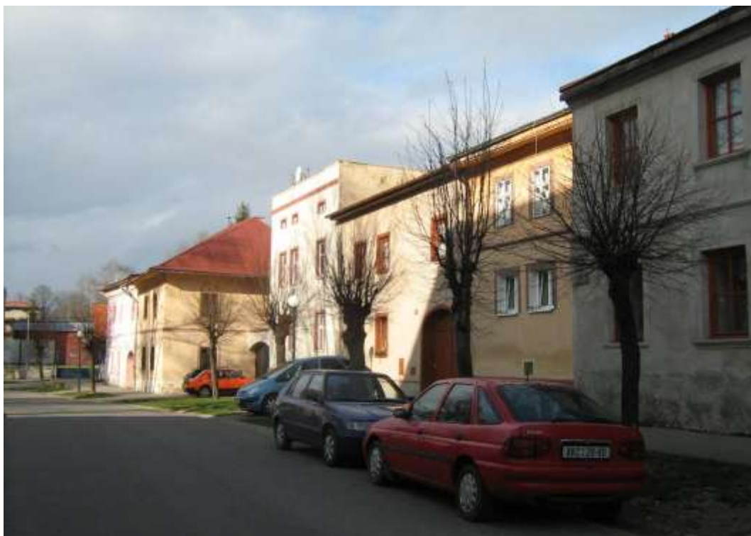
113. Štefánikova ulica č. 13 - 18 – stav v roku 2010
