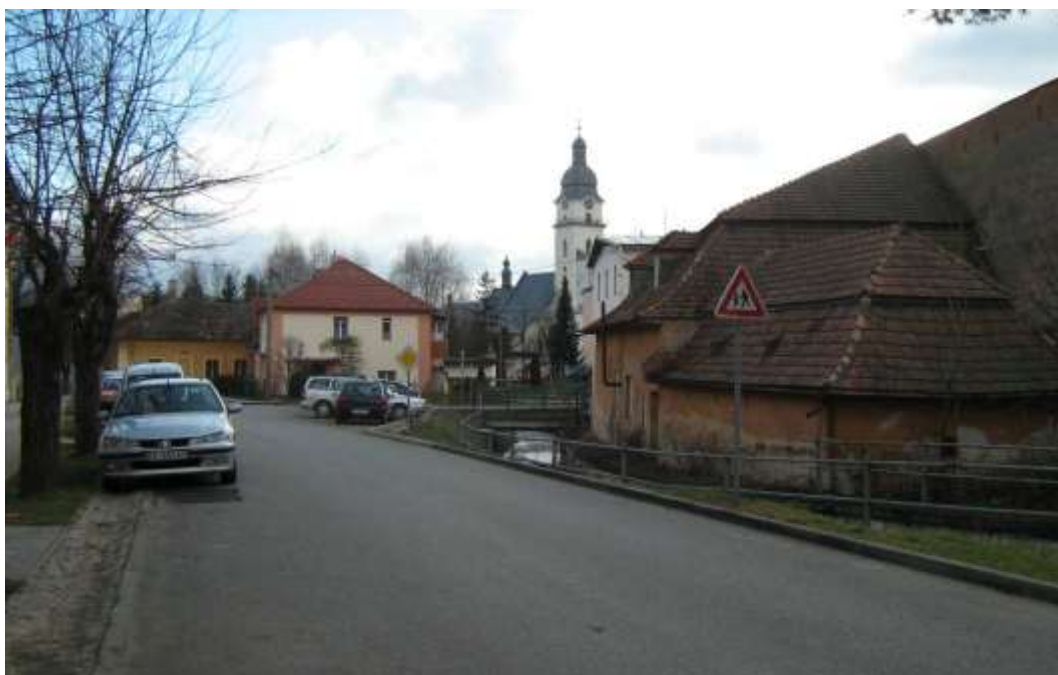
127. Pohľad zo západu na zástavbu Letnej ulice, vpravo od potoka objekty na Petzvalovej ulici, v pozadí Rímskokatolícky kostol sv. Antona Pustovníka – stav v roku 2010
