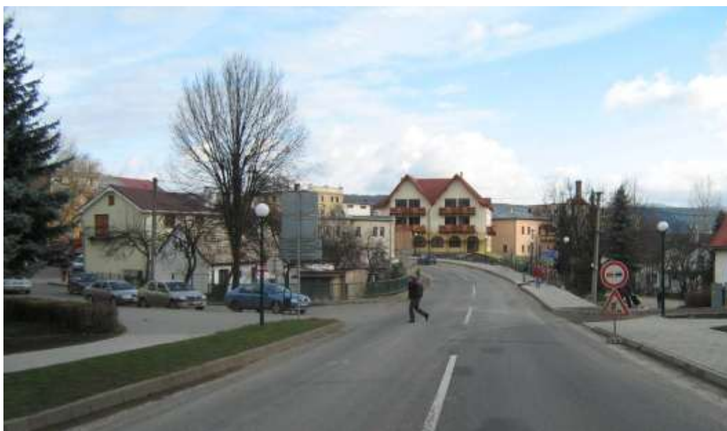
103. Hlavná cestná komunikácia v smere Bušovce - Stará Ľubovňa prechádzajúca centrom pamiatkovej zóny v pohľade zo západu – stav v roku 2010
