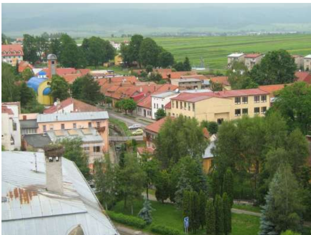
35. Pohľad na severozápadnú časť historického centra - stav v roku 2010
