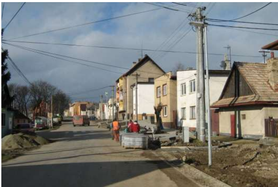
131. Pohľad z východu na radovú zástavbu Slnečnej ulice – stav v roku 2010
