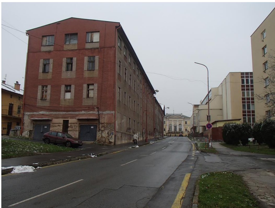
P13 – charakteristický pohľad uličného interiéru na ulici Ing. Kožucha s budovou radnice v osi uličného priehľadu
