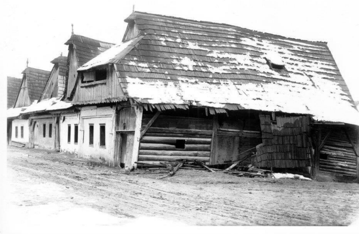
Ľudový dom spišských Nemcov so strechou na samostatnej stĺpkovej konštrukcii a s galériou v rozlomenom štíte ukončeným kabrincom a makovicou
