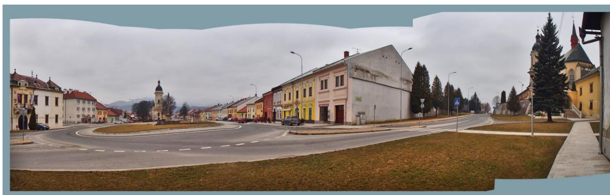
pohľad P3 – panoramatický pohľad na stred námestia spod Malého kostola / Ratuše foto: arch. R. Királ', 03.2016
