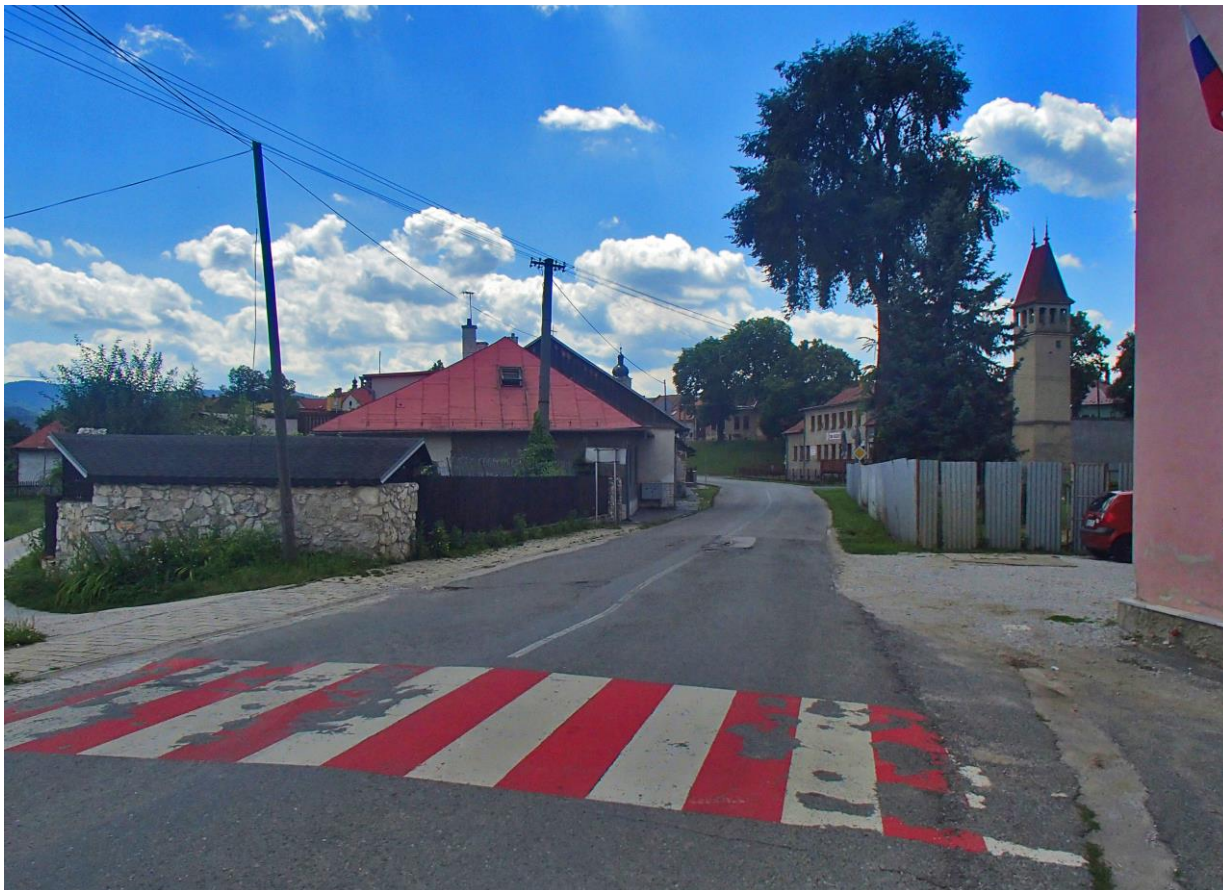
pohľad P25 - pohľad na severný záver šošovkovitého námestia aj na záver historickej zástavby na ul. SNP od budovy materskej školy foto: arch. R. Királ', 07.2016
