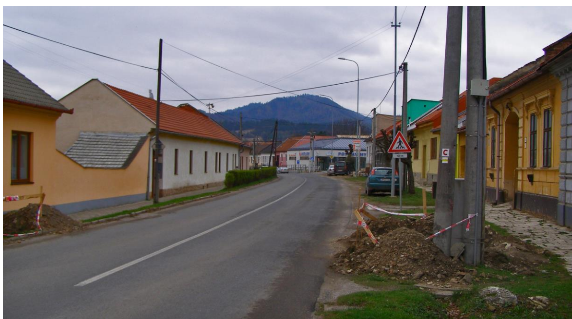
pohľad K1 - chránený priehľad Kostolnou a Železničnou ulicou na krajinný obraz - na hornatú zalesnenú krajinu pohoria GALMUS (v strede s dominujúcim vrchom KOBÝLA - 847 m n. m.) - uličný priehľad spolu tvorí hodnotný uličný interiér tvorený historickou obojstrannou radovou zástavbou v kontakte s PZ na Železničnej ulici foto: arch. R. Királ', 10.2015 a 04.2016
