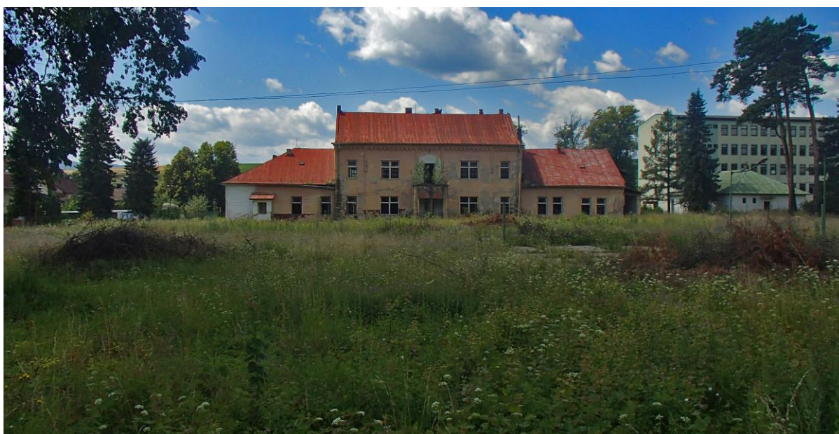
pohľad P26 - pohľad na os priečelia budovy bývalého sirotinca od cesty do Dobrej Vôle foto: arch. R. Királ', 7.2016
