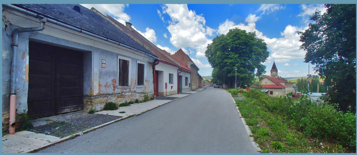
pohľad P14 - uličný pohľad na domoradie horného konca Požiarnickej ulice (or. č. 56-60), na požiarňu zbrojnicu a severnú zástavbu ul. SNP (or. č. 1-10) foto: arch. R. Királ', 7.2016
