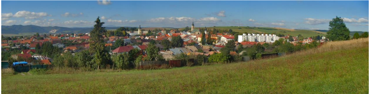
pohľad P1 - panoramatický chránený diaľkový pohľad na PZ SpV od východu - z lúky nad záhradami domov Vajanského ulice foto: arch. R. Királ', 10.2015
