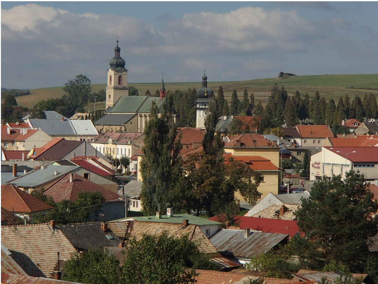
pohľad P1 (a) - detail na strešnú krajinu v strednej časti PZ, kultúrny dom, farský a Malý kostol - v pozadí mestský cintorín a za ním lúky tzv. Farskej dolky foto: arch. R. Királ', 10.2015
