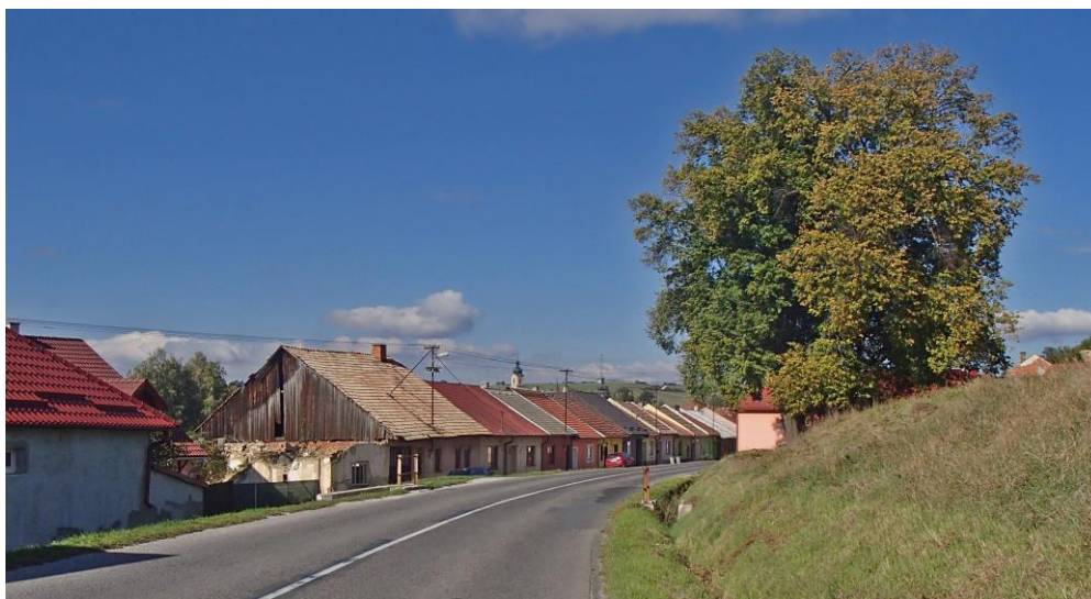
prieťah pB - chránený uličný prieťah na PZ SpV z VAJANSKÉHO ulice - pri vstupe do historickej časti mesta - vpravo štyri lipy a prícestný kríž - v osi prieťahu veža farského kostola foto: arch. R. Királ', 10.2015
