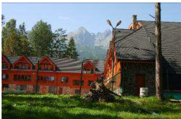
118. Pohľad JV na apartmány
