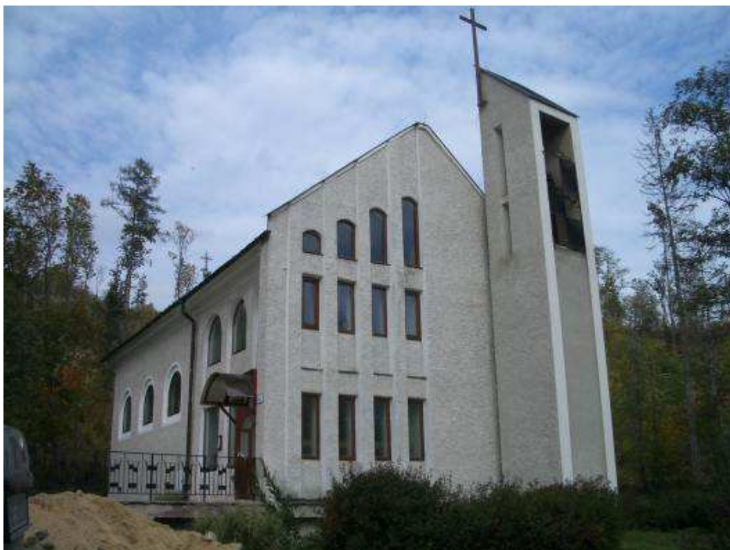
76. Rímskokatolícky kostol - pohľad JZ s prístavbou z roku 1969 - 2006
