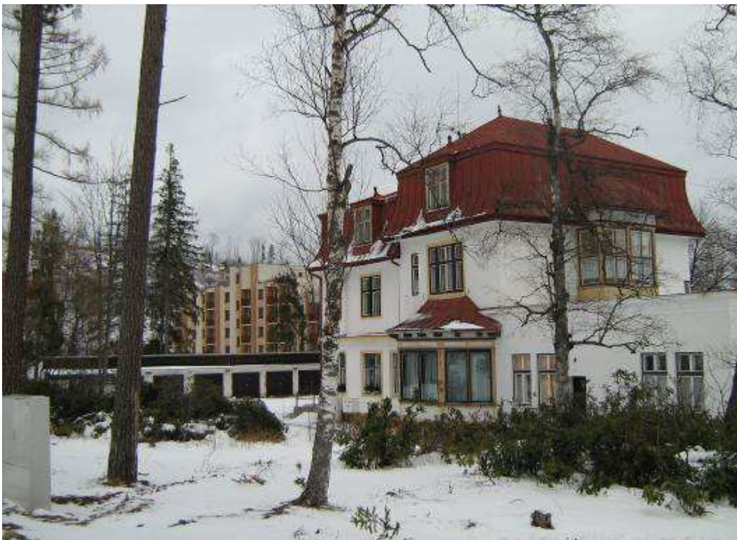
44. Stará Morava verus garáže a Hotel Slovan – pohľad JZ
