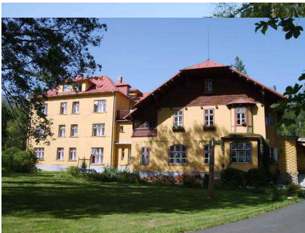
72. Penzión Bělín - pohľad južný s prístavbou z roku 1931 – 2006
