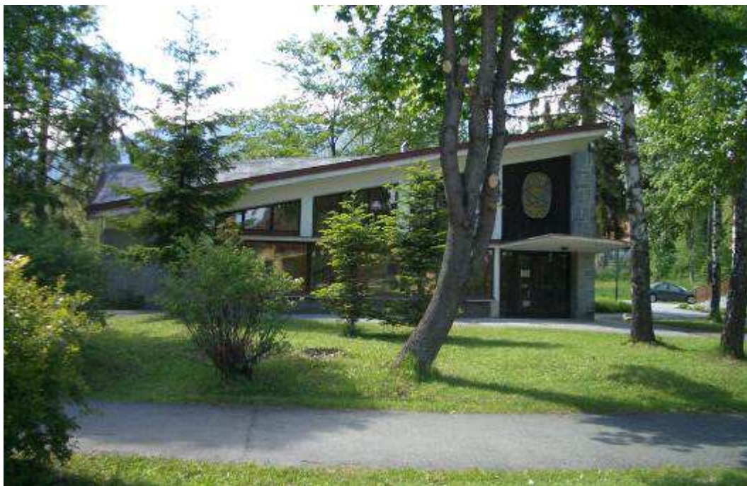
104. Predajňa ÚĽUV - pohľad JV – 2006
