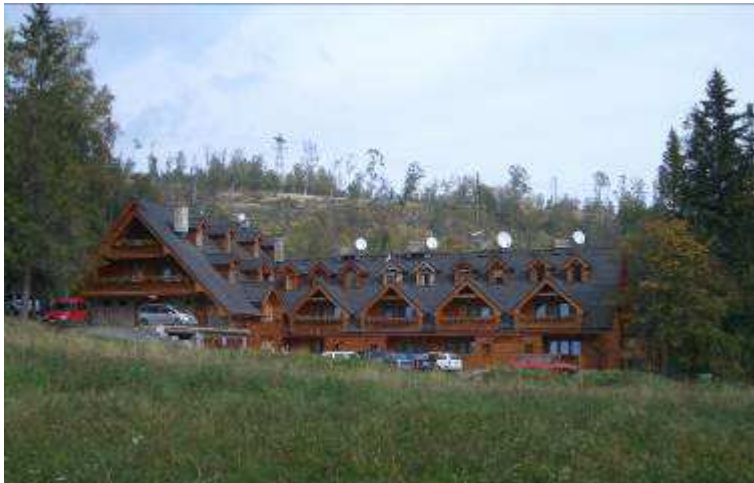
117. Apartmánový komplex - pohľad JZ
