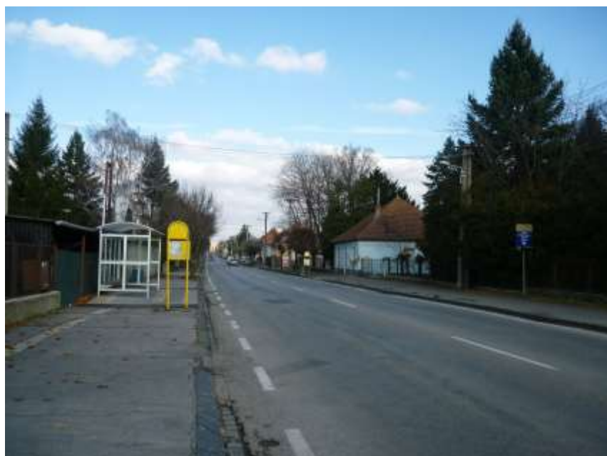
5.4.18. vnútorný pohľad č. 10 z mosta nad potokom Chotina
