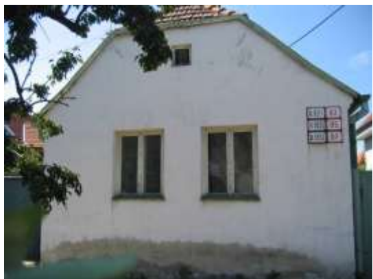
č. 93-95-97- 2 (1) štít s polvalbou a okná s prvoradým zabezpečením údržby a prípadne opravy poškodených častí.
