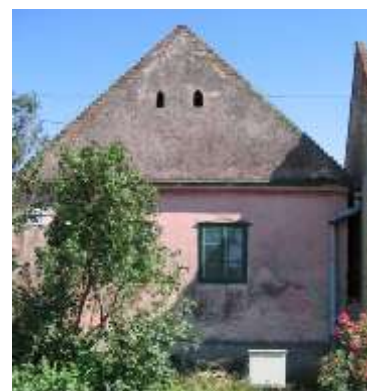
č. 294-6 (1), č. 88-90 (2), č. 160-162(3) – zachované tvarovanie zdvojených a dvojitého okna, rímsa a štít s vetracími okienkami, kde je pri oprave potrebné prvky zachovať a okná podľa potreby vymeniť za tvarovo a členením podobné.
