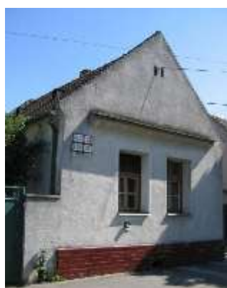
č. 294-6 (1), č. 88-90 (2), č. 160-162(3) – zachované tvarovanie zdvojených a dvojitého okna, rímsa a štít s vetracími okienkami, kde je pri oprave potrebné prvky zachovať a okná podľa potreby vymeniť za tvarovo a členením podobné.
