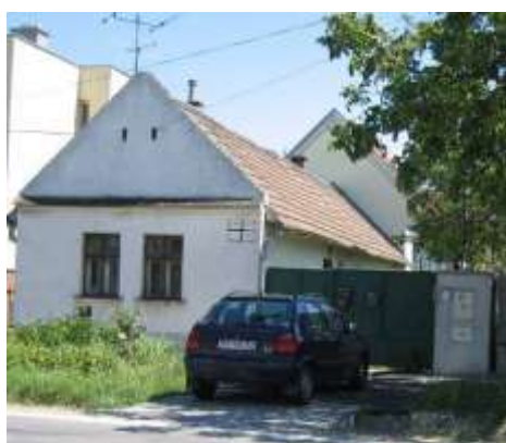
č. 294-6 (1), č. 88-90 (2), č. 160-162(3) – zachované tvarovanie zdvojených a dvojitého okna, rímsa a štít s vetracími okienkami, kde je pri oprave potrebné prvky zachovať a okná podľa potreby vymeniť za tvarovo a členením podobné.
