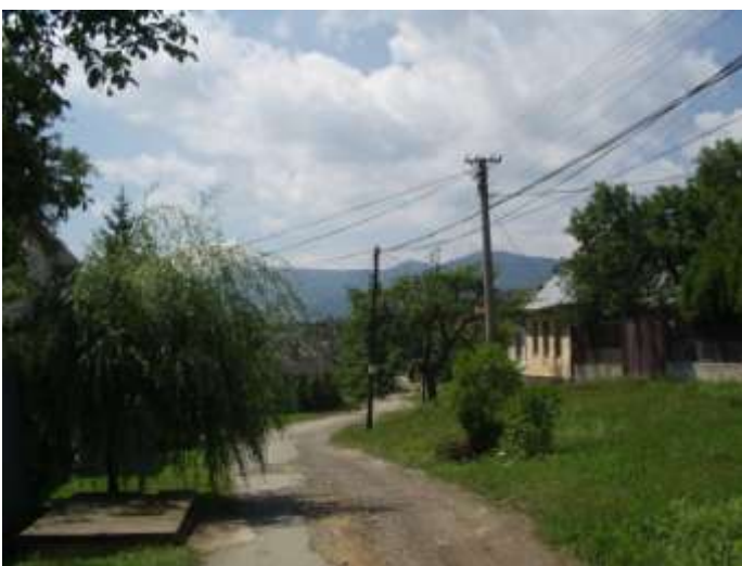
5. Vzdušné elektrické rozvody sú v pamiatkovom území rušivým prvkom.
