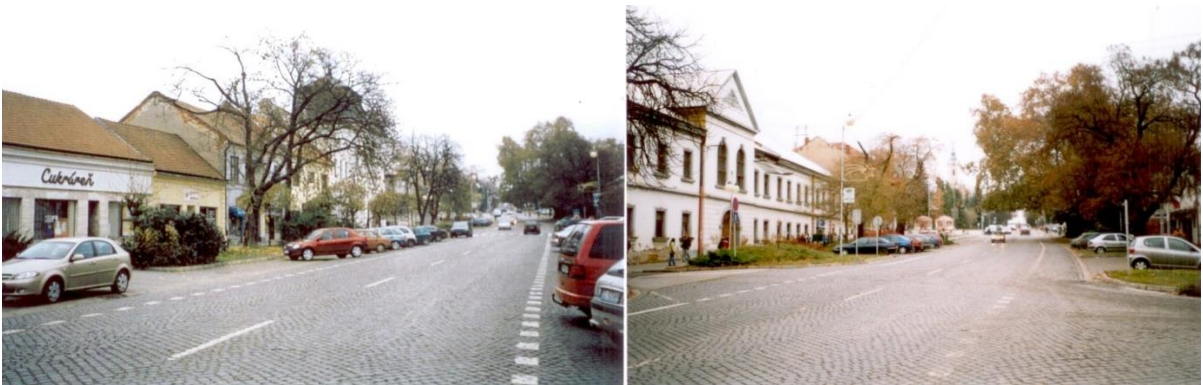
8. Vnútrotný pohľad č. 2, pokračovaním po Župnej ulici, pri Ul. Sama Chalúpku sa otvára pohľad zachytávajúci zástavbu Župnej ulice s architektonicky hodnou budovou banky (EL č. 54) a hmotovo dominantným župným domom (EL č. 59).
